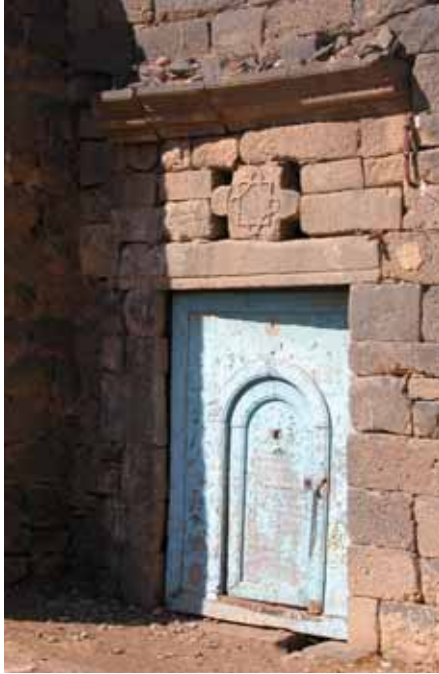
La réutilisation des matériaux pierreux anciens : Bosra (Syrie).
