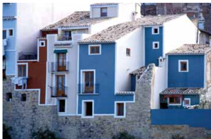
La réhabilitation urbaine, récupération des crépis de couleur, Villajolosa (Espagne).
