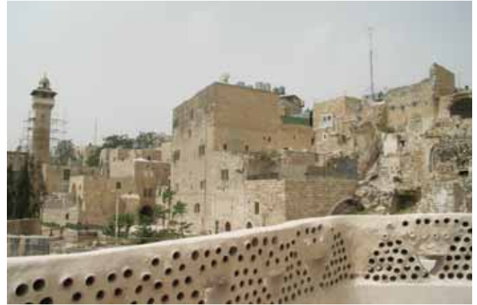
Récupération d'un rebord qui permet la ventilation dans une terrasse d'Hébron (Palestine).
