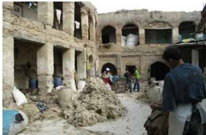
Connaitre l'endo-contexte facilite la compréhension du bâtiment dans sa totalité. En outre, cela aide à comprendre pourquoi deux bâtiments réalisés à la même époque et dans la même rue peuvent être différents.
