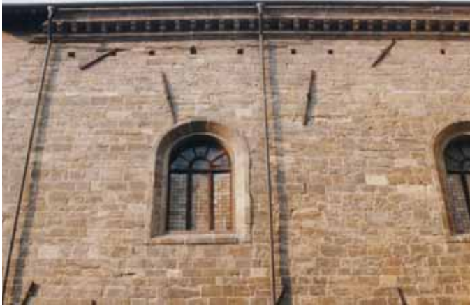
6. Utilisation de tirants dans un bâtiment à Bergame, Italie.
