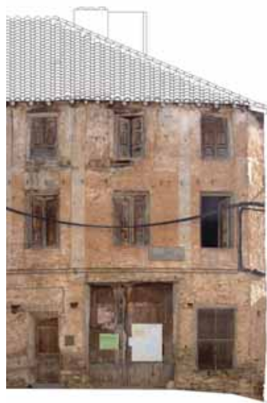
Les photoplans constituent une technique d'une grande utilité parce qu'ils recueillent non seulement les données métriques mais aussi la couleur, la texture, les dégradations, etc. Ancienne auberge de routiers à Torrebaja (prov. de Valence, Espagne)
