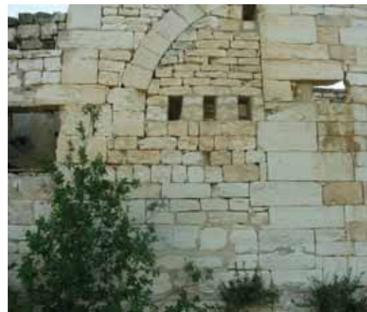
Relevé visuel préliminaire (maison Debbané, Salhiyeh)
