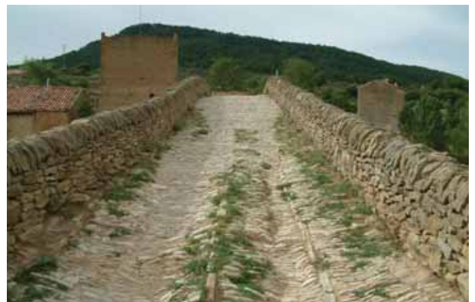
Restauration d'un dallage avec des critères de distinction et, parallèlement, d'intégration parmi les éléments préexistants.
