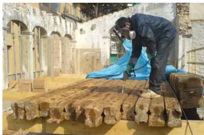
Pulvérisation de poutres de bois anciennes avant leur remise en œuvre.
