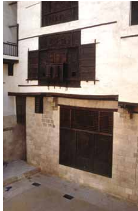
Façade nord de la cour restaurée, avec pierres anciennes, dans la maison Harawi, Le Caire, Égypte.
