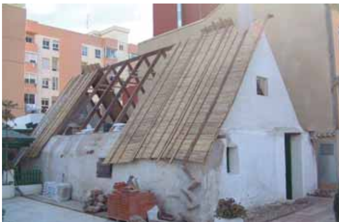
Substitution de la couverture végétale d'une baraque après un incendie dû au vandalisme. Baraque La Genuina à Pinedo (prov. de Valence, Espagne).
