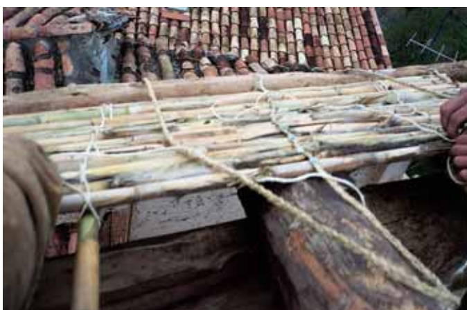
Les critères envisagés dans le projet doivent être maintenus et appliqués dans la mise en œuvre, qui constitue la véritable épreuve du feu de ces idées de départ. Maison traditionnelle à Sesga (prov. de Valence, Espagne).
