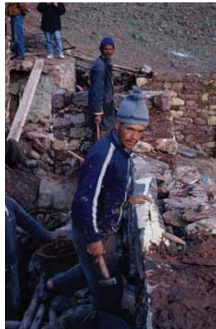
Dans le Haut Atlas marocain, la pierre est toujours utilisée pour la construction des bâtiments. Teluet (Maroc).
