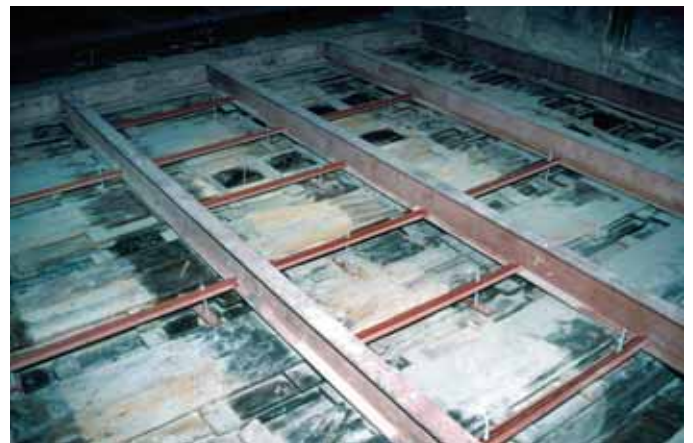
Emploi de matériaux nouveaux (poutres métalliques) pour le renfort des structures anciennes, Le Caire, Egypte.
