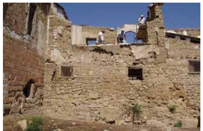
Sur le mur d'un manoir médiéval près de Nicosie on reconnaît la maçonnerie originale en pierre taillée rougeie par l'incendie du 15 e siècle notée par les chroniqueurs de l'époque et la maçonnerie en moellons brutes et briques de terre crue de la période ottomane
