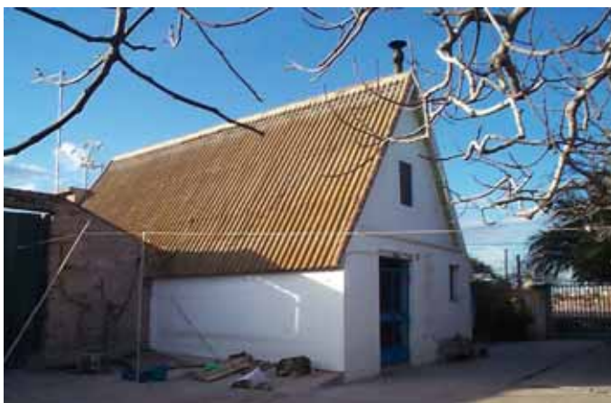
Bien que cela ne soit pas recommandable, il est toujours préférable de substituer la couverture végétale dans un bâtiment par un autre type de couverture du marché avant de démolir complètement le bâtiment. Baraque Ricart-Navarro à Pinedo (prov. de Valence, Espagne).
