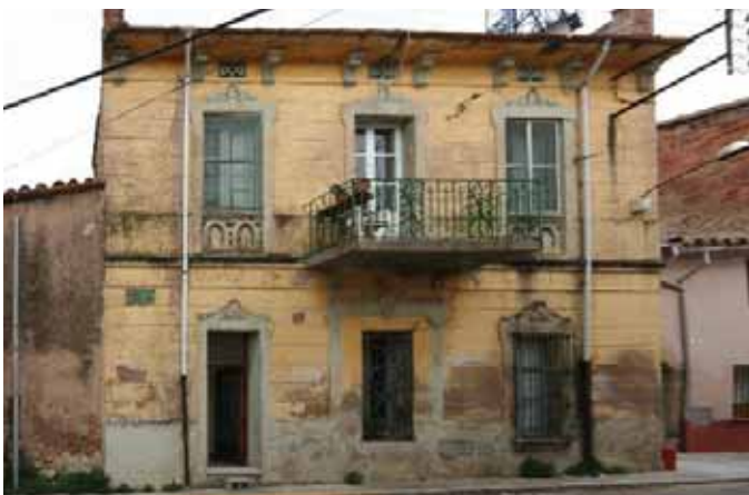
Photographie de la même façade une fois rectifiée.
