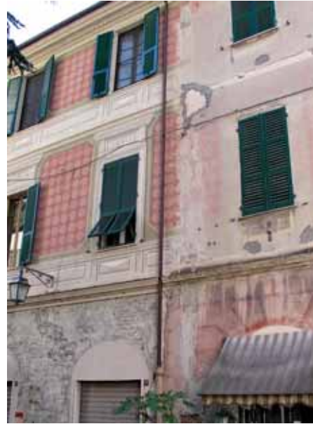
L'architecture traditionnelle est extrêmement vulnérable aux pressions du monde contemporain. Sa réhabilitation implique un soin tout particulier afin de ne pas endommager ses valeurs. (Zuccarello, Italie)
