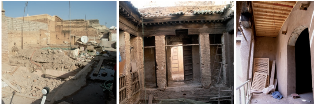
Pendant les travaux
