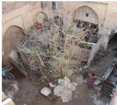
Pendant les travaux
