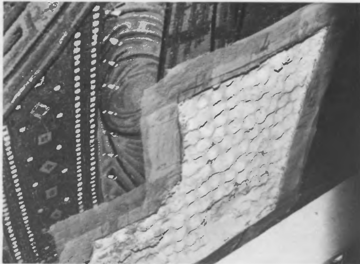
Fig. 2. - Primo strato di malta con intaccature intenzionali.
