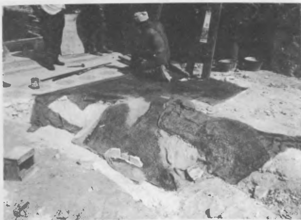
Distacco con taglio e rinforzo a filo delle tessere per inconsistenza del sottofondo.
