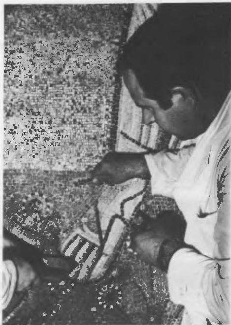
Fig. 3. - Rimozione della tessera musiva nel punto scelto per l'iniezione.
