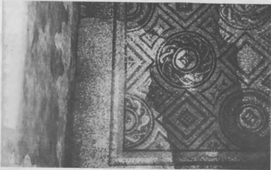
Aquileia, Chiesa di Monastero, integrazione dell'angolo nord-ovest del mosaico con sottofondo in cocciopesto e malta di calce spenta sul posto.
