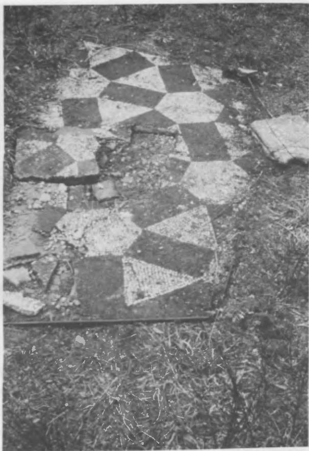
Fig. 6 Ostia, Castel Fusano, Villa di Plinio. Altro esempio di restauro a blocchi grandi e soletta in cemento e tondini di ferro. La figura mostra in modo evidente il grave dissesto subito dal mosaico a causa della reattività di cemento e ferro agli agenti atmosferici e all'azione delle erbe infestanti, cui la mancata manutenzione ha dato libera crescita. Questo mosaico e' stato restaurato nel 1975!
