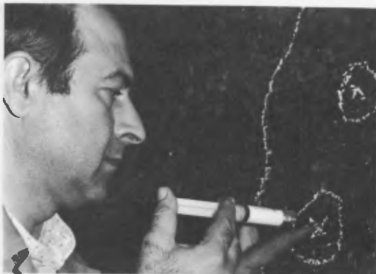
Figure 3. Prima di iniziare il consolidamento, si inietta acqua ed alcool. Questa soluzione serve per eliminare i residui di malta polverizzata, del salnitro e di altre sostanze depositatesi nel corso dei secoli fino ad un lavaggio a rifiuto.
