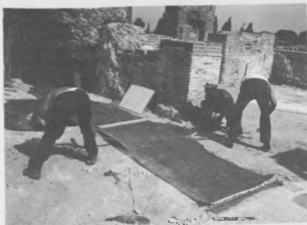
Distacco con taglio e rinforzo a filo delle tessere per inconsistenza del sottofondo.
