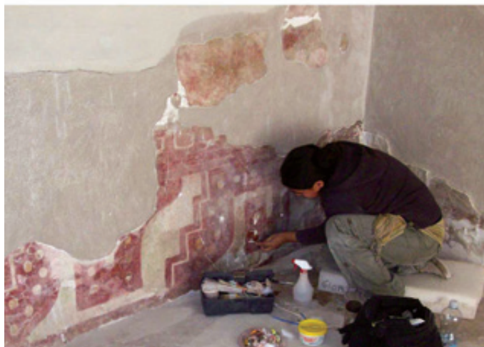
Trabajos de conservación arquitectónica y de pintura mural en el Conjunto arquitectónico Quetzalpapálotl. Fotografías de Aldo Díaz Avelar
