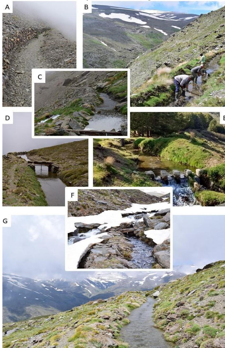
A) Acequia de careo without water to carry out repair works. B) Members of Bérchules' irrigation community clearing an acequia de careo. C) Aliviadero on the side. D) Aliviadero overflow and flow limiter. E) Partidor of acequia de careo of the Poqueira ravine. F) Water catchment for an acequia de careo. G) Acequia de careo of Bérchules.
