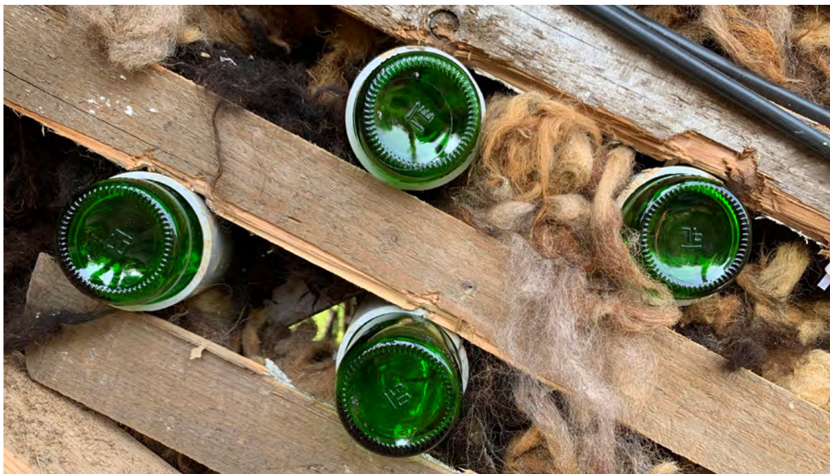
تصویر شماره ۱۰: یک مدول از نورگیر در حین اجرا.
