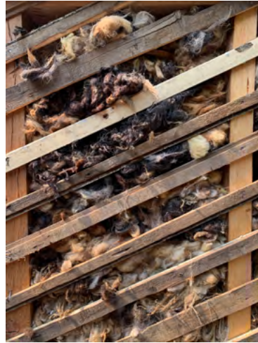
تصاویر شماره ۱۶ و ۱۷: استفاده از پشم به عنوان عایق حرارتی.
