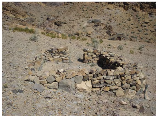
تصویر شماره ۱۸: دیواره سنگی خشکه‌چین یک نمونه گنبه.
