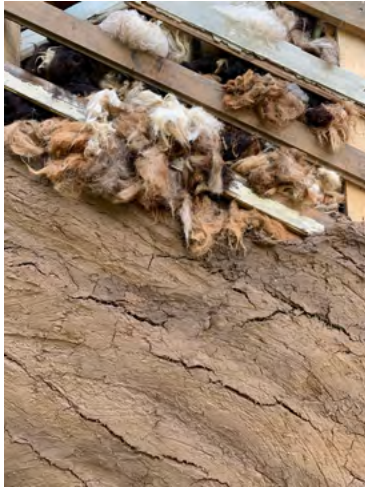
تصاویر شماره ۱۶ و ۱۷: استفاده از پشم به عنوان عایق حرارتی.
