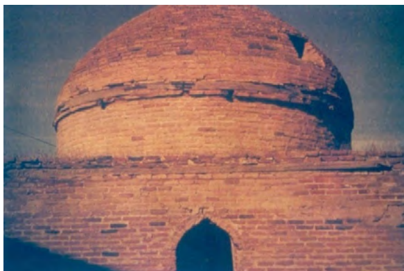
تصویر شماره ۱۱: کلاف چوبی گنبد امامزاده‌ای در نمین. مأخذ: آرشيو دکتر فخار تهرانی.
