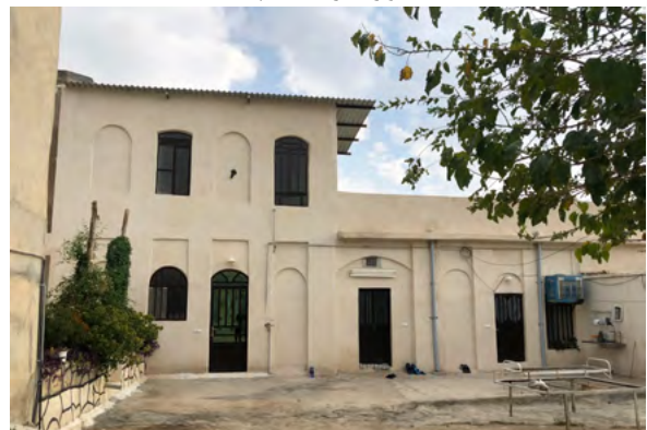
تصویر شماره ۳۸: پنجره درونی.
