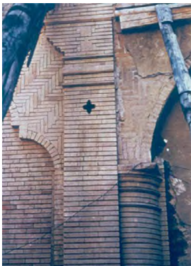
تصویر شماره ۱۴: انواع مشتی در کاروانسرای میانداشت بر مبنای تراش و همچنین پیمون آجر. مأخذ: آرشیو دکتر تهرانی.
