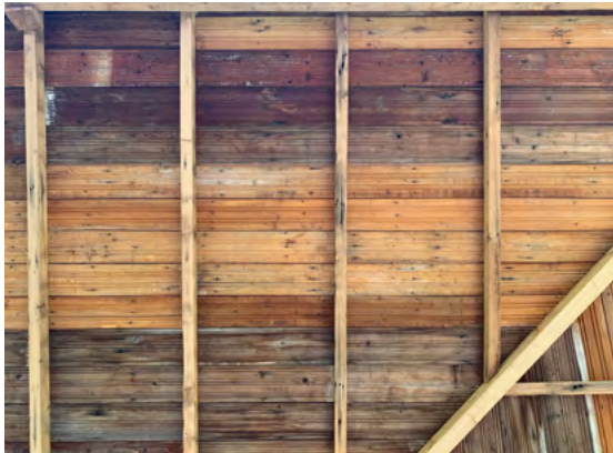
تصویر شماره ۲۰: پوشش پوسته زیرین نفار.
