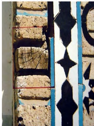
تصویر شماره ۱۵: استفاده از چوب در نازک کاری.
