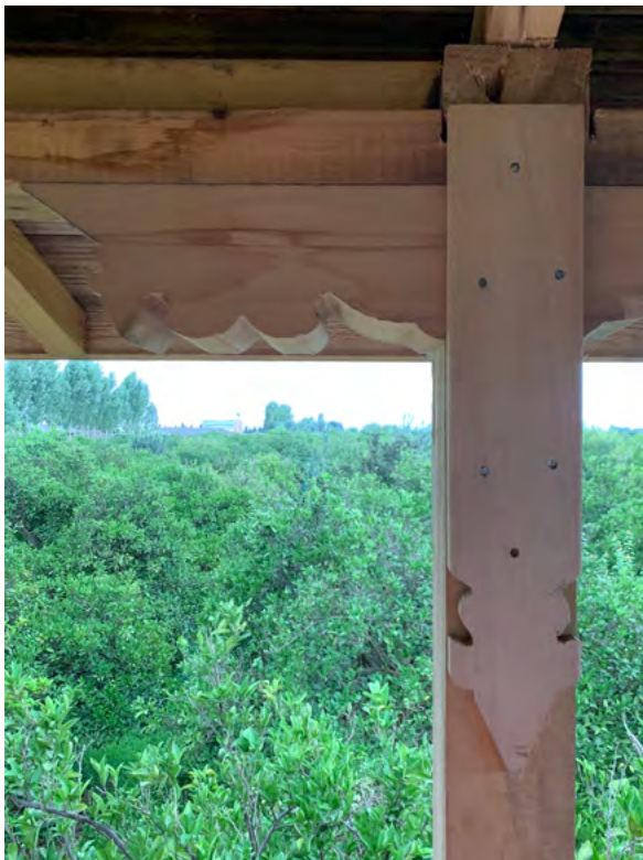
تصویر شماره ۱۴: کماچه و اتصال آن به ستون.
