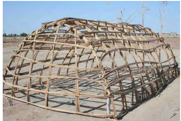
تصویر شماره ۱۶: نمایی از یک کپر در دست ساخت.
