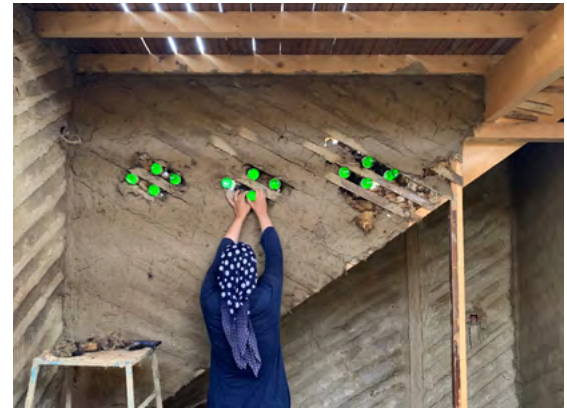
تصویر شماره ۲۱: نصب نورگیرها.
