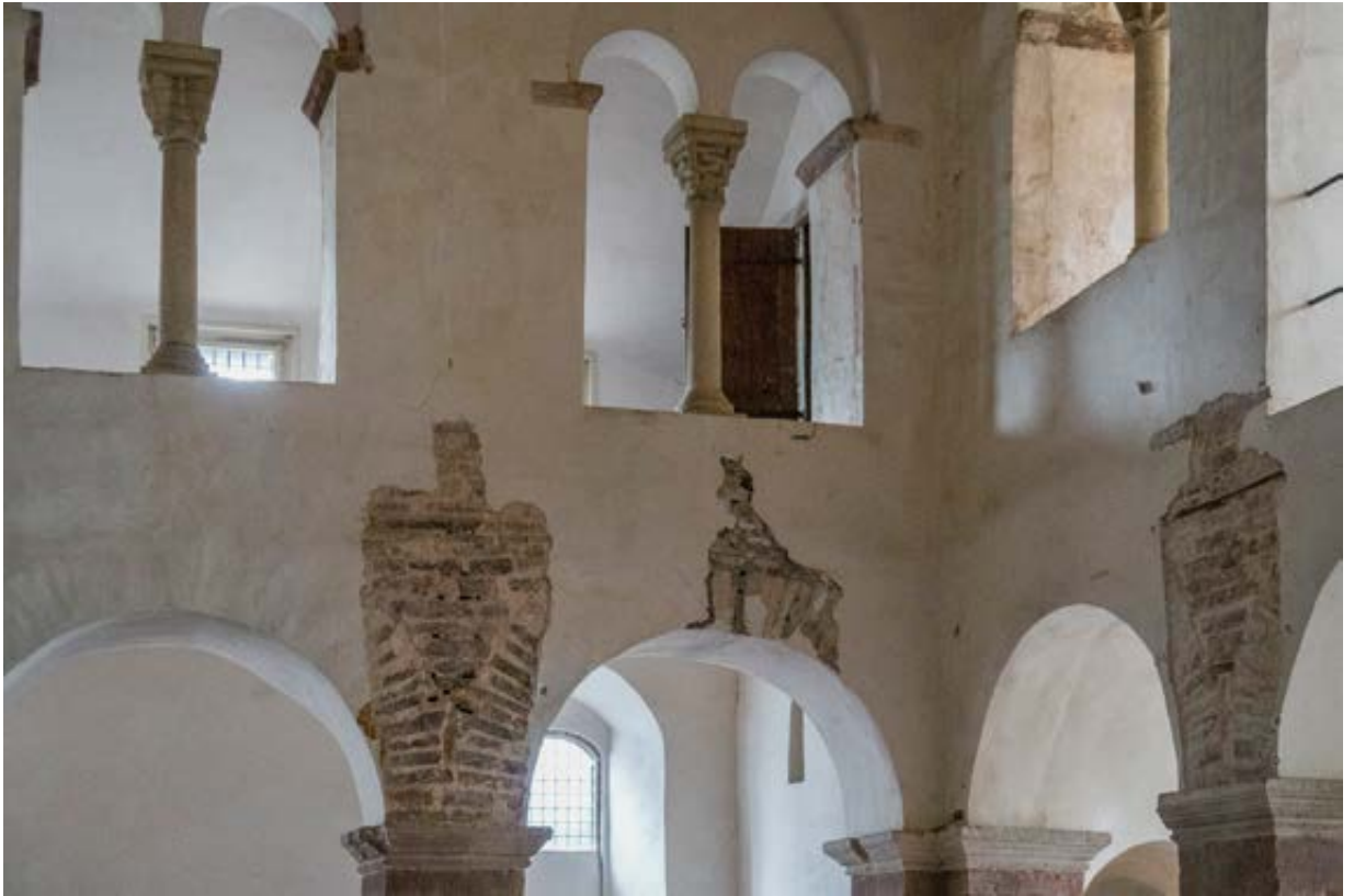
21 Freigelegtes Mauerwerk mit Sinopien
