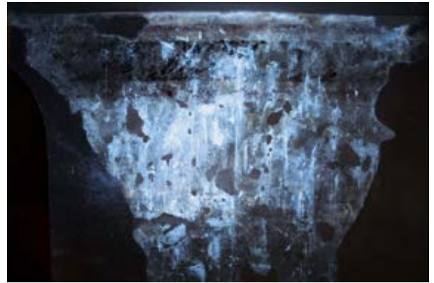
22 Wandmalereifries auf der Südwand im Erdgeschoss des Westwerks: UV-Lichtaufnahme zur Verdeutlichung der fotografischen Dokumentation der Auflagen von nicht entfernten Bindemittelresten, 2018
