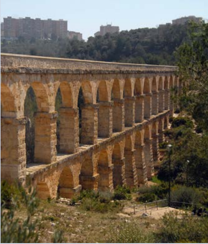
15 The Puente del Diablo Roman aqueduct (Tarragona) Acueducto romano Puente del Diablo (Tarragona)
