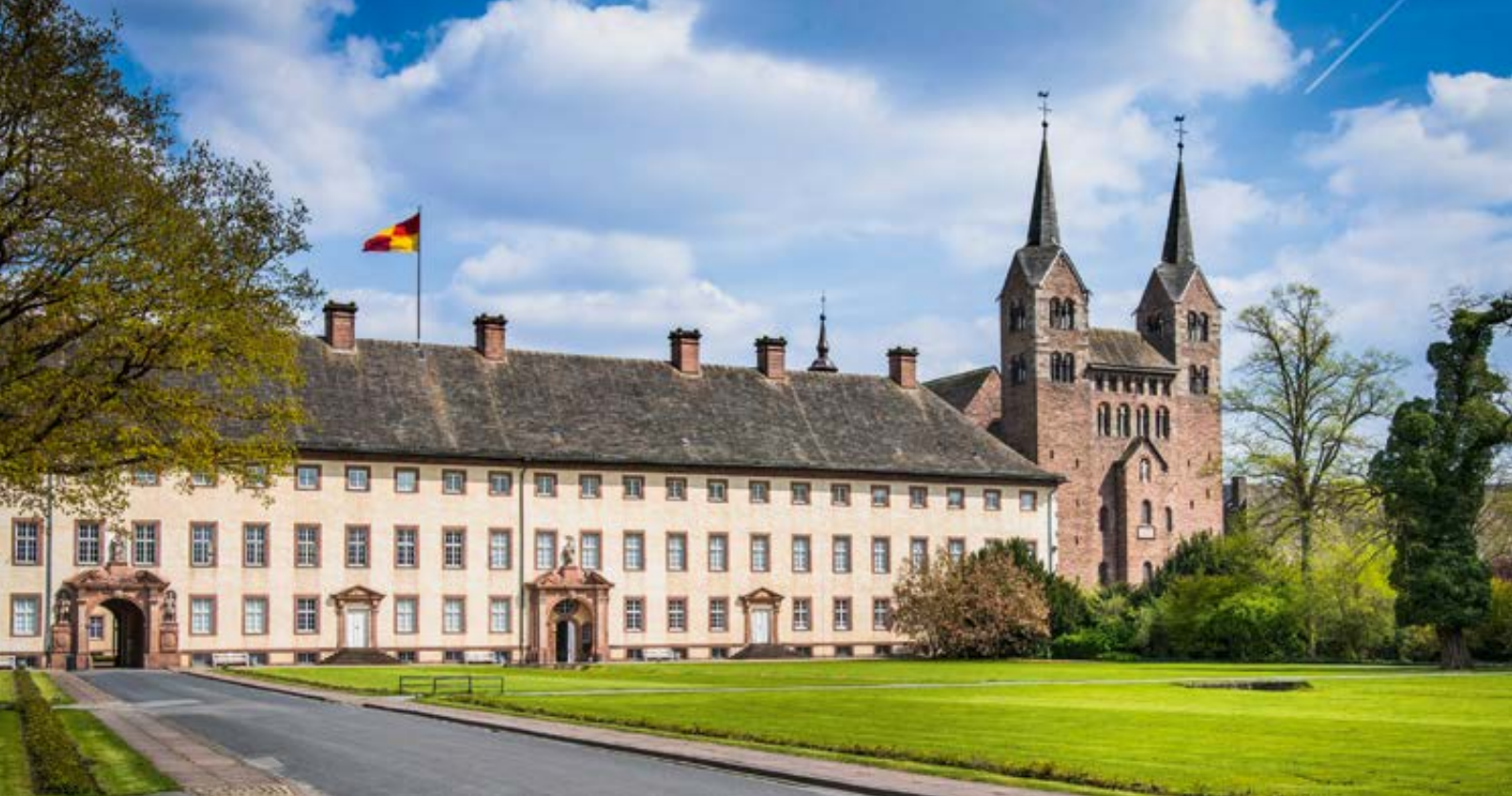
2 Außenansicht des Westwerks mit ehemaliger barocker Klosteranlage
