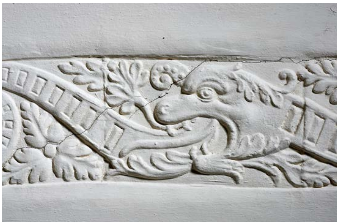
24 Detail der Stuckdecke im Johanneschor des Westwerks: Balkendekoration mit Pressstuckfries, 2019
