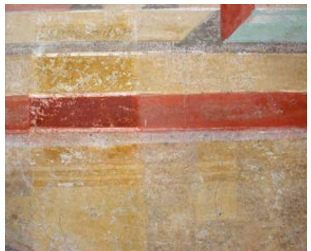
7 Detail aus dem Hintergrund am oberen Rahmen der Heilung des Wassersüchtigen auf der Nordwand mit Schimmelbefall und Arbeitsproben zur Abnahme von Schimmel sowie einer Übermalung von 1921/22
