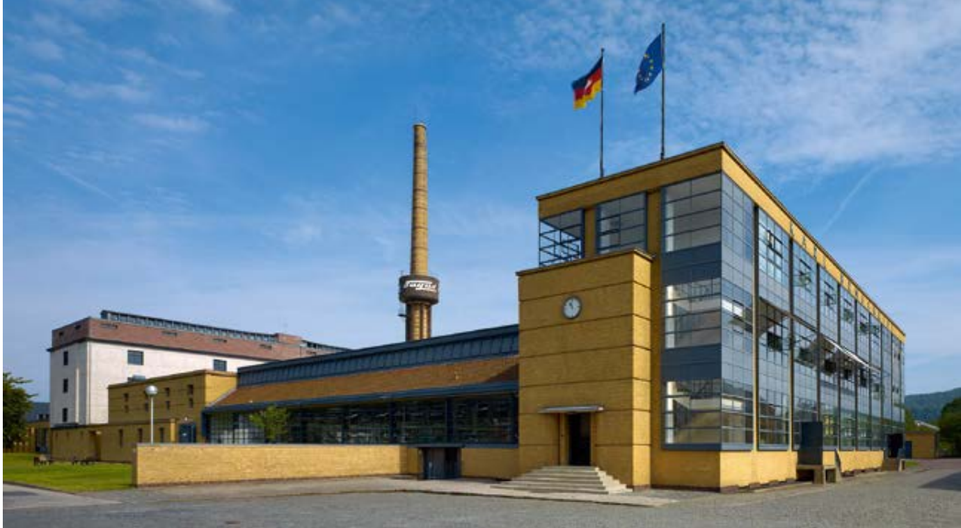
1 Fagus-Werk, Ansicht Eingangsportal mit Produktionsstätte und Lagerhaus, 2011 Fagus Factory, view of the main entrance with production hall and warehouse, 2011
