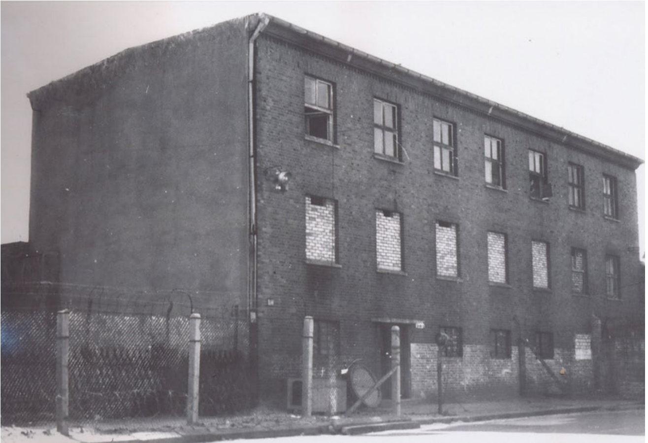
Abb. 4: Umwandlung des DR-Werkstattgebäudes bzw. der Signalmeisterei in ein Postenhaus der Grenzposten ab 13. August 1961, Aufnahme für die Planung von Abrissarbeiten (1964) (Quelle: GBM, Bildarchiv, Bild-Nr. F-6285 (BA-MA, VA-07/8429, Blatt 38))
