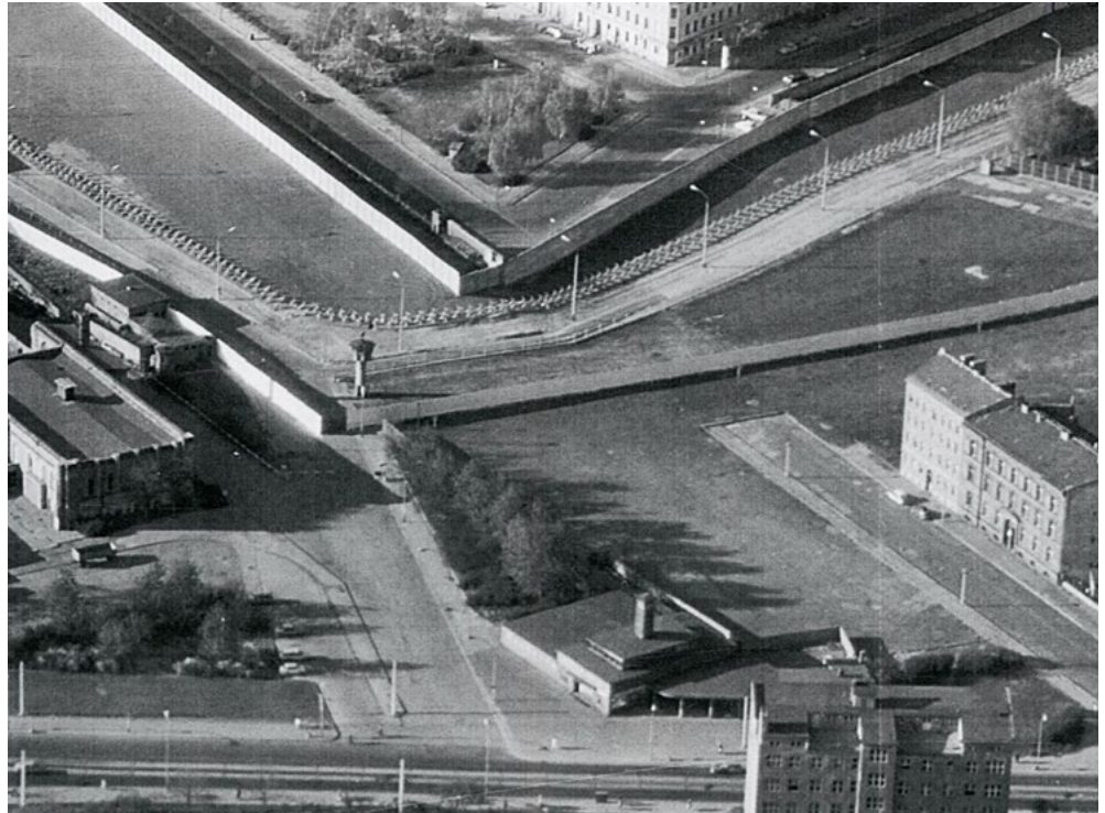
Abb. 11: Luftbild Berlin, Innenstadt mit der Grenzsituation an der Bernauer Straße/ Gartenstraße/Nordbahnhof 1974 (Quelle: Gedenkstätte Berliner Mauer, Bildarchiv, Bild-Nr. F-3582)
