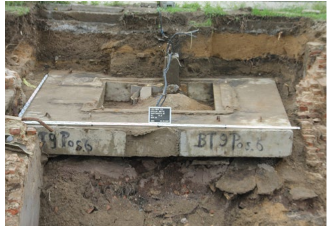
Abb. 15: Fundstelle Berlin, Gartenstr. 85–87/Nordbahnhof, Detailaufnahme vom Betonfundament des Wachturmes BT-9, Planum 2 (in situ belassen), Beschriftung „BT 9 Pos. 6“ (Foto: Bild G1860VII-444/ ABD-Dressler vom 25.07.2017)
