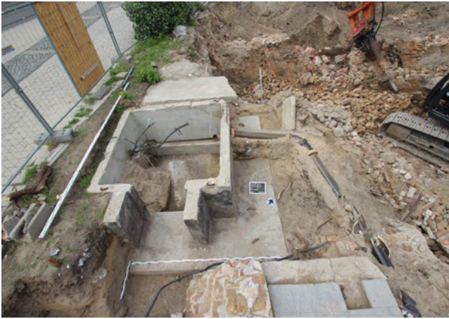
Abb. 14: Fundstelle Berlin, Gartenstr. 85–87/Nordbahnhof, Wachturm BT-9 mit Zuleitungen und Fundamentrest vom Wohnhaus Gartenstraße 85, Planum 1 und 2 (Foto: Bild G1860VII-392/ ABD-Dressler vom 13.07.2017)
