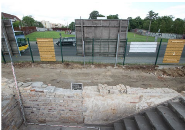
Abb. 9: Fundstelle Berlin, Gartenstraße 85–87/Nordbahnhof, Detailaufnahme von zugemauerten Durchgängen im DR-Werkstattgebäude, Sperrhindernis der 1. Grenz-Ausbauphase (1961–1965) (Foto: Bild G1860VII-154/ABD-Dressler vom 12.06.2017)
