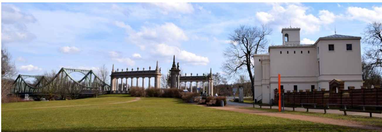
Abb. 5: Das Panorama mit der Glienicker Brücke und der restaurierten Villa Schöningen an der Schwanenallee in Potsdam im Jahr 2018 (Foto: Ulrichhobby, Wikimedia Commons, https://de.m.wikipedia.org/wiki/Datei:Panorama_Glienicker_Bruecke_mit_Villa_Schoeningen.jpg )
