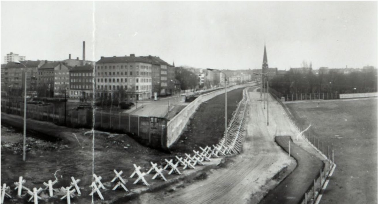
Abb. 12: Grenzstreifen an der Ecke Bernauer Straße/Gartenstraße/Nordbahnhof und Bergstraße vom 10. Mai 1970, in der Mitte zwei Reihen Fahrzeugsperrn auf Betonfundament, Kontrollstreifen und Postenweg der 2. Grenzausbauphase (1966–1979) (GBM, Bildarchiv, Bild-Nr. F-1091)
