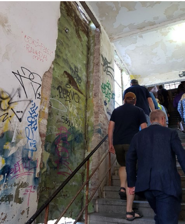
Abb. 8: Mit Platten verschlossene Fenster im ehemaligen Betriebsgebäude der Ost-Berliner Verkehrsbetriebe, 2018 (Foto L. Glabau)
