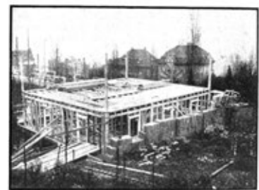
Abb. 40 | Stand am zweiten Tag | Über der Balkenlage des Erdgeschosses kommt der Unterboden, der gleichzeitig Rüstboden ist.
