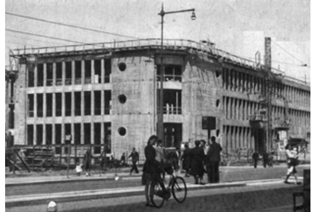
Abb. 7: Robaver am Coolingsingel, im Bau
