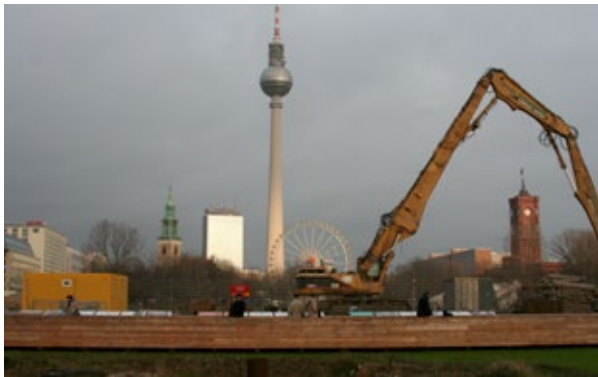
Abb. 15: Dezember 2008: Der Palast ist abgerissen.
