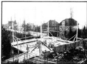
Abb. 38 | Erster Tag. Die fertige massive Erdgeschossdecke über dem Keller. Die 4 durchgehenden Eckpfosten stehen.
