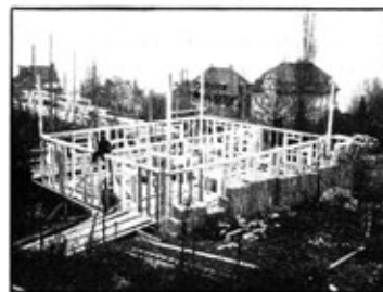
Abb. 39 | Die Rahmen des Erdgeschosses sind versetzt
