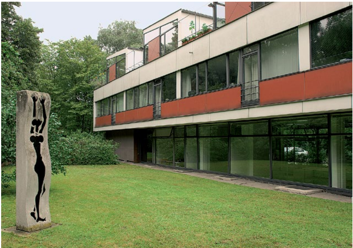
Abb. 13: Hansaviertel / Altonaer Straße: Gartenskulptur am ehemaligen Eternithaus (Westberlin)
