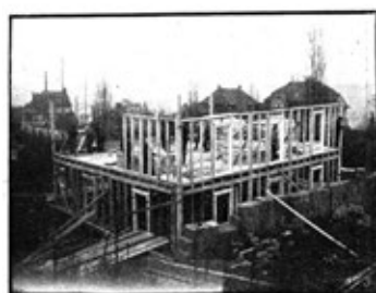
Abb. 41 bis 43 | Auf dem vorgeschriebenen Rüstboden werden die Rahmen des zweiten Stockes versetzt | In der Mitte: Der Winter setzt ein. Es wird weitergebaut | Rechts: Stand am dritten Tag. Der Dachstuhl ist aufgeschlagen. Die innere Schalung der Außenwände ist zu sehen.
