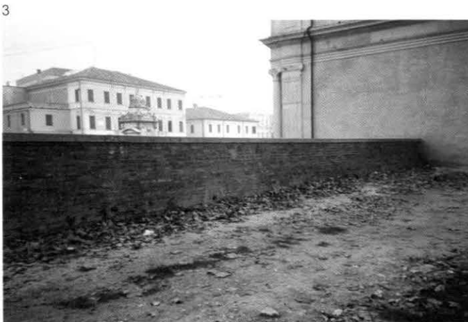
2. Il parapetto di sicurezza in ferro da installare in luogo del massiccio muro novecentesco di contenimento delle piene del Piovego, non più attive a seguito del raddoppio di portata del canale scaricatore
