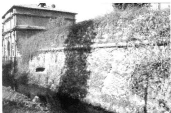
1., 2. Porta S. Giovanni e tratto di cortina: nel 1992, dopo l'aspersione del prodotto devitalizzante e, nel 1993, dopo la rimozione della vegetazione disseccata
