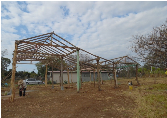
Figura 5. Vista del armazón o estructura de una casa de quincha, y Francisco "Chico" Vergara trabajando la casa de quincha de Orlando Barcasnegras en El Sesteadero, Los Santos -región de Azuero- © Silvia Arroyo
