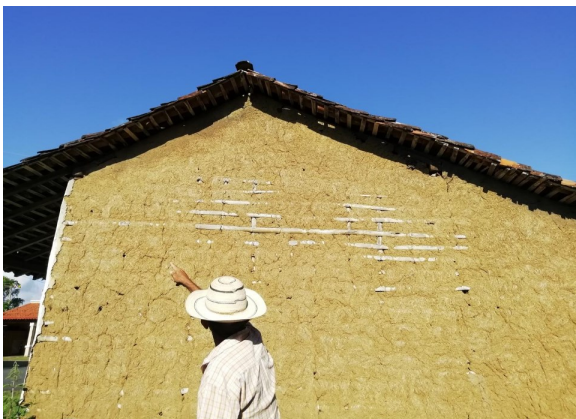
Figura 7. Euribiades “Chombo” Sánchez explicando la cubierta de una casa de quincha en Santo Domingo, Los Santos -región de Azuero- © Silvia Arroyo
