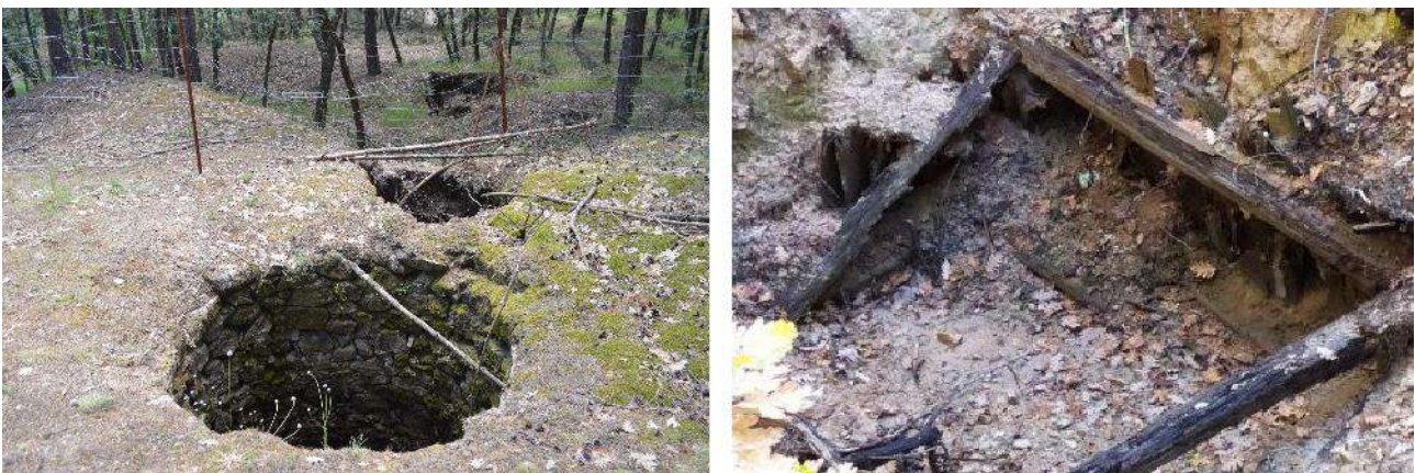
Fig. 4 Izquierda, pozo mampostado de ventilación del pozo Ángel. Derecha, aspecto actual del pozo Ángel. Como se puede observar, a pesar de encontrarse colmatado con tierra hasta su borde, se conserva la antigua entibación de madera. Obsérvese que las galerías que unen los dos pozos están colapsando
