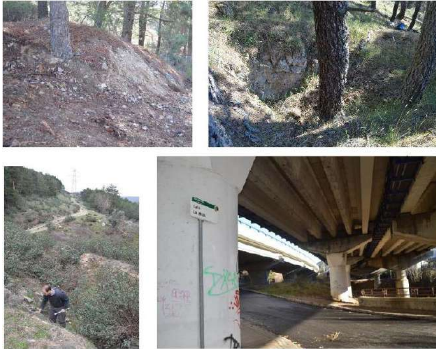
Fig. 6 Arriba a la izquierda, escombreras de las labores de la mina “El Carmen” situadas en el km. 33 afectadas por la apertura de una pista forestal siguiendo la vía férrea. Arriba a la derecha, pozo de la mina “Luis”obstruido por las labores de aterrazamiento. Abajo a la izquierda, aspecto de la “Calicata Santa Rosa” afectada por la apertura del cortafuegos de Cabeza Reina. Y abajo a la izquierda, actual calle La Mina donde se encontraban las labores de “Flor del Espinar”
