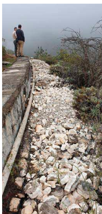
Fig. 1 Acumulación de restos petrificados Fig. 2 Obstrucción de conductos de agua
