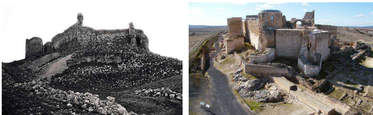
Fig. 5 El frente oriental del alcázar, antes y después de las intervenciones
