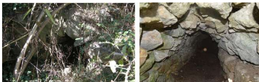
Fig. 5 Vistas exterior e interior del socaz
