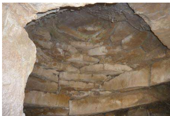
Fig. 4 Falsa cúpula que forma el techo de la bejera
