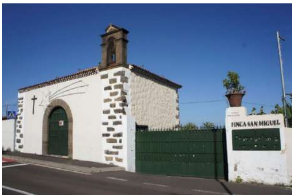
Fig. 15 Ermita y Finca de San Miguel. De planta rectangular, mide 9,30 m de largo por 5,30 m de ancho. Es un edificio de piedra y techo de cuatro aguas con tejas. Presenta dos entradas, una desde la finca y otra desde la calle
