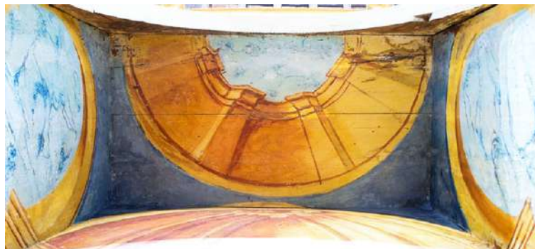
Fig. 29 Cúpula abierta al cielo mediante un óculo central, acompañado de pilastras y cornisas. Se localiza en el tablero superior de la hornacina
