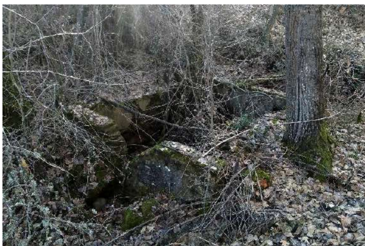
Fig. 5 Alberca existente en El Estepar, construida para lavar el wolframio de las minas durante la década de 1950
