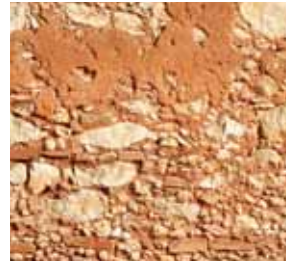
Detail of «mampuesto», a mixture of earth and rubble © Wilfredo Carazas-Aedo, CRAterre
