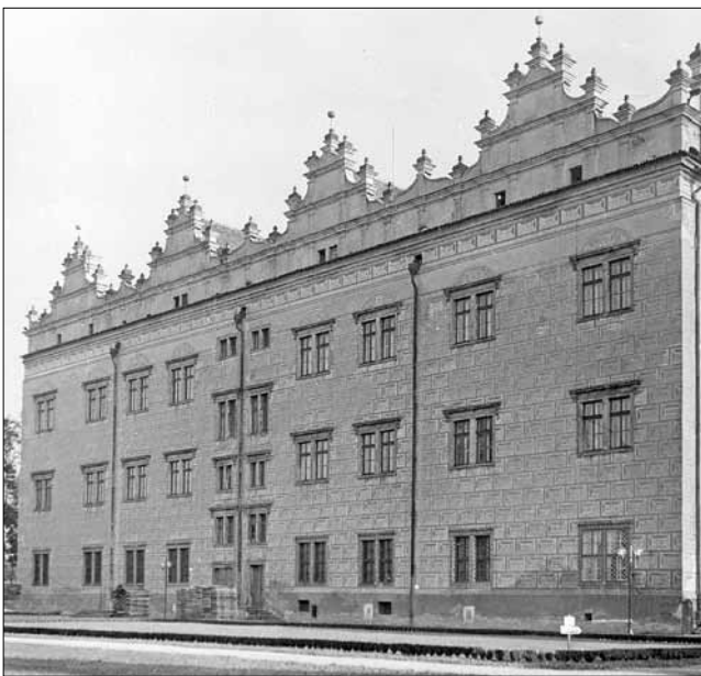
Abb. 11-6: Aktuelle Gesamtansicht des Schlosses von Litomyšl, Foto 2006, Martin Vavřík
