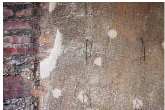
Abb. 14-20: Montage der Armierung
