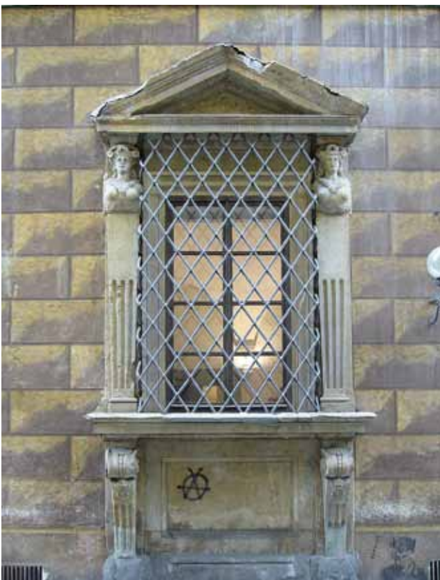
Abb. 9-18a-c: Schäden an Florentiner Fassadendekorationen durch fehlenden Bauunterhalt, mangelnde Pflege und Vandalismus: Beschädigungen durch mangelhafte Regenwasserableitung und Graffiti am Palazzo Ramirez di Montalvo; Beschädigungen durch aufsteigende Feuchtigkeit und Graffiti am Palazzo Gerini; hilflose Ausbesserungsversuche mit wiederholten Dispersionsanstrichen am Palazzo Benci, Zustand 2011
