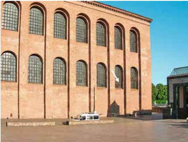
Abb. 5-1: Ansicht der Basilika mit Messbus im Juni 2009. Pfeil: instrumentiertes Basilika-Fenster
