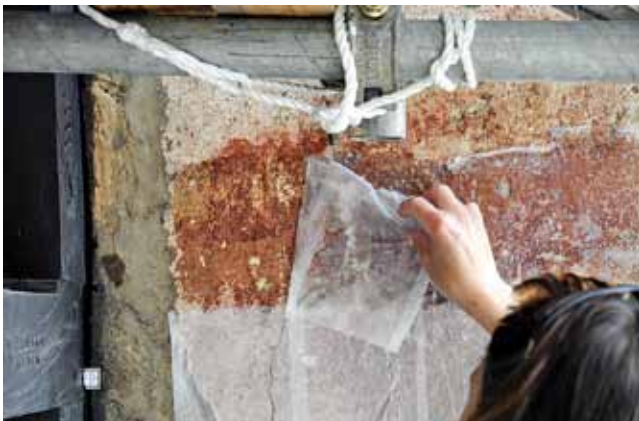
Abb. 7-16: Festigung der Malschicht über Japanpapier
