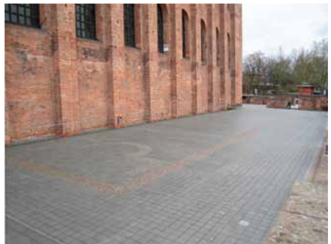
Abb. 8-6: Die Kennzeichnung antiker Bebauung im westlichen Umfeld der Konstantinbasilika durch andersartige Pflasterung
