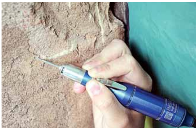
Abb. 7-19: Mechanische Entfernung von zementgebundenen Ergänzungsputzen
