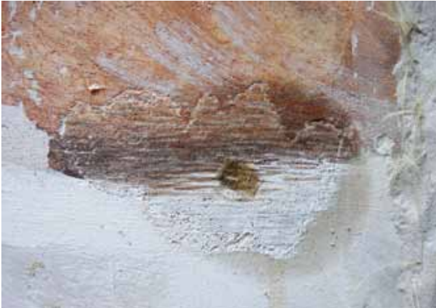
Abb. 14-13: Entfernen des Klebepunktes mit Lösungsmittel
