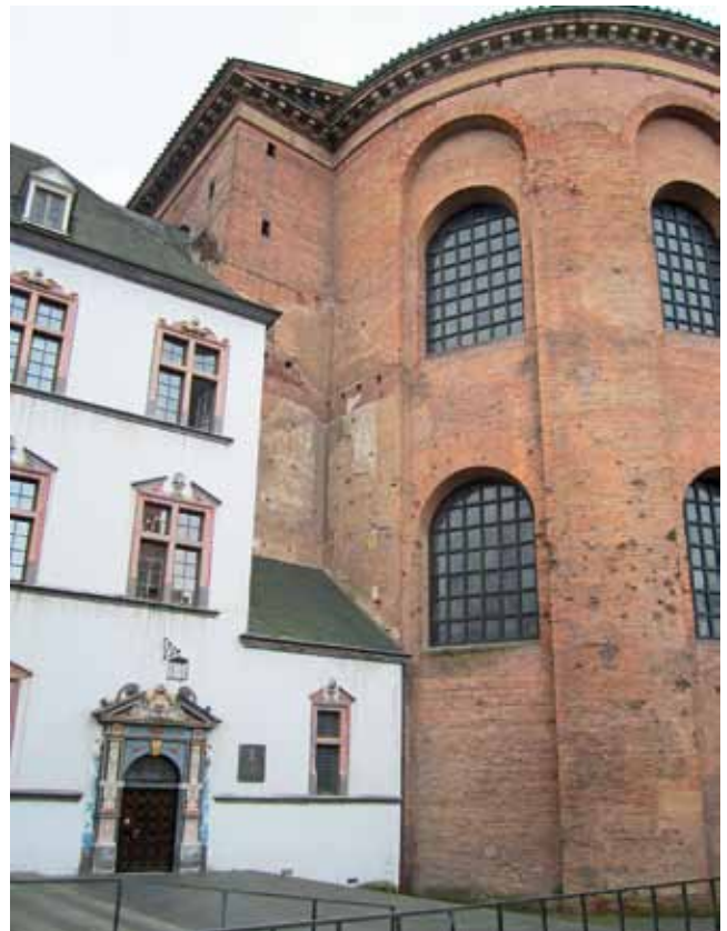
Abb. 8-5: Reste des Außenputzes der Konstantinbasilika östlich der Apsis
