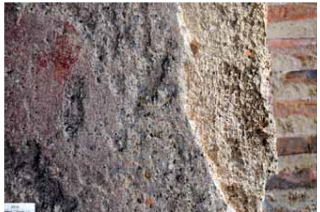
Abb. 4-3: Römisches Mauerwerk an der Fensterachse W08-Süd: Fugenstrich und Abziehgrate vom Verdichten des Setzmörtels sind erkennbar
