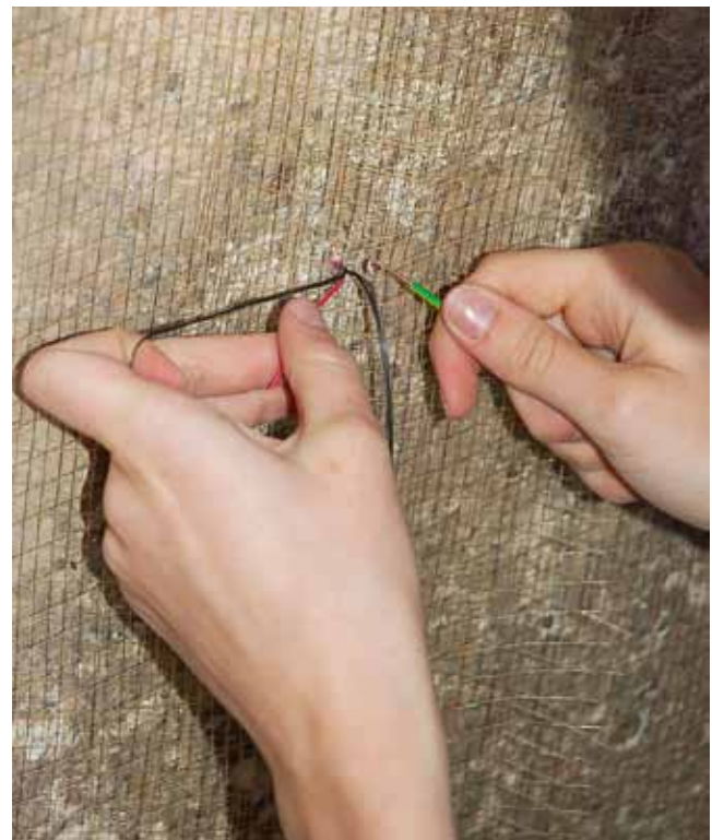
Abb. 14-21: Ausführungsdetail: Verknoten der Ankerfäden
