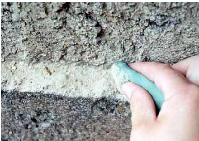
Abb. 7-18: Anwendungstechnik von Gommapane
