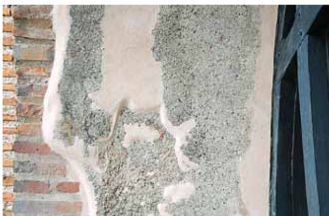
Abb. 7-19: Mechanische Entfernung von zementgebundenen Ergänzungsputzen
