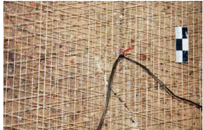
Abb. 14-19: Anbindung von zwei überlappenden Armierungsbahnen
