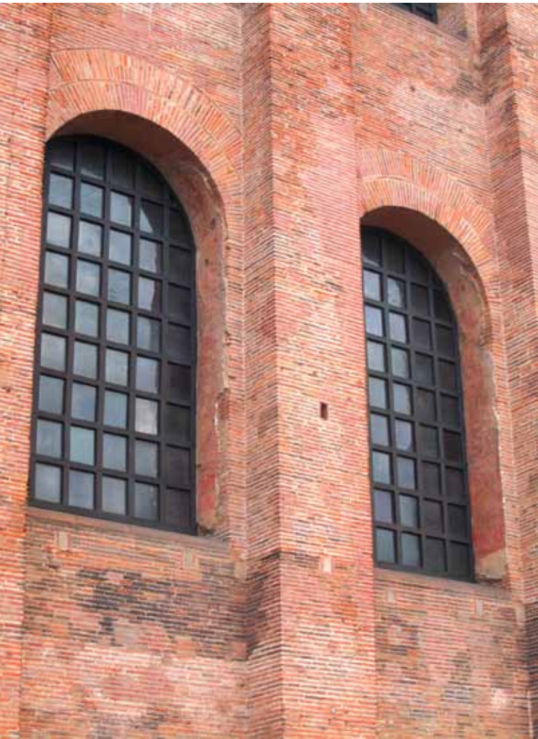
Abb. 8-4: Bemalte Wandputzreste in den Fensterlaibungen der Westfassade der Konstantinbasilika
