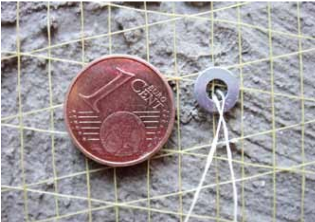
Abb. 14-8: Anbindung des Ankerfadens an die Armierung. Der Knotenpunkt ist mit einer Metallscheibe markiert.
