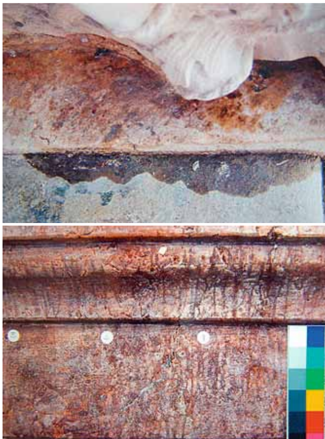
Abb. 6-7: Eingangsportal des Doms zu Freising. Polymerrückstand auf der Sockelplatte des Hl. Korbinian (links) und Ablaufspuren des mit dem Pinsel aufgetragenen Polyesters (Maßnahme von 1972), 1998
