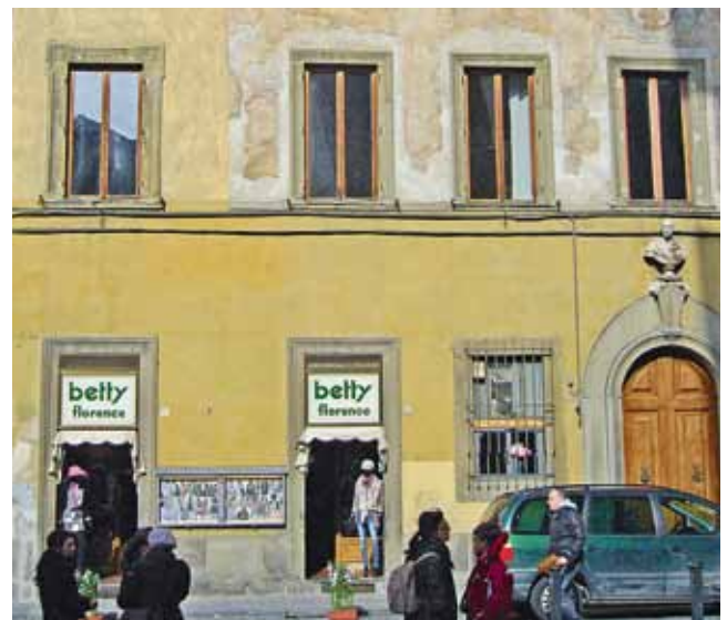
Abb. 9-18a-c: Schäden an Florentiner Fassadendekorationen durch fehlenden Bauunterhalt, mangelnde Pflege und Vandalismus: Beschädigungen durch mangelhafte Regenwasserableitung und Graffiti am Palazzo Ramirez di Montalvo; Beschädigungen durch aufsteigende Feuchtigkeit und Graffiti am Palazzo Gerini; hilflose Ausbesserungsversuche mit wiederholten Dispersionsanstrichen am Palazzo Benci, Zustand 2011
