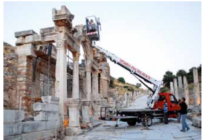
Abb. 15-3: Aufnahme des Gebälks mit einem Streifenlicht-Scanner von der Hebebühne aus, 2009
