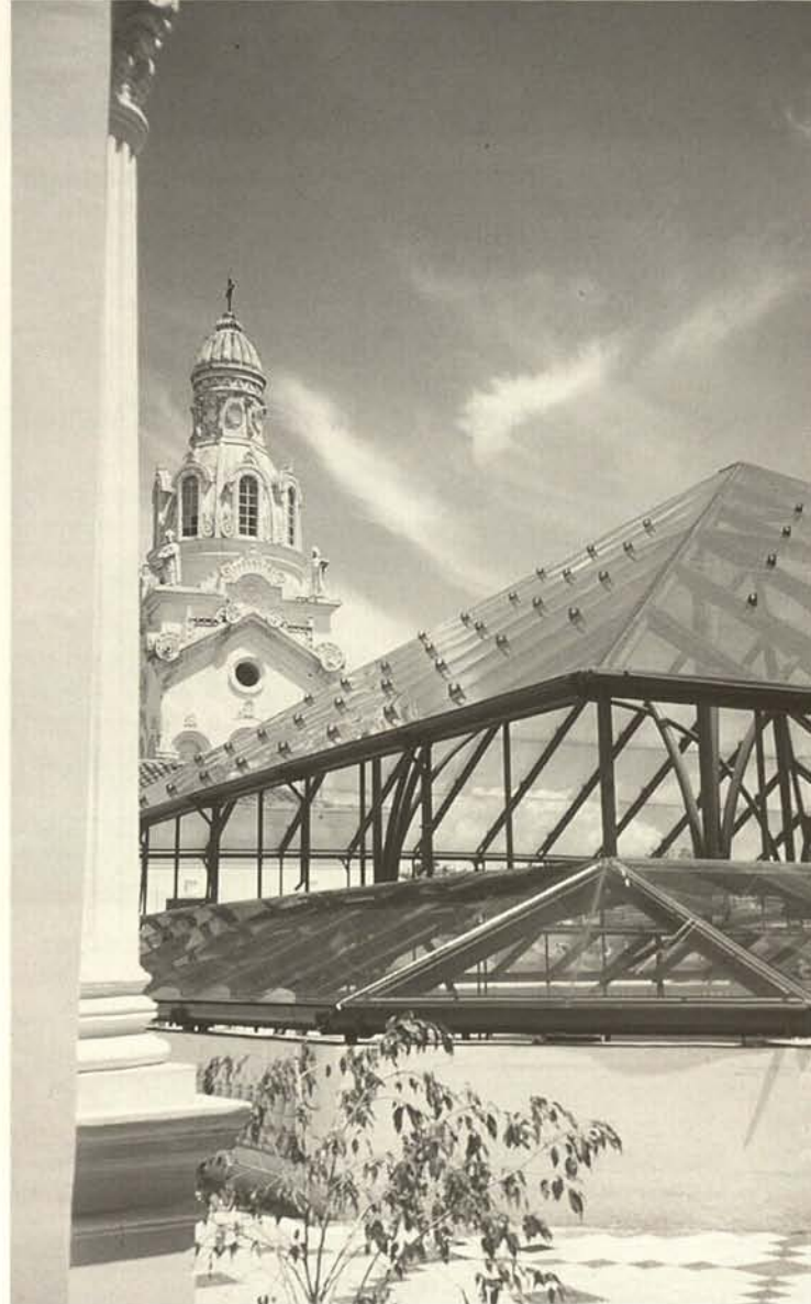
Nuevo centro cultural ubicado en una de las esquinas de la Plaza de la Independencia; vista de sus cubiertas.
