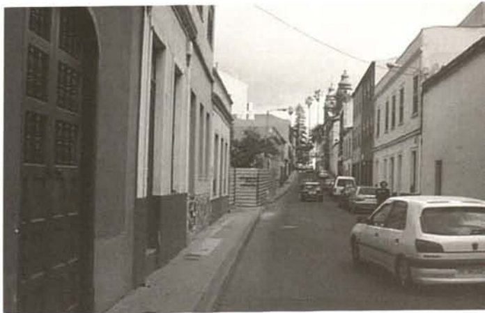
Calle de San Juan (10-03-2002), Antes de modificación de la manzana en el ámbito del Bien Cultural.
