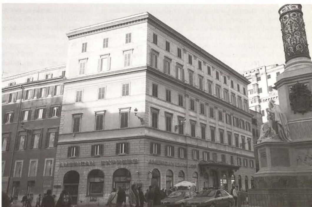
Rome, Piazza di Spagna – Piazza Mignanelli (example of building at risk of sale)
