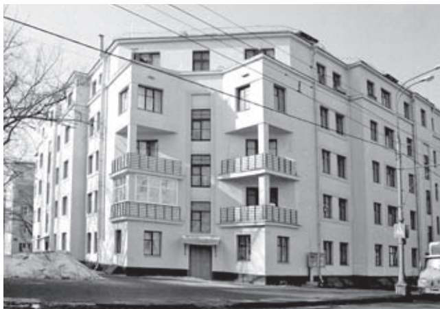
Жилой квартал «Дубровка» (ул. Мельникова, 2-я Дубровская ул.), арх. М. Мотылов, Н. Молоков, 1926–27. Состояние 2005
