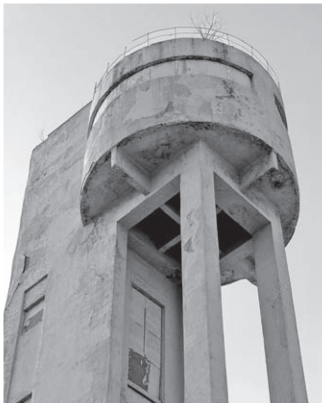
Водонапорная башня канатного цеха завода «Красный гвоздильщик», 1930–1931, арх. Я. Черников, в Санкт Петербурге. Состояние 2005 г
