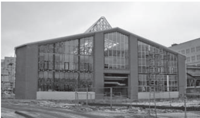
Здание мастерских Бахметьевского гаража, арх. В. Курочкин. Вид после реконструкции, 2005 г
