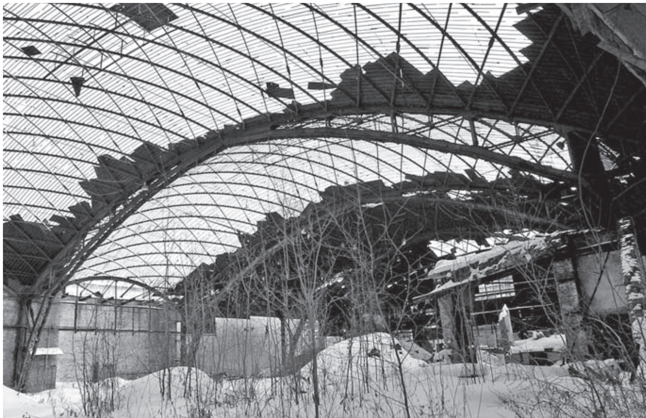
Покрытие прокатного цеха металлургического завода в г. Выксе Нижегородской области, выполненное В. Г. Шуховым в 1897 году в виде оболочек двоякой кривизны (современное состояние)
