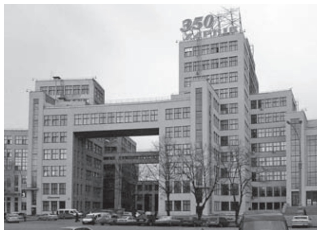
Здание Дома проектов на пл. Свободы в Харькове, 1925–35, арх. С. Серафимов, М. Фельгер, С. Кравец. Современное состояние
