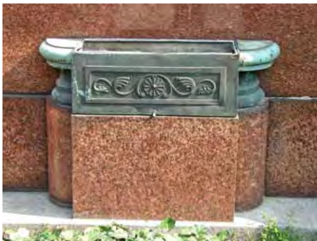
Abb. 7 Grabmal Sally Dagobert Lautenburg, verstorben am 25. Juli 1879. Eckiges Pflanzbecken mit geschwungenen Außenformen. Die Frontansicht ist mit einem floralen Muster verziert. Das verwendete Baumaterial (vermutlich Zink) wiederholt sich u. a. auch als Einfassung für die Grabtafeln (Foto: Isabel Güntzel, 2011).
