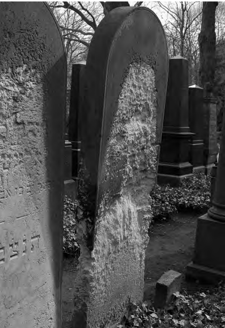
Abb. 6 Sandsteintafel ohne Unterbau mit Rundbogen als oberem Abschluss. Der sächsische Sandstein ist hier durch Verwitterung soweit ausgedünnt, dass er zu brechen droht. (Foto: TU Berlin 2008)
