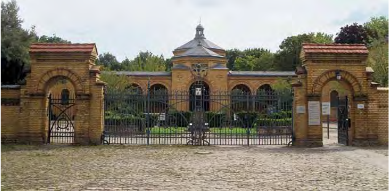
Eingangsgebäude von Hugo Licht (1880) des Jüdischen Friedhofs Berlin-Weißensee (Foto: Hans D. Beyer)
