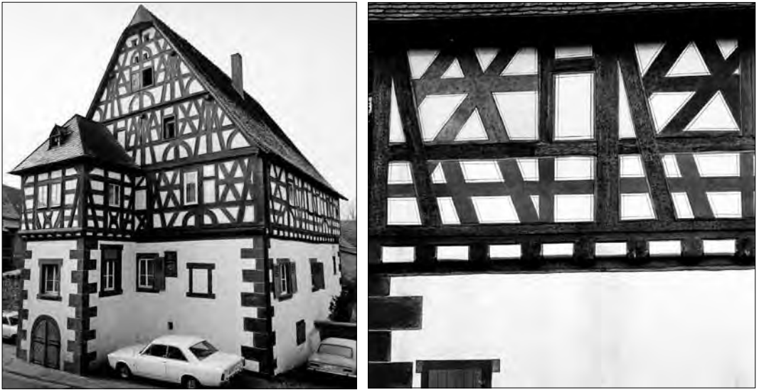
Abb. 2a, b: Ehem. Zollhaus in Stockstadt am Main (Lkr. Aschaffenburg), Fachwerkbau aus dem 3. Viertel des 16. Jh. mit einem Erkerartigen Vorbau von 1619, nach Wiederherstellung der Fachwerkfassung von 1619, auf der Grundlage historischer Befunde, Gesamtansicht und Detail, um 1970 (Foto Bayerisches Landesamt für Denkmalpflege, um 1970)
