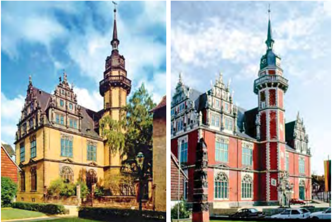
Abb. 1a,b: Aulagebäude des Juleums in Helmstedt (Niedersachsen), vor (links) und nach (rechts) der Wiederherstellung der farbigen Fassadenfassung auf der Grundlage von Analogien, frühe 1970er Jahre (Foto: Niedersächsisches Landesamt für Denkmalpflege, Archiv, vor 1975)
