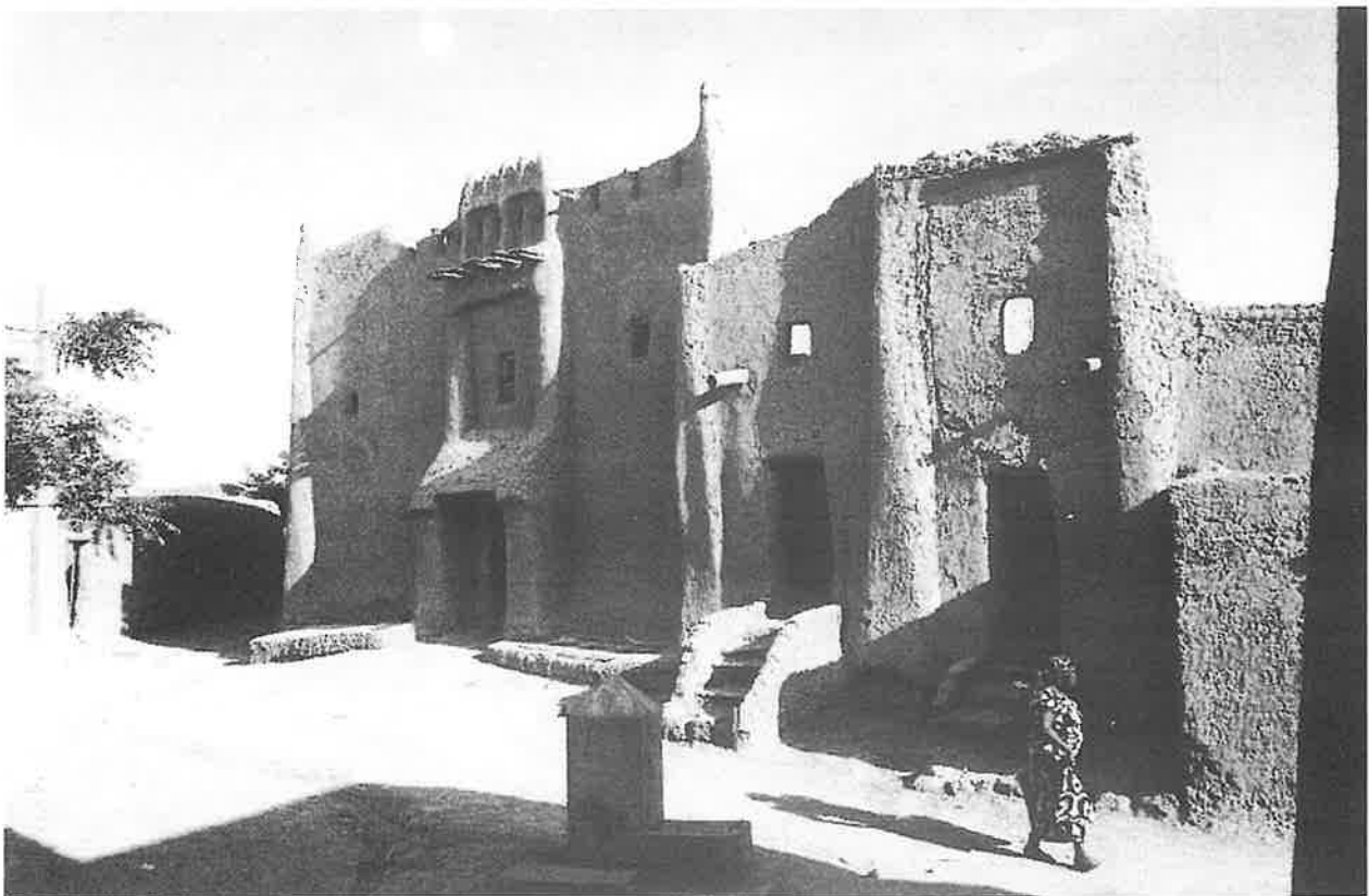
Fig. 9. Projet pilote : ensemble architectural G ; la maison Maiga en 1989 (photo R. van Wendel de Joode)
