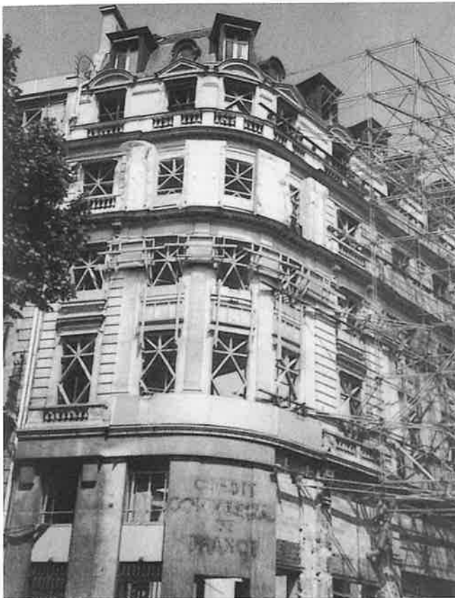
Fig 4. Ilôt Caumartin. Immeuble qui marque l'entrée de l'îlot et détruit Boulevard des Capucines, Paris 9 (75 000 m 2 ) Ph. Ch. S-M. juin 1996
