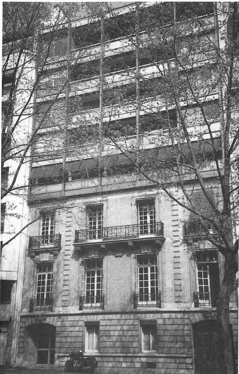
Fig 2 136, avenue Marceau, Paris 8. Densification de la parcelle par doublement en hauteur : phase d'empilement qui a précédé le façadisme.
