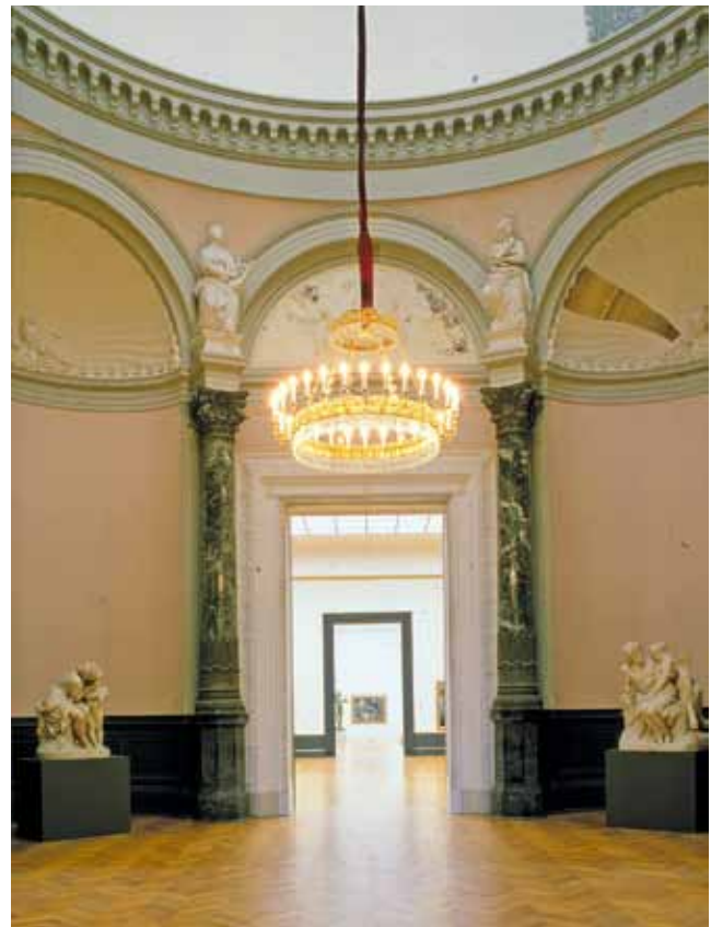
Alte Nationalgalerie, Kuppelsaal mit restauratorischen Freilegungen vor der Sanierung.
