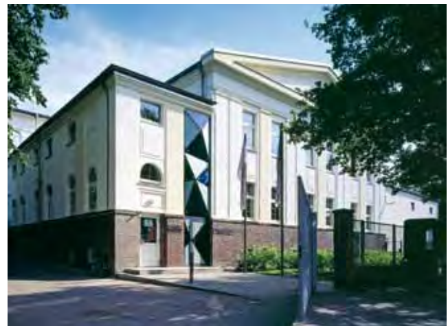
Berlin, Hauptfassade des zur Synagoge umgebauten Umspannwerks Münstersche Straße.
