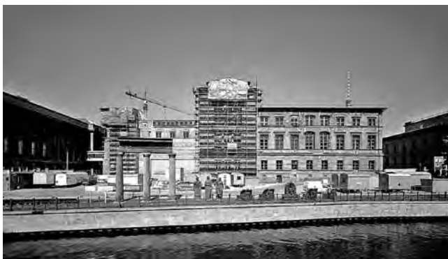
Neues Museum, Sicherungsarbeiten an der Kriegsruine, um 1995.
