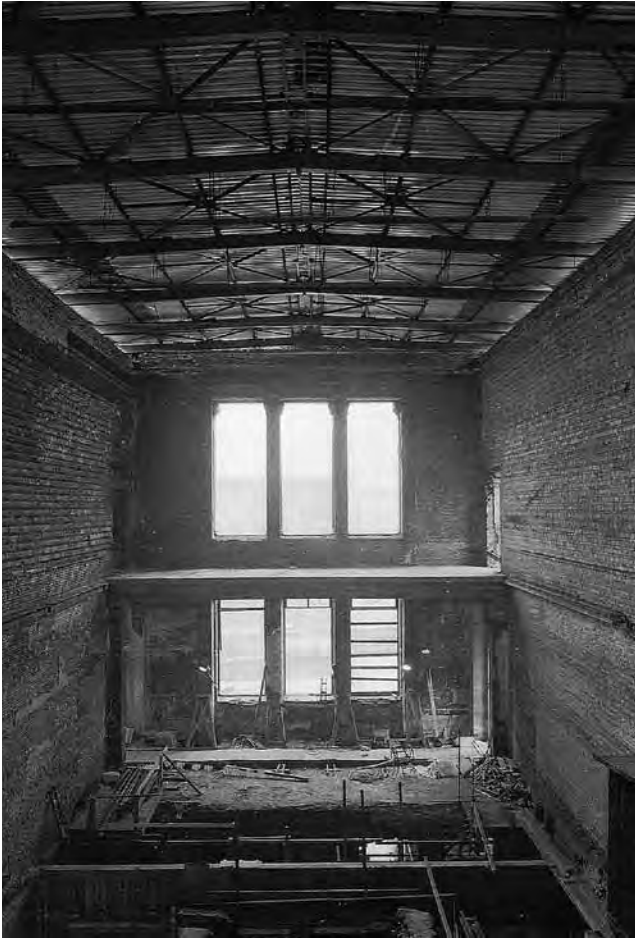
Neues Museum, zerstörtes Treppenhaus Новый Музей, разрушенная лестничная клетка
