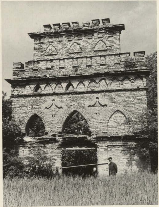
Abb. 59. Kolk, Ruinen des Ochsenstalls.
