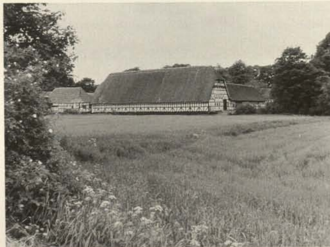
Abb. 32. Lundegård, Fünen. Die vielfältigen Erhaltungsprobleme dänischer Herrensitze betreffen vor allem auch die Wirtschaftsgebäude, nachdem sie aufgrund des technologischen Wandels in der Landwirtschaft vielfach nicht mehr den heutigen Bedürfnissen entsprechen.
