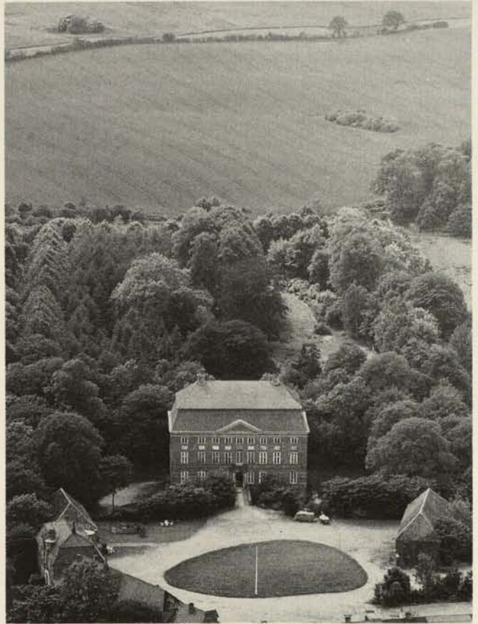
Abb. 15. Ludwigsburg, Luftbild der Gutsanlage von Olsten, links und rechts unten die stehengebliebenen Seitenflügel des 1967 abgebrochenen Marstallgebäudes.
