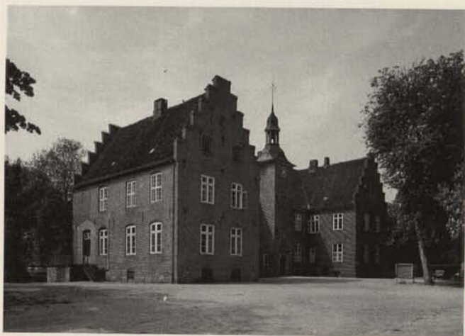
Abb. 7. Hagen (Kreis Plön), erbaut 1649, späte Nachwirkung des Dreiflügeltyps der Renaissance.
