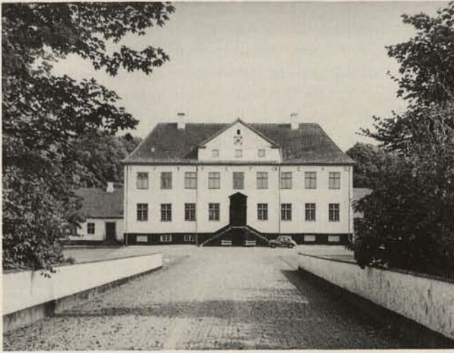
Abb. 20. Rosenholm im Djursland, Jylland, linker Hauptflügel, erbaut in den sechziger Jahren des 16. Jahrhunderts, im letzten Jahrzehnt des 16. Jahrhunderts zur vierflügeligen Anlage erweitert.
