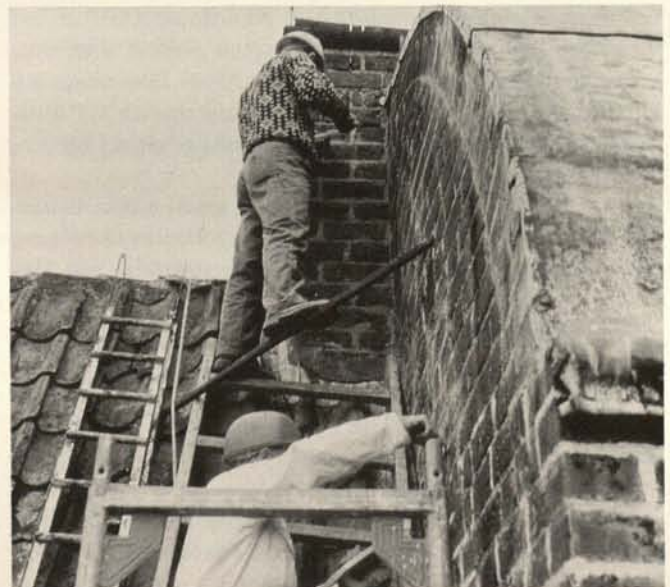
Abb. 36. Hesselagergård, Fünen. Restaurierungsmaßnahmen an einem der ungewöhnlich gestalteten Giebel des Herrenhauses, das nach 1500 von Johan Friis errichtet worden ist.
