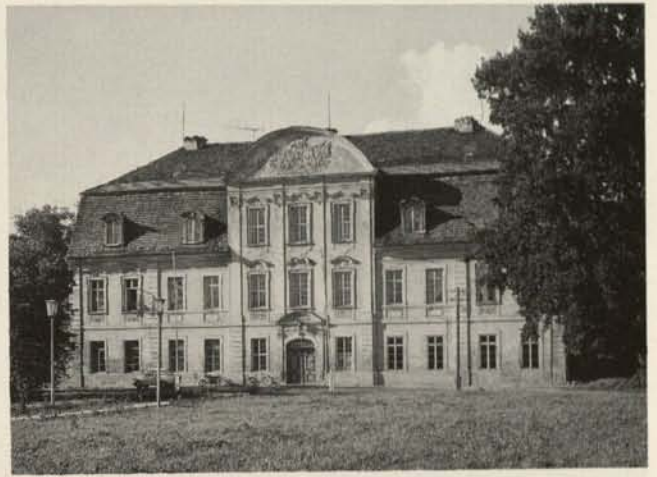
Abb. 90. Schloß Kummerow. Der 1733 errichtete zweigeschossige Rechteckbau mit Mittelrisalit und Mansarddach vertritt den Typus der barocken Gutshäuser und Schlösser in Mecklenburg und Vorpommern.
