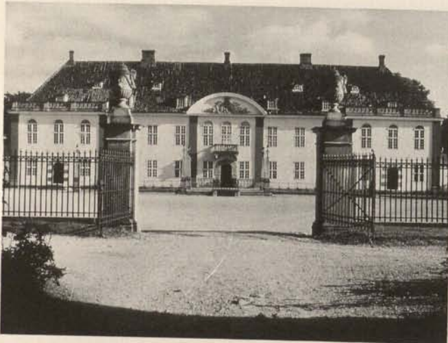
Abb. 28. Ledreborg, Seeland. Das Hauptgebäude wurde nach 1740 für den Premierminister Johan Ludvig Holstein nach Plänen der damals führenden Architekten Krieger, Thurah und Eigtved errichtet. Bedauerlicherweise wurde kürzlich Hausschwammbefall festgestellt.
