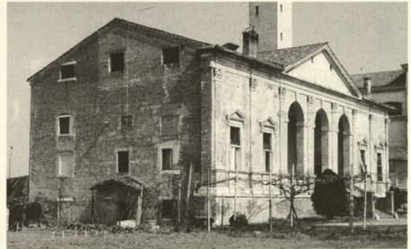
1 Bertesina (Vicenza), Villa Gazzotti (heute Curti) von Andrea Palladio, ca. 1540-45, Ansicht von Südwesten
