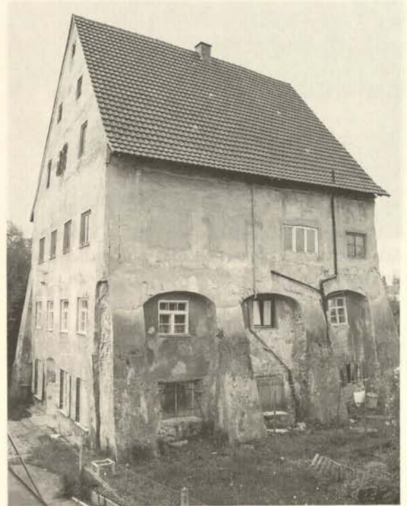
12 Krumbach, Hürbener Schlößchen, Ansicht von Südosten, Zustand 1978 vor der Maßnahme
