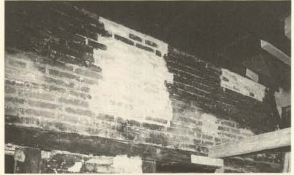
15 Krumbach, Hürbener Schlößchen, Reparatur der bei der Vorsicherung entstandenen Schäden mit dem originalen Ziegelmaterial. Die Nutzungsspuren (Rußablagerungen) in der historischen Küche des Obergeschosses sind nicht rekonstruierbar.
