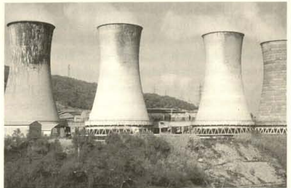
5 Gewinnung elektrischer Energie aus Erdwärme in Larderello (Italien)
