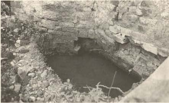
13 Krumbach, Hürbener Schlößchen, Sondage zur Prüfung des Fundaments (vgl. Abb. 10, Pfeil).
