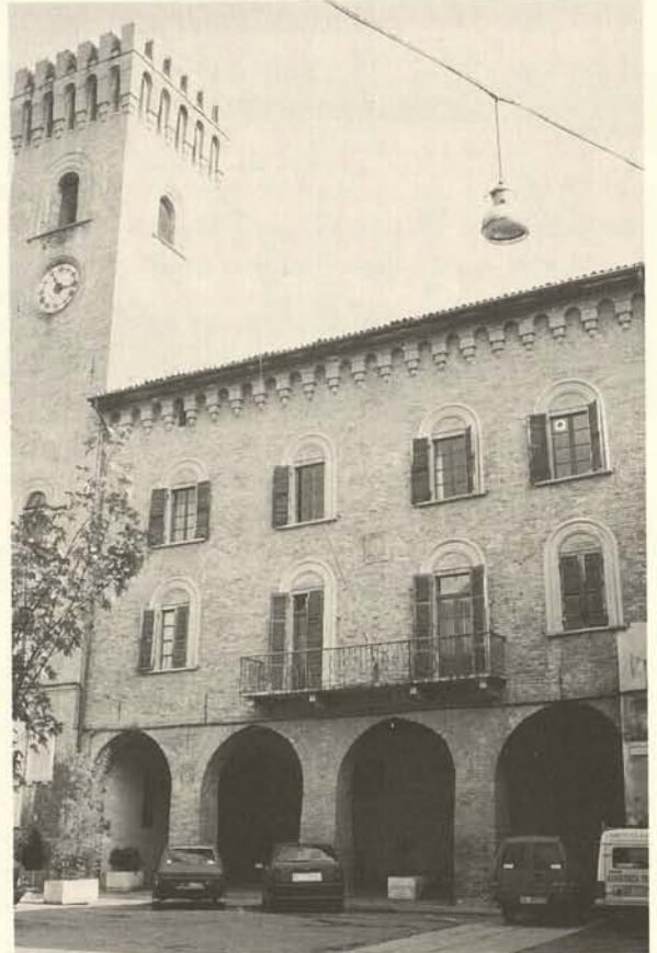
5 Nizza Monferrato, Rathaus, Fassade zur Piazza. Beispiel für weitgehend ausgetauschte Schmuck- und Ausbausubstanz
