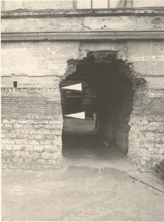
7 Bedauerlicher Fundamentdurchbruch für die Bauarbeiten 1989 (vgl. Abb. 6), ermöglicht Einblick in die Fundamentkonstruktion. Pfeile: originale Bitumensperrschichten; unter ihnen jeweils Ziegelrollschichten.
