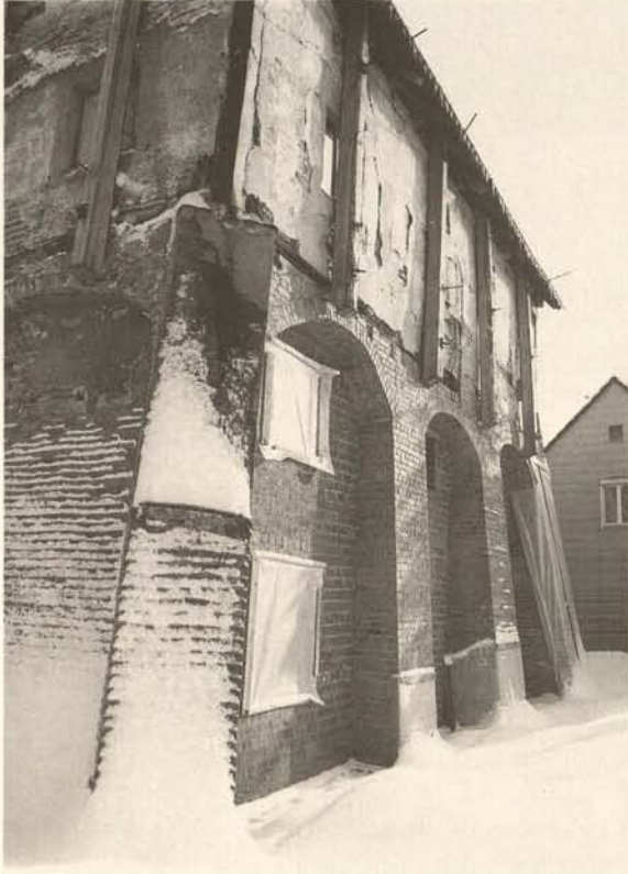
18 Krumbach, Hürbener Schloßchen, Unterbau, Westseite, nach völliger Erneuerung im Bereich des „Tunnels“ (Abb. 16). Die alten, schiefstehenden Schildwände sind durch neue, senkrechte ersetzt, die Pfeiler nahezu senkrecht erneuert (1982).
