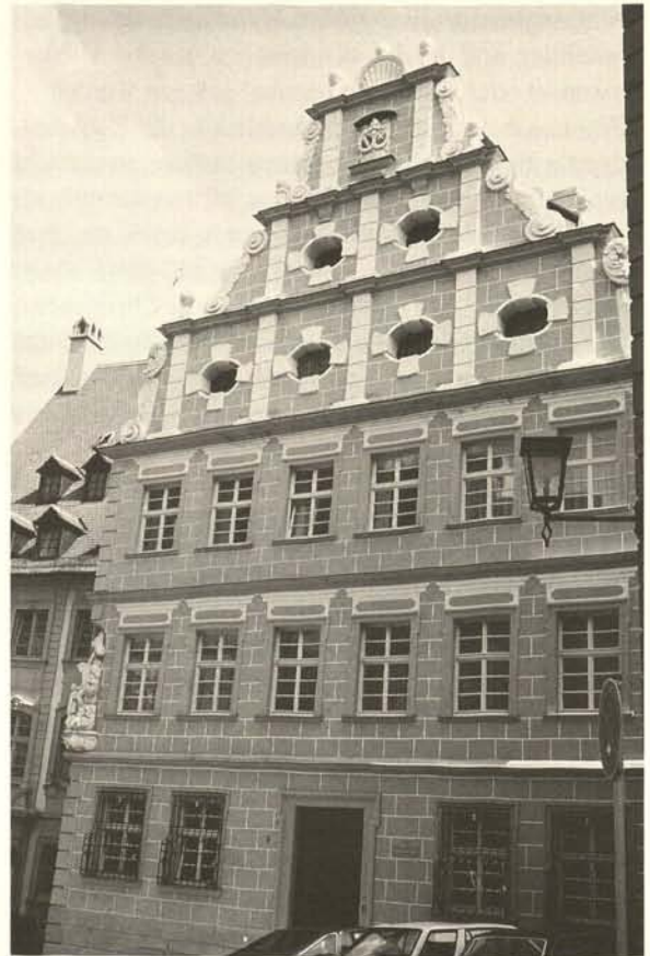
17 Bamberg, Ebracher Hof, Fassade mit Rekonstruktion der ersten Fassung
