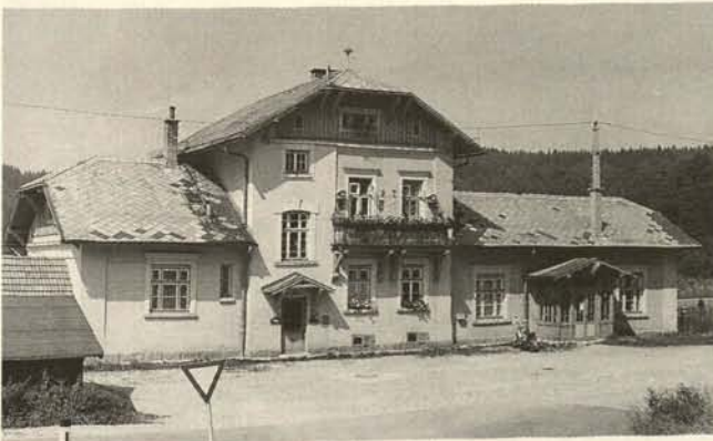
Abb. 92. Gödersdorf bei Finkenstein (Kärnten), Aufnahmegebäude, errichtet 1906: Typ A der um 1900 gültigen Staatsbahnnormalien.
