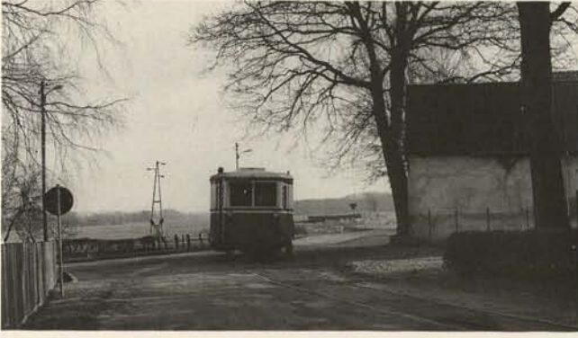
Abb. 24. Uenzen, Ortsdurchführung der Kleinbahn Hoya-Syke-Asendorf als Beispiel sparsamer Trassierung (Zustand 1991).
