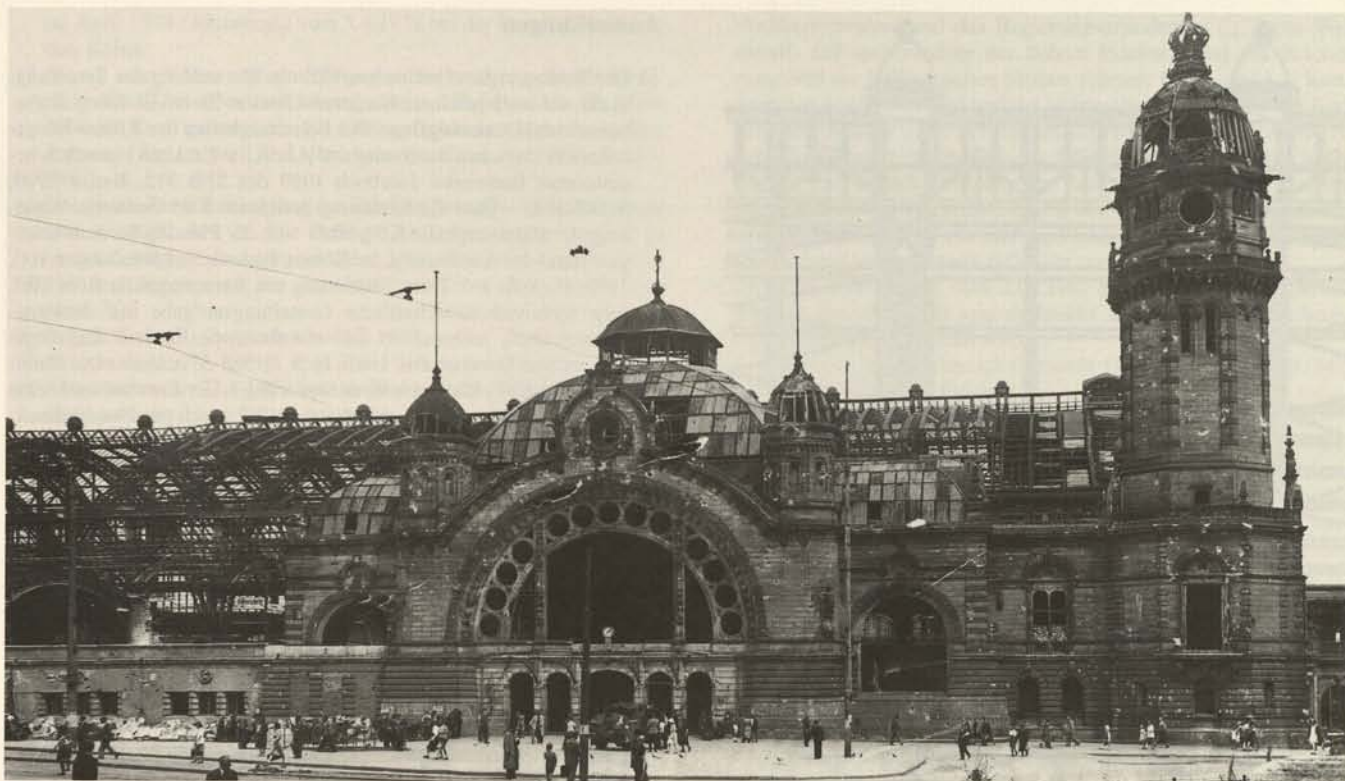
Abb. 102. Köln, Hauptbahnhof, Ansicht von Südwesten im Zustand der Kriegszerstörung (um 1945).
