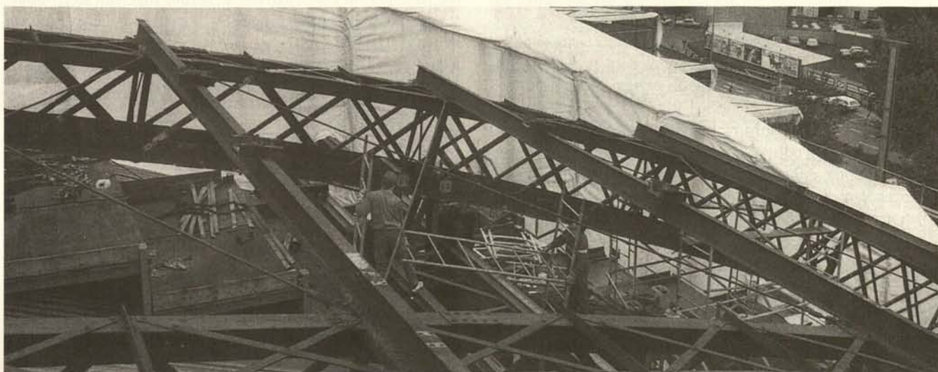
Abb. 101. Köln, Hauptbahnhof, Details der Bahnsteighalle nach Abtragung der Dachhaut im Zuge der Sanierungsmaßnahme: Blick nach Norden über die Nordecke der Halle mit den originalen Pfetten.
