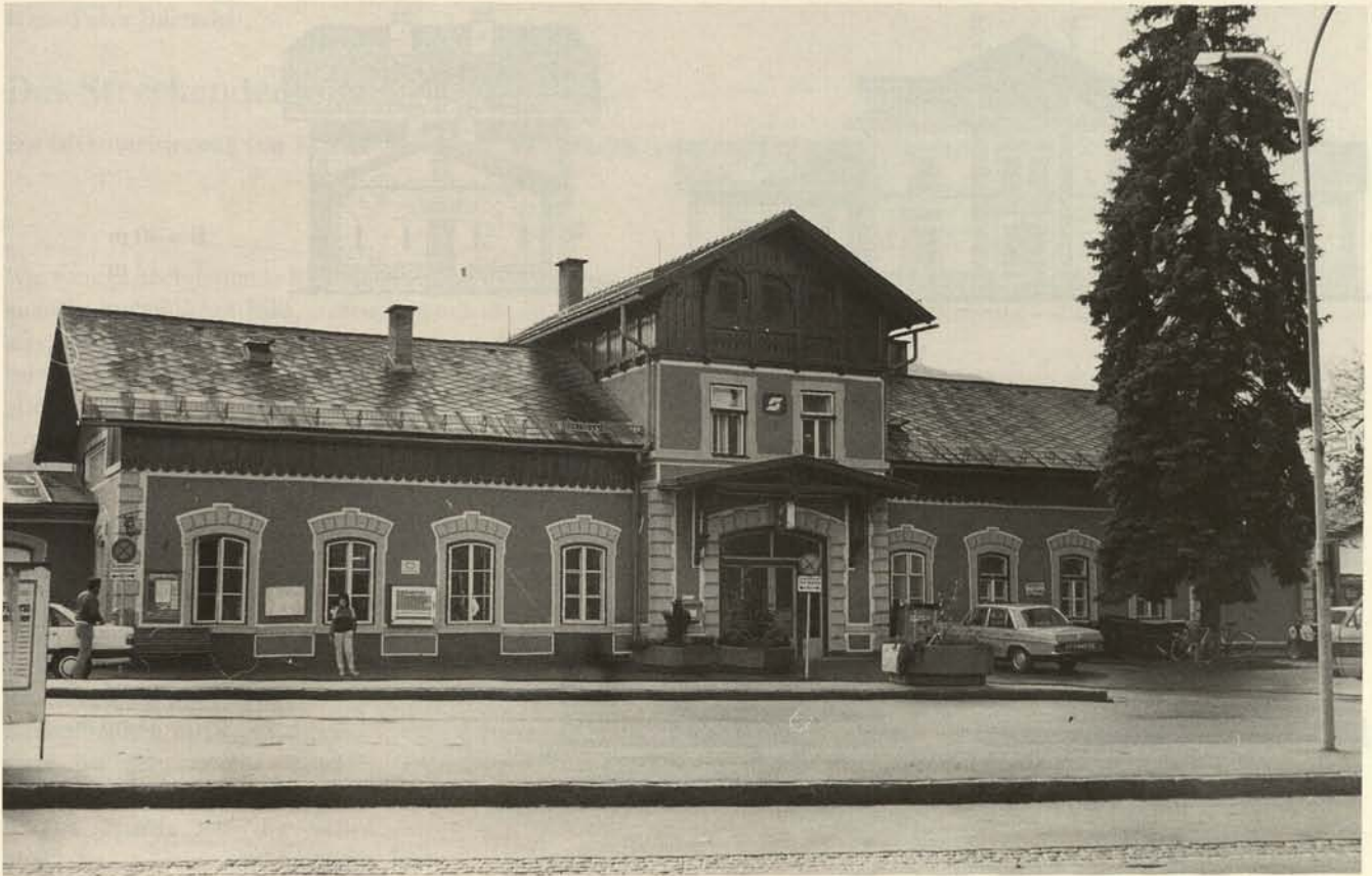
Abb. 91. Feldkirchen (Kärnten), Aufnahmegebäude der Kronprinz-Rudolf-Bahn, errichtet 1868/70: Regeltypus A mit charakteristisch überhöhtem mittlerem Quertrakt.
