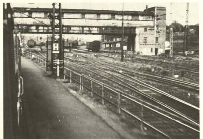
Abb. 4. Chemnitz-Hilbersdorf, elektromechanisches Brückenstellwerk (Zustand 1985).
