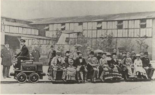
Abb. 29. Berlin, Gewerbeausstellung 1879, erste elektrische Bahn Europas: Ausstellungsbahn der Firma Siemens & Halske mit Stromerzeugung durch einen stationären Generator und Stromzuführung über eine Mittelschiene.
