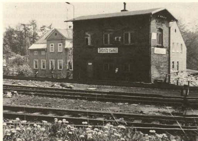
Abb. 2. Sebnitz (Sachsen), Zweckbau eines mechanischen Stellwerks, Ende 19. Jahrhundert (Zustand 1985).
