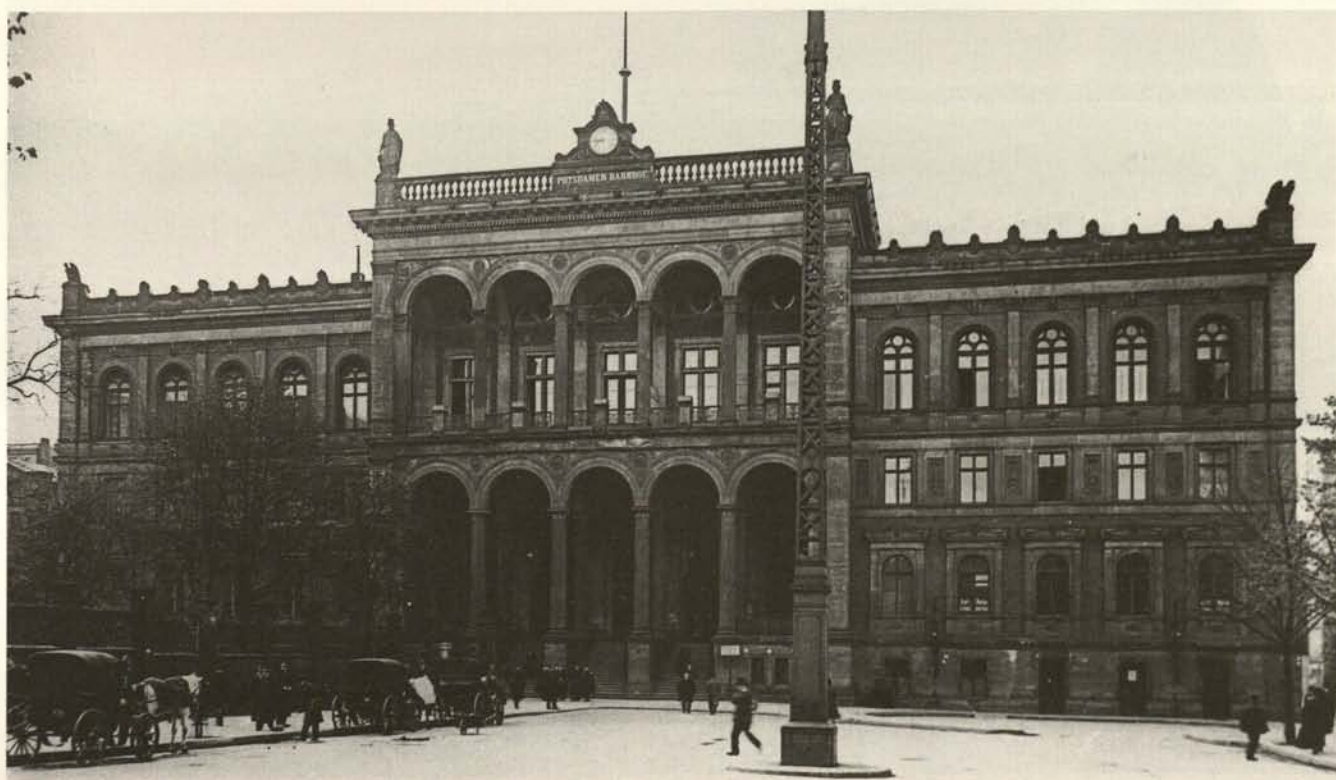
Abb. 50. Berlin, Potsdamer Bahnhof, Neubau der Architekten Quassowski, Doebner, Sillich und Weise, 1869-72 (Ende 19. Jahrhundert).
