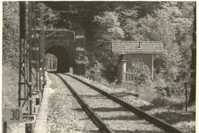
Abb. 95. Gotthardlinie am Vierwaldstättersee, Einspur-Streckenabschnitt von 1882 mit Tunnelportal, Streckenwärterunterstand, Läutwerk und Fahrleitungsmasten (z. T. aus der Zeit der Elektrifizierung, 1919).
