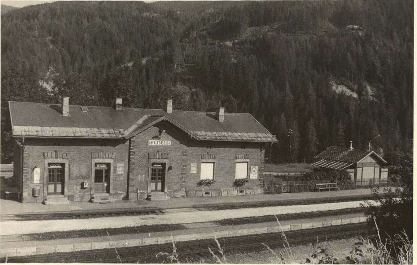
Abb. 90. Abfaltersbach (Osttirol), Aufnahmegebäude der sog. Pustertalbahn, errichtet 1870/71: Regeltypus der 1856 von Wilhelm Flattich entwickelten Normalien für die Kaiser-Franz-Joseph-Orientbahn.
