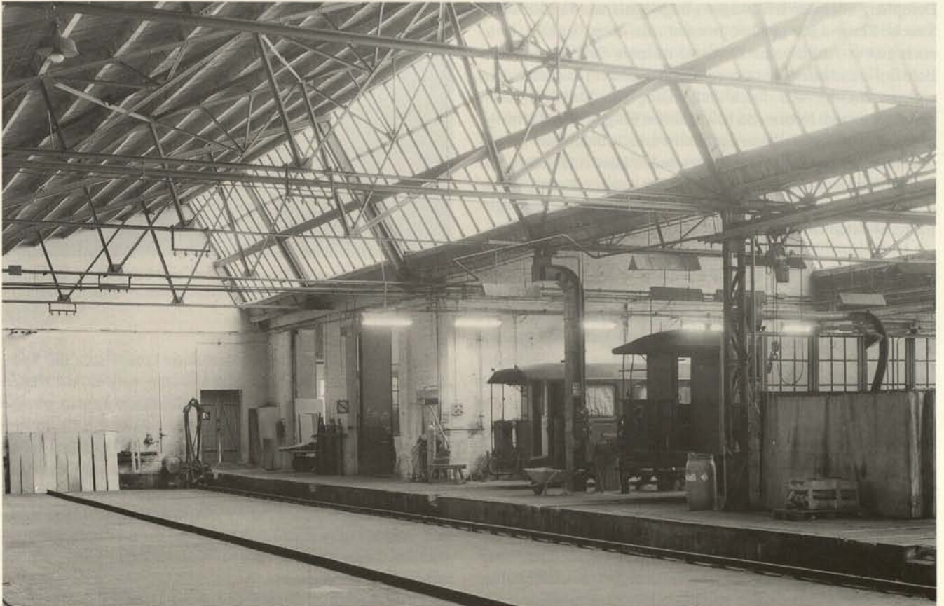
Abb. 20. Perleberg, Werkstatt-Halle der „Prignitzer-Kreiskleinbahnen“, errichtet 1911, als seltenes und weitgehend unverfälscht erhaltenes Beispiel einer Kleinbahnwerkstätte (Zustand 1992).
