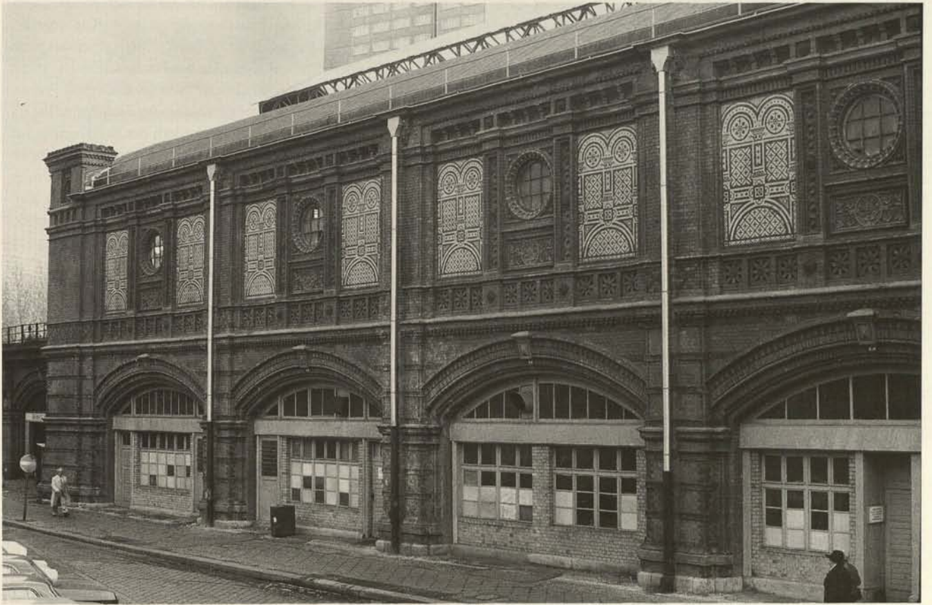
Abb. 60. Berlin, Stadtbahn-Bahnhof „Hackescher Markt“ (ehem. Haltestelle „Börse“), Nordfassade (Vorzustand).
