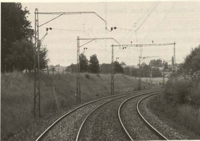
Abb. 94. Strecke Fribourg-Lausanne, Doppelspur mit alten Fahrleitungsmasten, Einschnitt mit Entwässerungsgraben (Führerstandsaufnahme).
