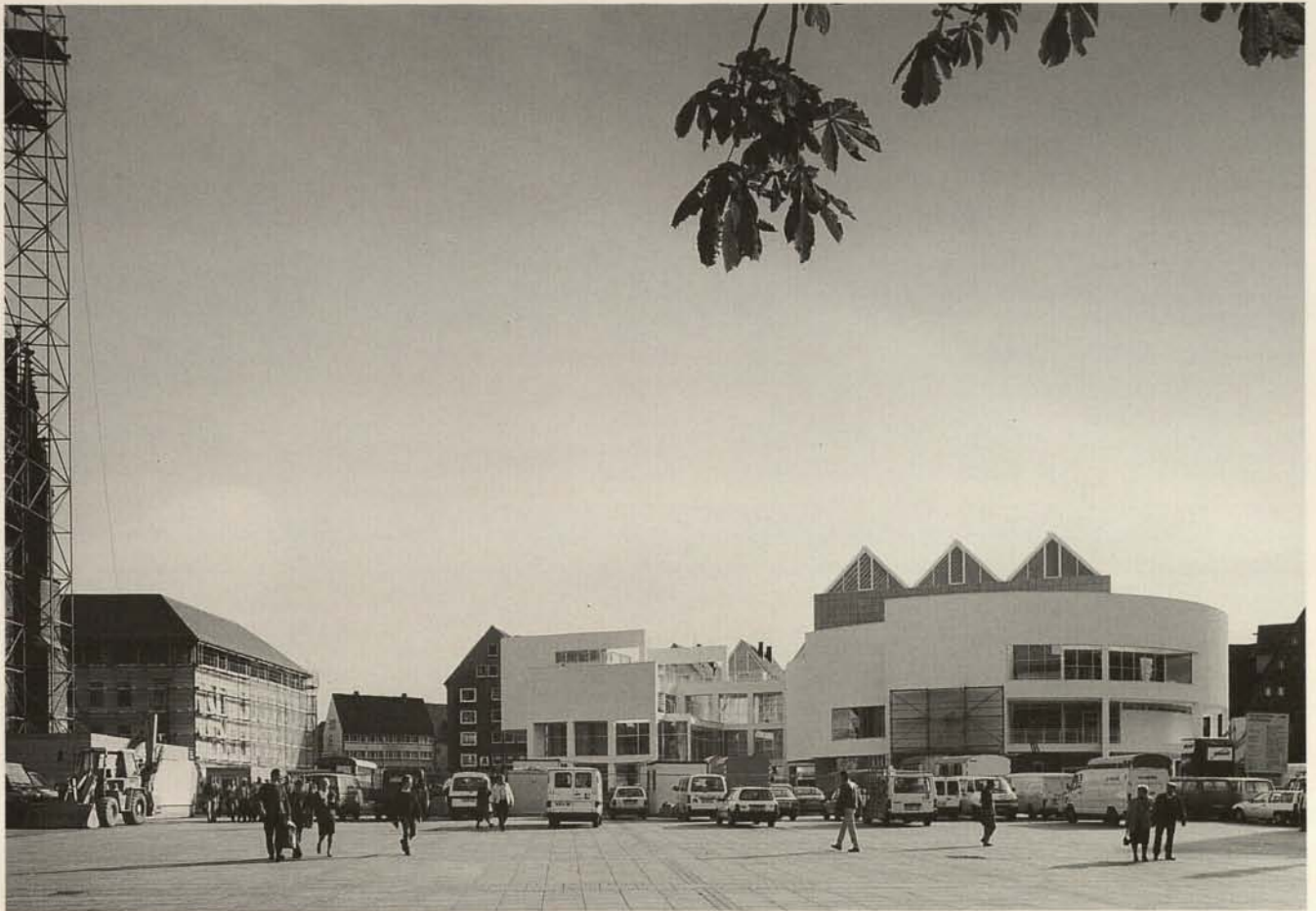
Ulm, Münsterplatz, Stadthaus von Richard Meier, Oktober 1993 vor der Fertigstellung
