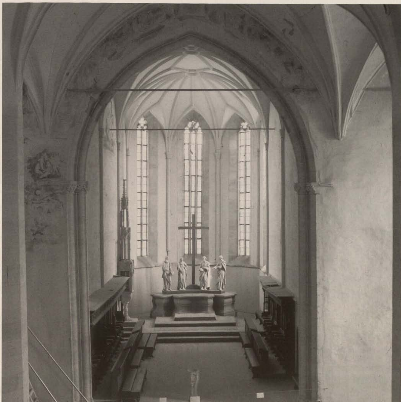
Bergkirche, Innenansicht nach Osten / Eglise haute, vue de l'intérieur vers l'est
