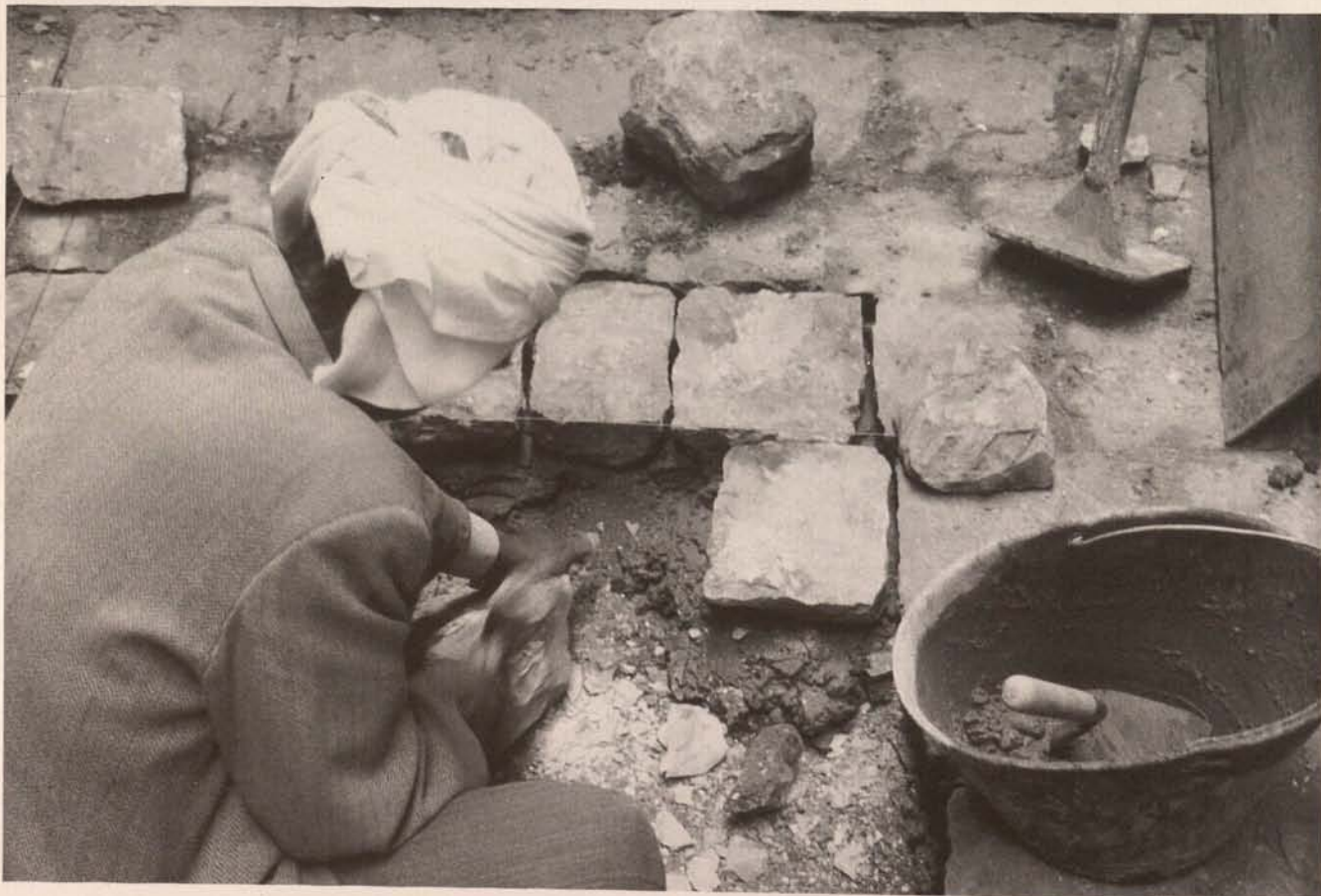
Abb. / Fig. 39. Steinpflasterarbeiten in Westpassage / Stone panning work in the west passageway
