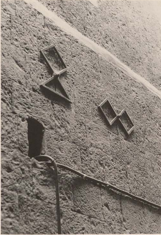
Abb. 17, 18. Westfassade; neue Maueranker im Steinmauerwerk Fig. 17, 18. West side; new wall anchor on the stone masonry
