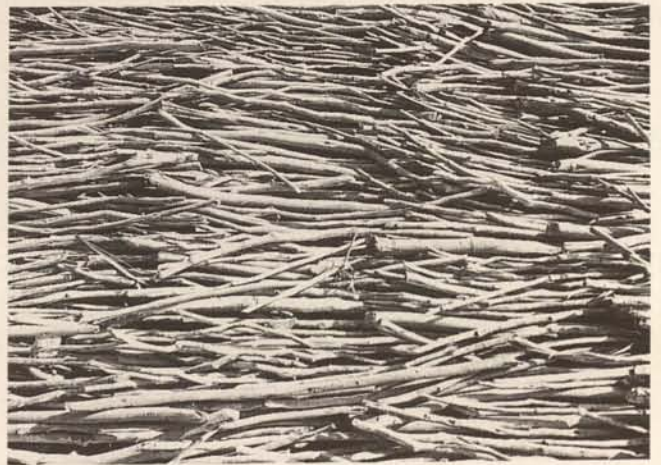
Abb. 89. Untersicht des Treppenlaufs nach dem Wiederaufbau mit alten Rundhölzern
