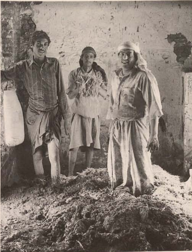
Abb. / Fig. 83. Stampfen der wiederaufbereiteten Lehmmischung für den Deckenauftrag / Compression of the reworked clay mixture for the floor covering
