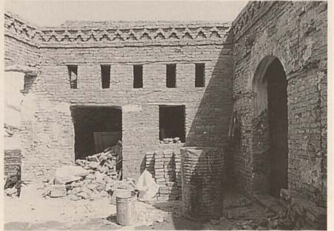
Abb. 87. Nach Teilabriß und Wiedererrichtung des Ziegelmauerwerks mit vorhandenen Ziegeln Fig. 87. After partial demolition and reconstruction of the brick masonry using old bricks
