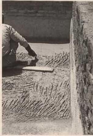
Abb. / Fig. 63. Flußkieselunterboden, gepackt für 1. Qadathaufrag / Subfloor of river pebblestone, packed for the 1 st application of qadath
