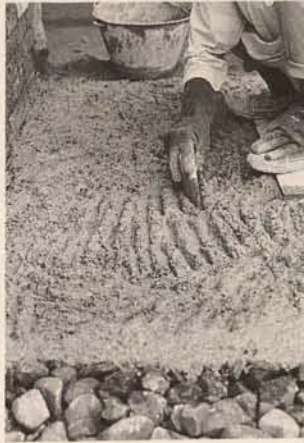
Abb. / Fig. 69. Schlagen einer Qadathschicht auf die Hofbrüstung / Pounding of a qadath layer applied to the parapet in the court
