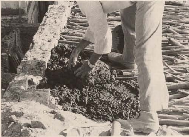
Abb. 24. Aufbringen der feuchten Lehmdecke, 4. Geschloß Fig. 24. Installation of the damp clay ceiling for the 4 th floor
