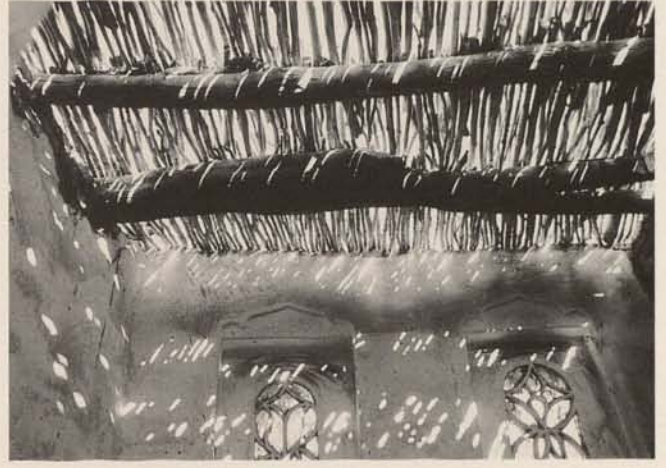
Abb. 23. Knüppelauflage von unten, 4. Geschloß Fig. 23. Brushwood layer seen from below, 4 th floor
