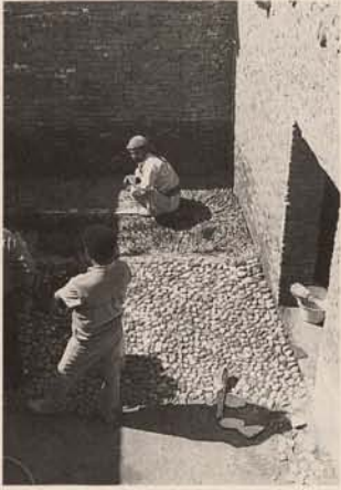
Abb. / Fig. 63. Flußkieselunterboden, gepackt für 1. Qadathaufrag / Subfloor of river pebblestone, packed for the 1 st application of qadath
