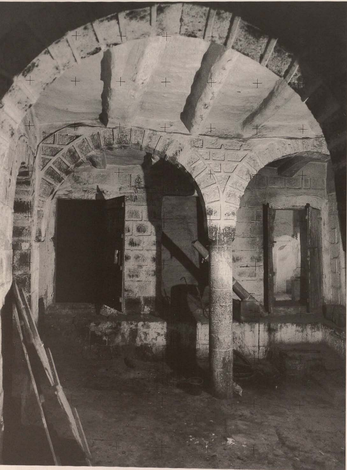
Abb. 11. Samsarat al-Mansurah; Erdgeschoß, zentrale Halle, nördliche Bogenstellung; Zustand 1988 Fig. 11. Samsarat al-Mansurah; central hall on the 1 st floor, north arch; 1988
