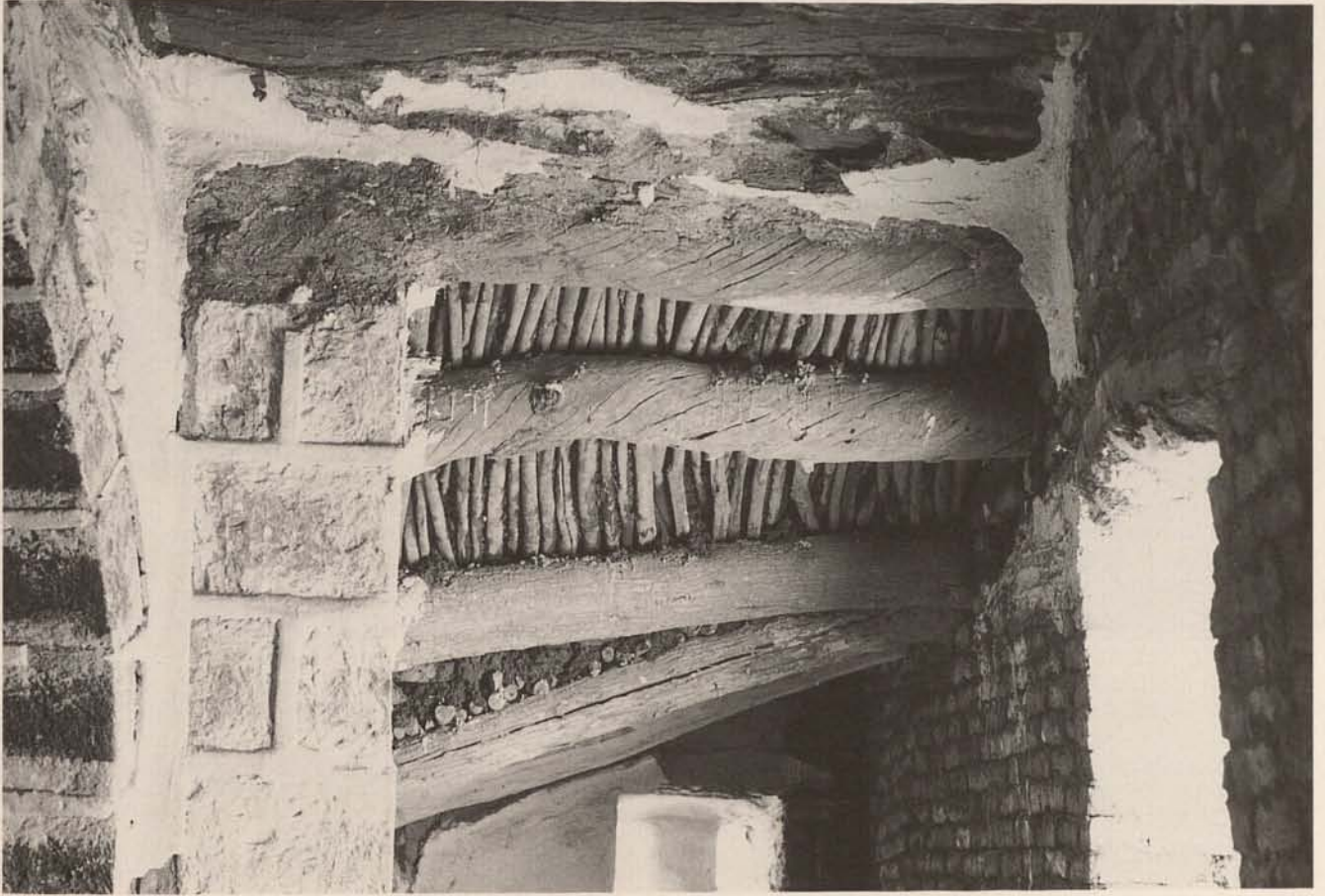
Abb. 89. Untersicht des Treppenlaufs nach dem Wiederaufbau mit alten Rundhölzern
