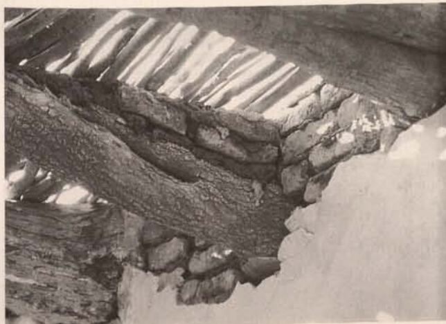
Abb. 26. Balkenaufleger mit Horizontalausgleich, 4. Geschloß Fig. 26. Joist support with horizontal adjustment, 4 th floor
