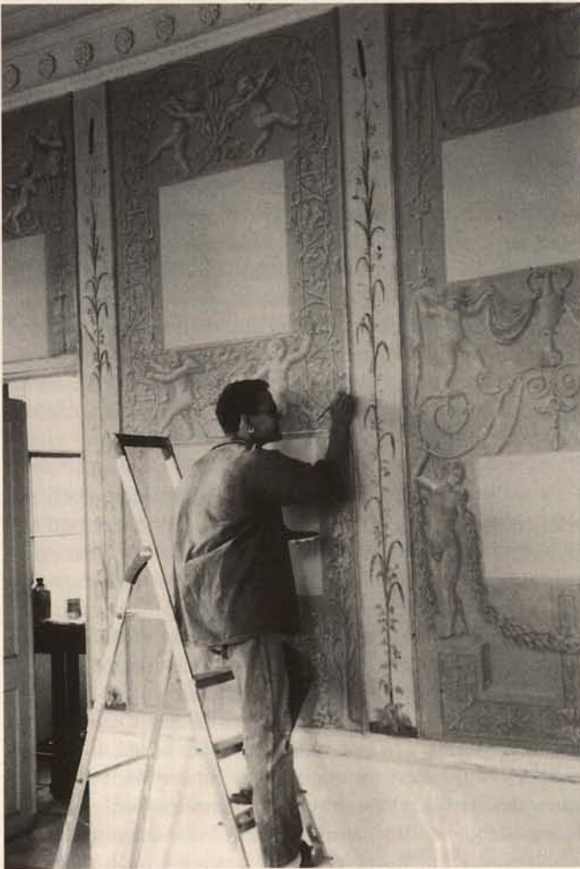
Restaurierungsarbeiten im Rhein-Schütz-Zimmer
