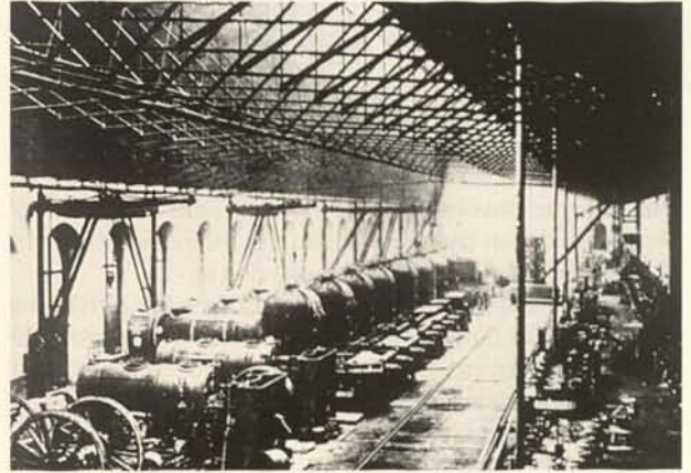
8. Lokomotivmontage in der Eisengießerei und Maschinenbauanstalt August Borsig, Berlin (1844, Erweiterung 1856), Dachtragwerk und Lokomotiven (Aufnahme um 1865).
