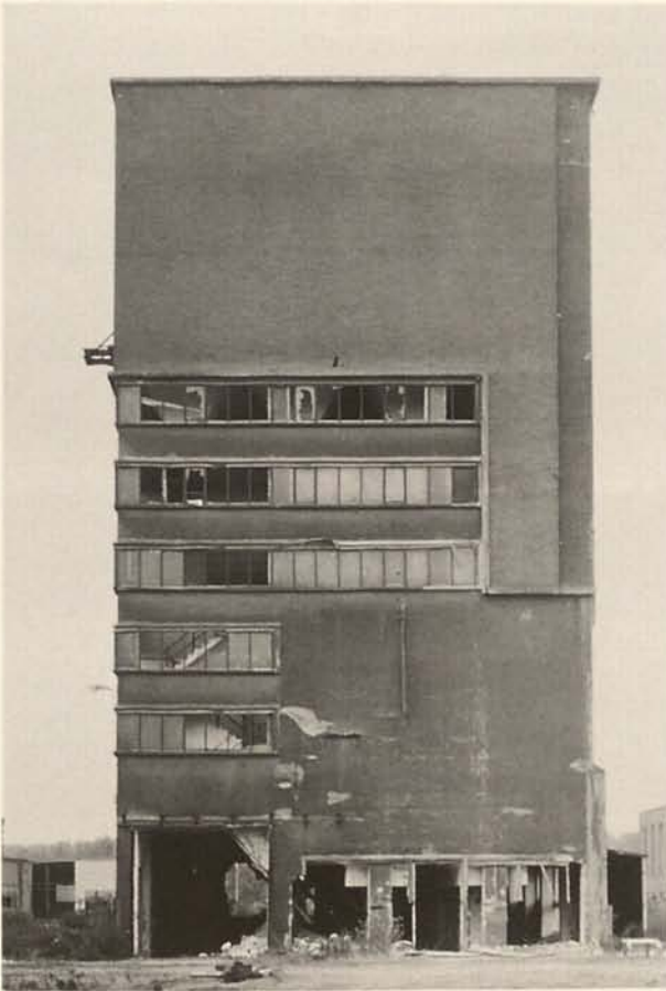
15. Kohlenwäsche von Alfred Fischer, errichtet um 1925 auf der Zeche Königsborn, Schacht 215 in Bönen-Altenböge bei Unna, gesprengt 1995.
