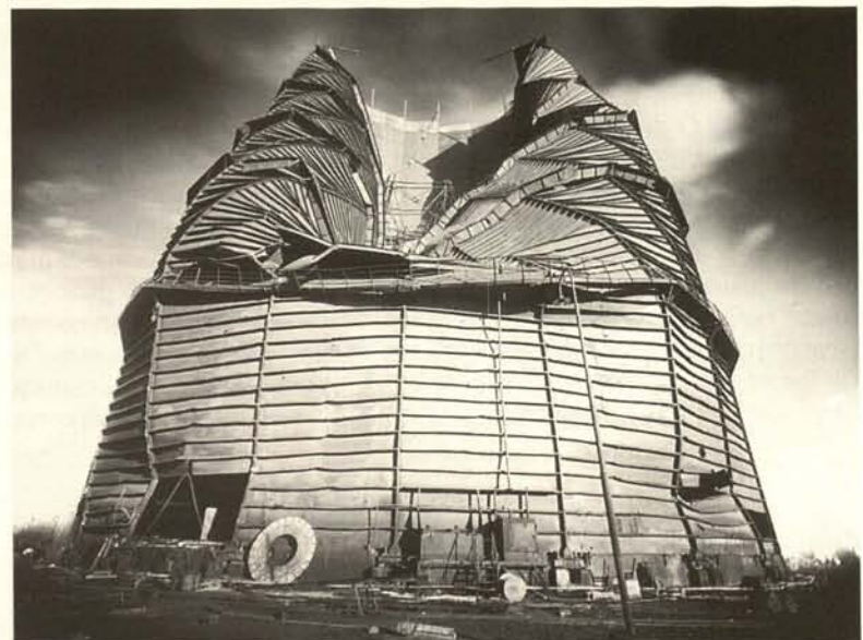
5. Das Kokereigelände nach den Kriegszerstörungen, um 1945. 6. Blick auf die Kokskohlentürme und Ofenbatterien, um 1955. 7. Sturmschaden am großen Scheibengasbehälter, 1949.
