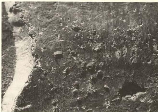
Abb. 80. Müstair, Klosterkirche St. Johann, Mittelapsis, Sockel, Oberflächendetail mit durch Salzsprengung bedingten Malschichtschäden (Zustand 1980).
