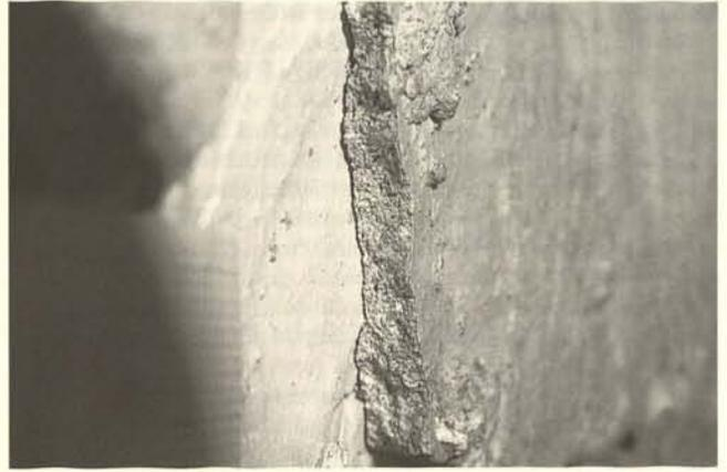
Abb. 205. Aosta, Kathedrale, Dachraum des Mittelschiffs, Südseite, Feld S3 noch vor der Freilegung: unter dem dicken Malputz (getüncht und verschmutzt) tritt der geweißte und sehr saubere Unterputz zutage (Zustand 1989).
