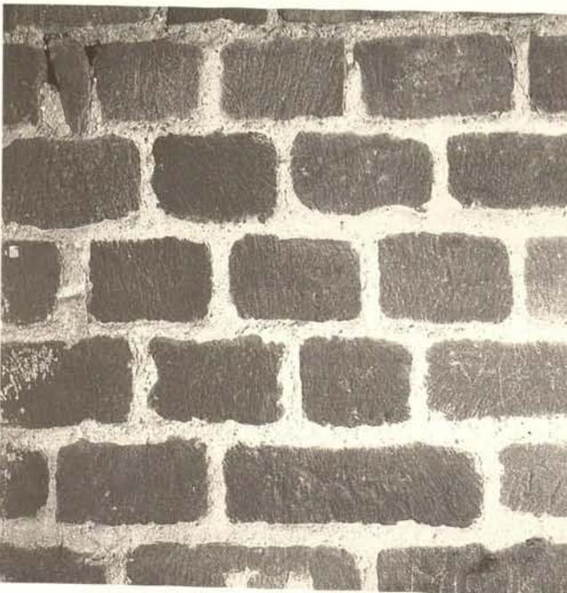
Abb. 97. Steinbach, Einhards-Basilika, Winterchor, Südwand, Detail des Mauerwerks mit Setzmörtelverstrich und Kellenritzung (Phase 4 zugehörig).
