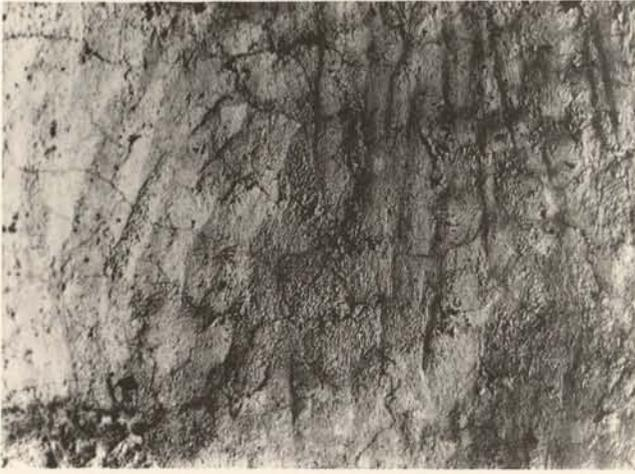
Abb. 65. Müstair, Klosterkirche St. Johann, Dachraum über dem Nordannex: Blendnischenfläche der äußeren Nordwand als charakteristisches Beispiel einer abgekelten Putzoberfläche.
