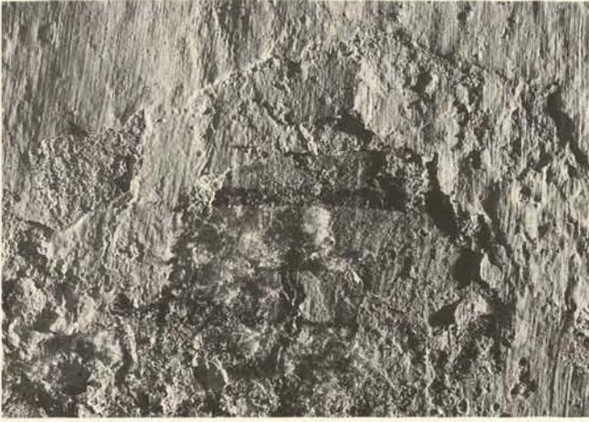
Abb. 171b. Regensburg, St. Emmeram, Ringkrypta, südlicher Ringgang, Außenwand, salzinduzierte Putz- und Malschichtschäden im Bereich des gerahmten Inschriftstreifens vor der Konservierung (Detail aus Abb. 171a).
