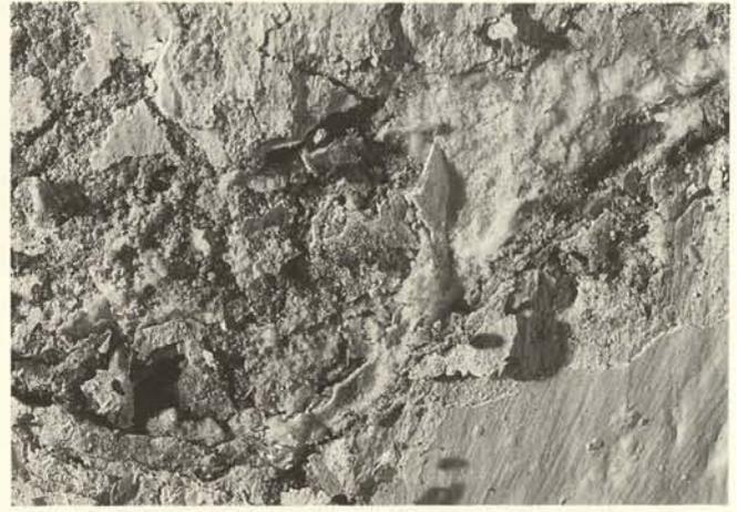
Abb. 171c. Regensburg, St. Emmeram, Ringkrypta, südlicher Ringgang, Außenwand, salzinduzierte Putz- und Malschichtschäden im Bereich des gerahmten Inschriftstreifens vor der Konservierung (Detail aus Abb. 171b).
