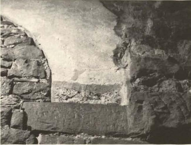
Abb. 98. Steinbach, Einhard's-Basilika, nördliches Seitenschiff, Südwand, erster Halbpfeiler von Westen, Detail mit partiell erhaltener Profilierung der Stirnfläche des Kämpfers.
