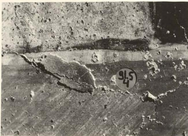
Abb. 78. Müstair, Klosterkirche St. Johann, Mittelapsis, Sockel: durch Salzausblühungen bedingte Malschichtverluste sowie Selbstfreilegung karolingischer Oberflächen durch Abplatzen des romanischen Intonaco im Ribbereich.
