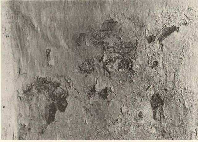
Abb. 171a. Regensburg, St. Emmeram, Ringkrypta, südlicher Ringgang, Außenwand, salzinduzierte Putz- und Malschichtschäden im Bereich des gerahmten Inschriftstreifens vor der Konservierung (Zustand 1987).
