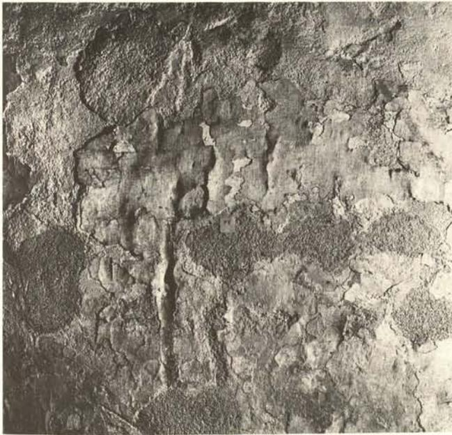
Abb. 112. Steinbach, Einhards-Basilika, Schadensdokumentation: sich trennende und deformierte Malschichten der Phasen 1, 3 und 8.
