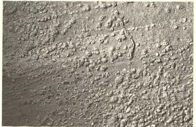
Abb. 204. Aosta, SS. Pietro e Orso, Dachraum des Mittelschiffs, Nordseite, Feld N4, Detail mit teils noch geschlossenen, teils bereits aufgeplatzten Salzpusteln: Beispiel für sog. Monitoring mit Kleinbildaufnahmen im Maßstab 1:1 (Größe des Ausschnitts ca. 36 x 24 mm; Zustand 1991).
