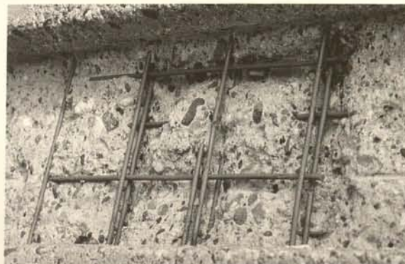
Abb. 9 Vorbereiteter Instandsetzungsbereich an der Außenfassade des Beethovensaals
