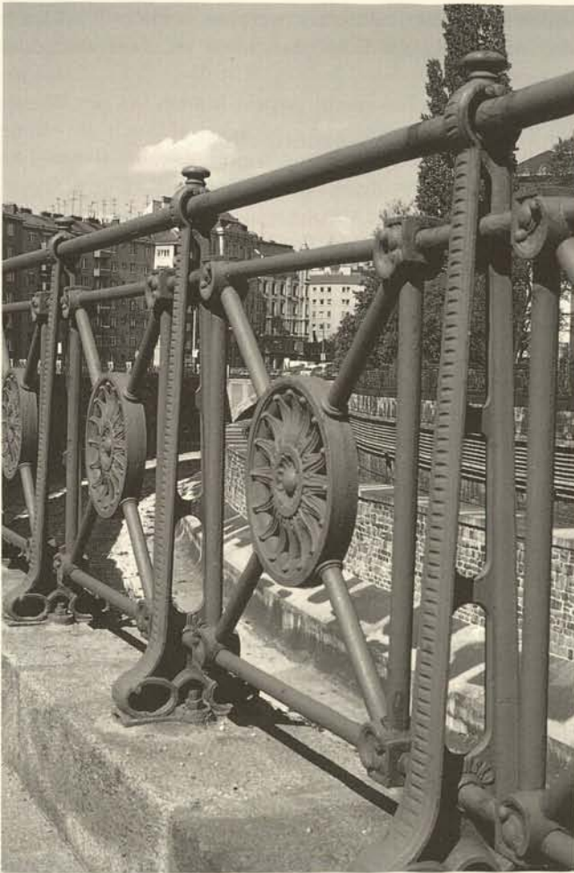
Abb. 4. Wien, historische Stadtbahnanlage, sogenanntes Otto-Wagner-Gitter, Bestand im Bereich der Wientallinie
