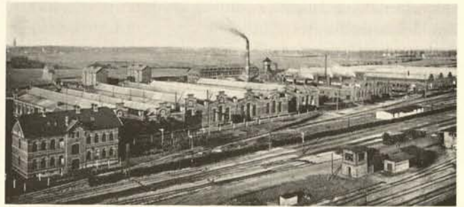
Abb. 1. Krefeld-Oppum, Ausbesserungswerk: 1892 wurde die erste Ausbaustufe des Ausbesserungswerks eröffnet, seit 1898 wurden hier auch Lokomotiven gewartet.
