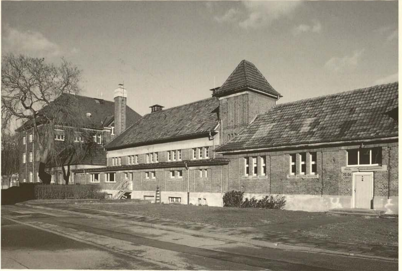
Abb. 4. Das Verwaltungsgebäude des Ausbesserungswerkes Jülich (1914-1918) ist Teil einer streng achsial gegliederten, repräsentativen Straßenfront der Gesamtanlage.
