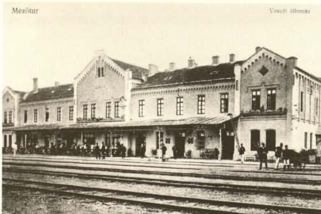
Abb. 7. Bahnhofsgebäude Mezötúr, das von den Standardentwürfen abwich, um 1910
