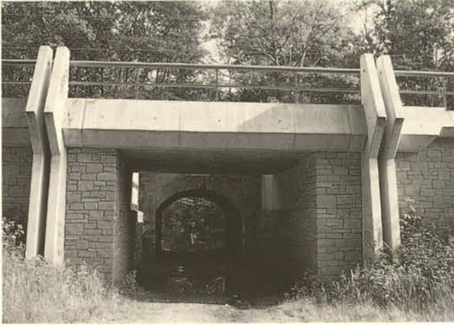
Abb. 1. Wegen einer Gleisfelderweiterung wurde neben einer bestehenden Gewölbekonstruktion eine neue Brücke gebaut, die wie ein Bilderrahmen den Blick auf das alte Bauwerk inszeniert.
