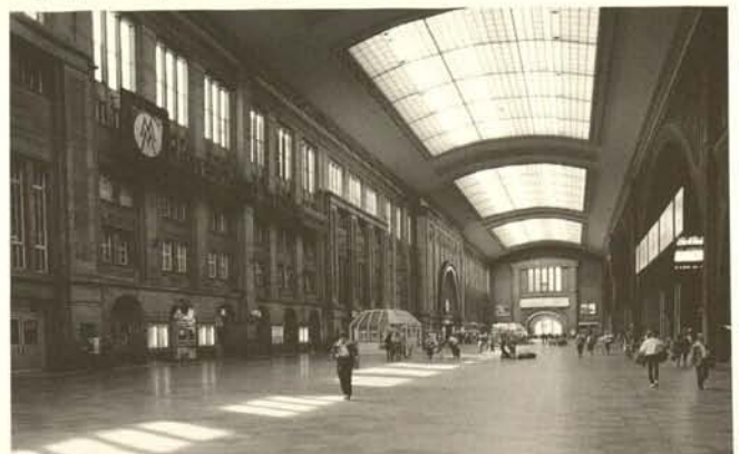
Leipziger Hauptbahnhof, Querballe vor dem Umbau
