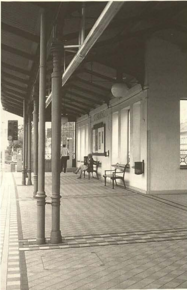
Abb. 8. Wien, Empfangsgebäude Ottakring, Perrongebäude nach der Sanierung
