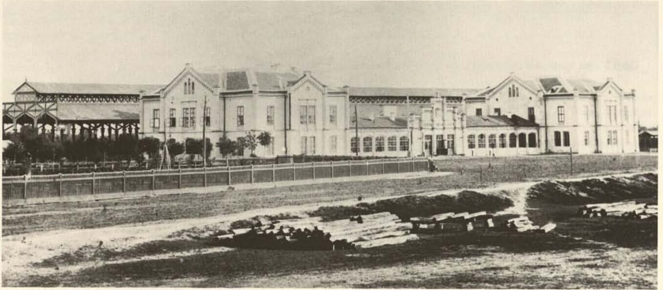
Abb. 3. Historische Darstellung des Bahnhofs in Debrecen. Hinter dem Empfangsgebäude ersten Ranges steht eine gezimmerte Bahnsteighalle von beachtlicher Länge, die das Empfangsgebäude noch übertrifft. Holzhallen wurden außer in fünf Städten mit Empfangsgebäuden ersten Ranges (Debrecen, Arad, Großwardein, Miskolc und Kaschau) auch in den Bahnhöfen von Szolnok und Püspökladány errichtet, die eigentlich nur über Empfangsgebäude zweiten Ranges verfügten.
