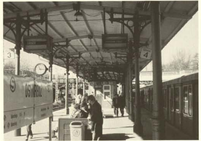
Abb. 6. Berlin-Lichtenberg, Bahnhof Ostkreuz, historische Dachkonstruktion
