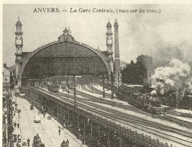
Abb. 1. Antwerpener Hauptbahnhof, Gleishalle von Süden, Blick auf die erhöhte Trasse
