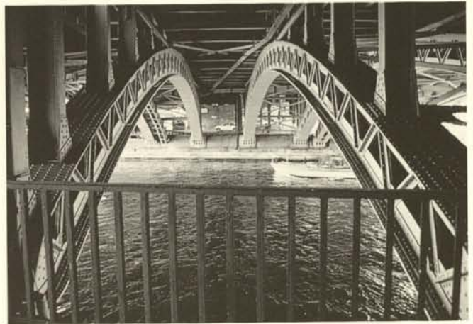
Abb. 3. Berlin, Untersicht der Spreebrücke
