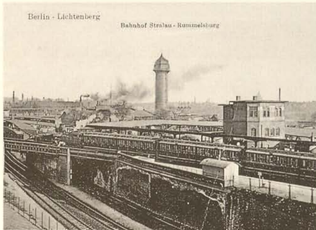
Abb. 4. Berlin-Lichtenberg, Bahnhof Stralau-Rummelsburg (heute Ostkreuz genannt) mit historischem Wasserturm (Aufnahme 1912)
