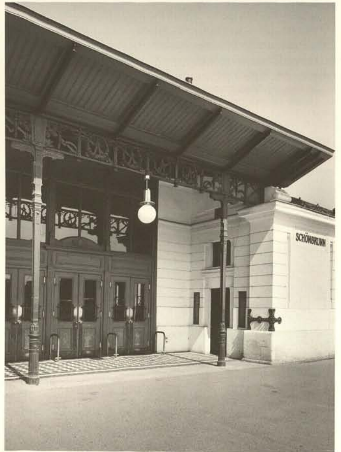
Abb. 12. Wien, Station Schönbrunn, Hauptansicht, Vorballe mit Eisenträger
