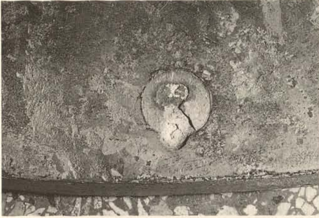
Abb. 4. originale Bohrlöcher, gefüllt mit Kalkzementmörtel
