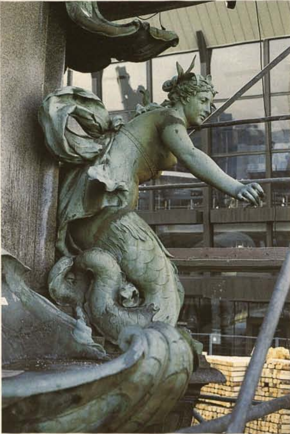
1. Leipzig, Mendebrunnen; Zerstörung der ursprünglichen Füge-technik und Patinaschäden an Oberarm und Beinansatz der 1886 bei Miller in München gegossenen Nereide durch nachträgliche Schweißungen
