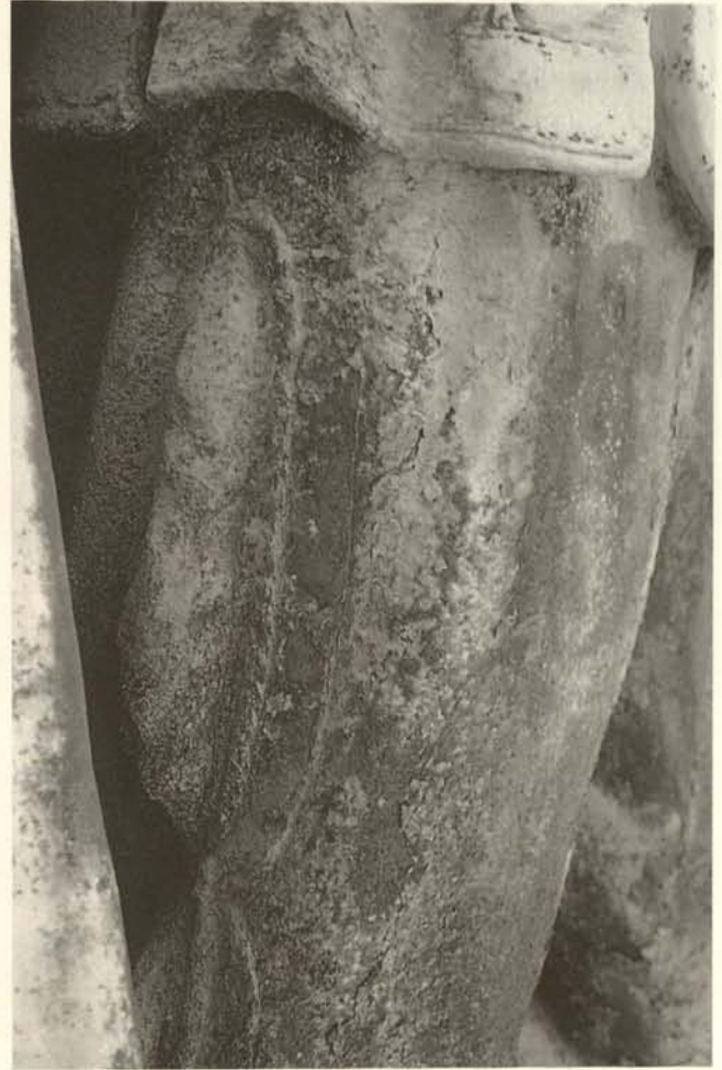
Abb. 7. Fürst-Ludwig-Statue, Schadensbild am Beinkleid, vor der Restaurierung, 1994
