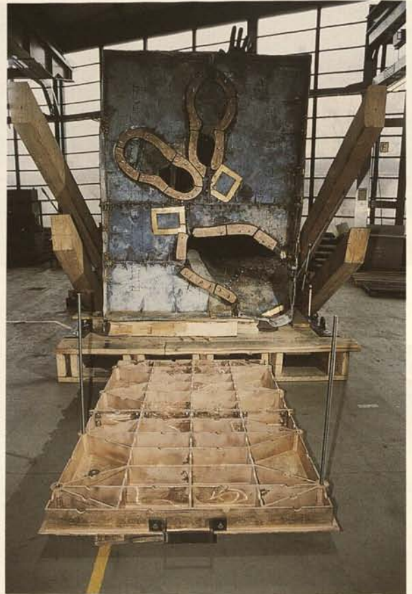
2. Berlin-Tiergarten, „Rotarmist“; Stabilisierungsmaßnahmen in der Plinthe des „Rotarmisten“, im Vordergrund die neue bronzenere Unterkonstruktion für die statisch sichere Wiederaufstellung des Denkmals
