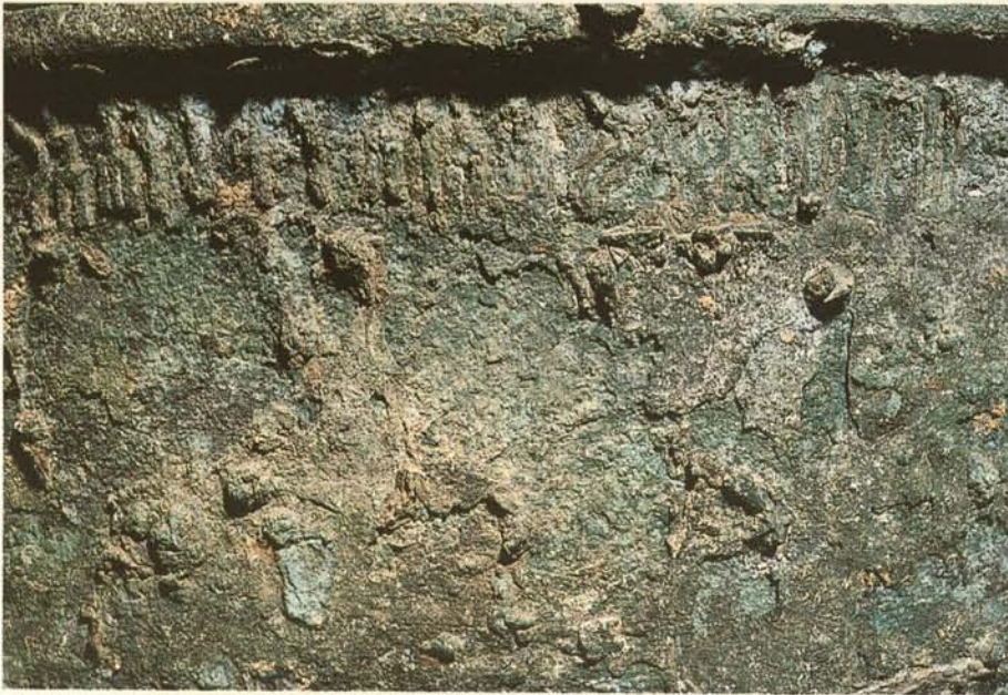
2. Partie mit abgeplatzter Oberfläche
