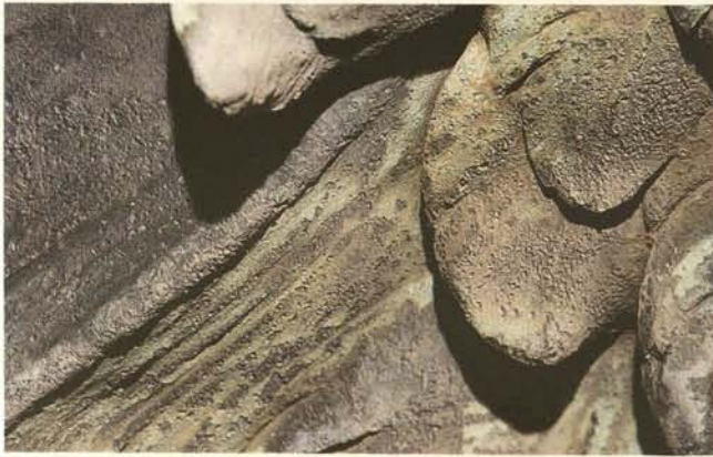
2. Leipzig, Detail vom Mendebrunnen: Korrosionsschäden (Lochfraß) unter dem Flügel eines Hippokampen
