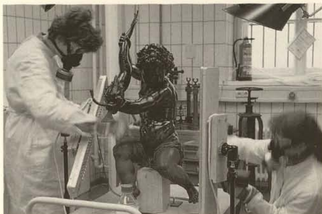
Abb. 9. Zum Aufbringen des Wachsüberzugs wird die Bronze kontrolliert erhitzt
