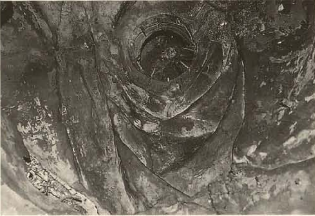
Abb. 3. Innenansicht des Reiterstandbilds Friedrich Wilhelms IV. Montierung des Kopfes mit Eisenzapfen und Messingverschraubungen
