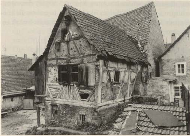
Abb. 3. Mainbernheim, Berggasse 6, Seitengebäude von 1593(i) von Osten, vor der Instandsetzung. Gemauerter Unterstock weitgehend original, Fachwerkwand Ost und Nord im 18./19. Jh. unter Verwendung vieler Altteile umgebaut. Photo 1977.
