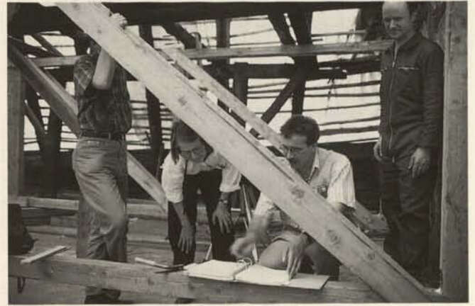
Abb. 17. Bad Windsheim, Kornmarkt 4. Regelmäßige Zusammenkünfte des Teams zur Fortschreibung des technischen und denkmalpflegerischen Konzepts und zur Beratung der Leistungen; für die Denkmalpflege: Ursula Mandel, für die Tragwerksplanung: Walter Schwarz, für die ständige denkmalpflegerisch-restauratorische Betreuung: Helmuth Feser. Verdeckt: Volontär Thomas Wenderoth. Für die Bauforschung und Definition der baugeschichtlichen Bedingungen: der Verfasser (hier photographierend). Beteiligt waren ferner Architekt Karlheinz Lieberger, die Zimmererfirma Günter Steinmetz und Jürgen Schlosser, begleitende Dokumentation.
