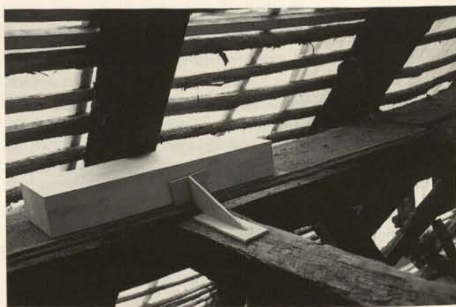
Abb. 14. Bad Windsheim, Kornmarkt 4. Kehlbalckenanschluß im Modell, noch im Diskussionsstadium. Der Randgurt soll gestalterisch noch verbessert werden. Das Anschlußblech (hier noch ein Sperrholzmodell) kann so ausgeführt werden. Bei einer zimmermannsmäßigen Reparatur des alten Kehlbalckenanschlusses würde dieser zerstört. Die gefundene Lösung hat den Vorteil, daß die historische Blattung und das charakteristische Bundzeichen unberührt bleiben, die Aussteifung über den Längsgurt verbessert und die letzte Diele der Bauphase 1488 so eingebunden wird, daß sie niemand mehr herausreißen kann (die vollständig erhaltene Diele wurde vom Voreigentümer als Beginn einer „Sanierung“ herausgerissen).
