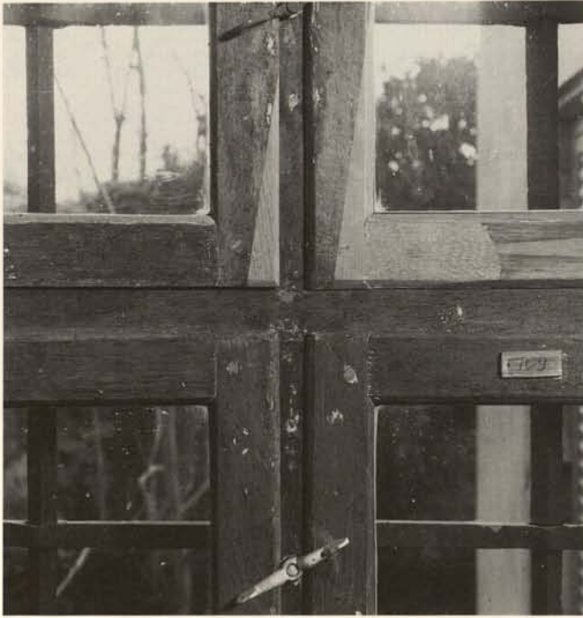
Abb. 11. Waghäusel (Baden-Württemberg), Eremitage. Sorgfältige handwerkliche Reparatur eines barocken Eichenfensters.
