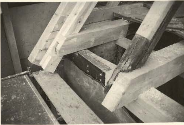
Abb. 15. Die rein zimmermannsmäßige Reparatur (heute meist eine Kopie der äußeren Gestalt) führte in diesem Fall zu einer völligen Erneuerung und ist daher denkmalpflegerisch abzulehnen. Der mittlere der Dachfüße wurde mißverstanden; er war im Original leicht verdreht und gehörte zu einem Walmgespärre. Der Befund wurde mit der Reparatur beseitigt, so daß die Konstruktion von 1391(d) nun falsch verstanden wird. Da solche Originale mittlerweile sehr selten sind, ist jedes einzelne für die Rekonstruktion der Entwicklung der Dachwerke von großer Bedeutung. Konzeptionelle Entscheidungen dürfen daher nicht ausschließlich einem tüchtigen Zimmerer, Tragwerksplaner oder Architekten überlassen bleiben. Im Team darf der Baugeschichtler nicht fehlen.
