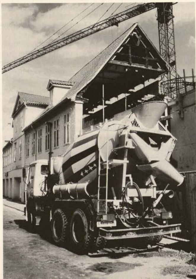
Abb. 9. Lüneburg (Niedersachsen). Stadtsanierung. Unter Beibehaltung der Fassade wird das Haus umfassend erneuert. Entgegen dem Anschein wird nach Abschluß der Baumaßnahme nur noch wenig von der alten Substanz übrigbleiben.
