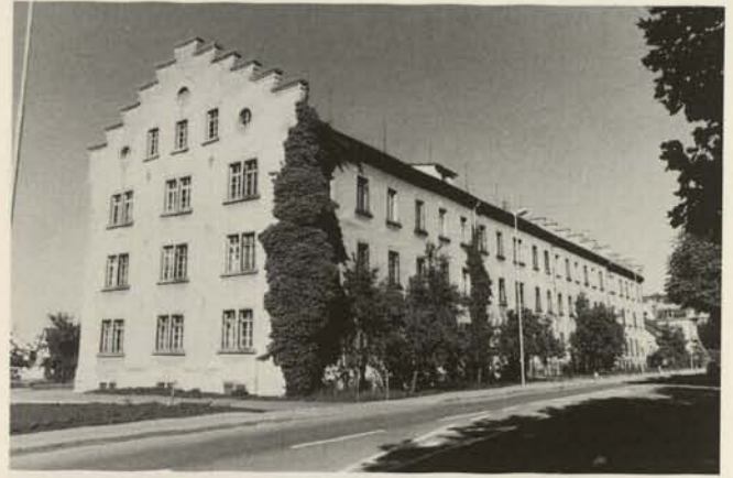
Abb. 8. Tabaklager Herbolzheim, Gesamtansicht
