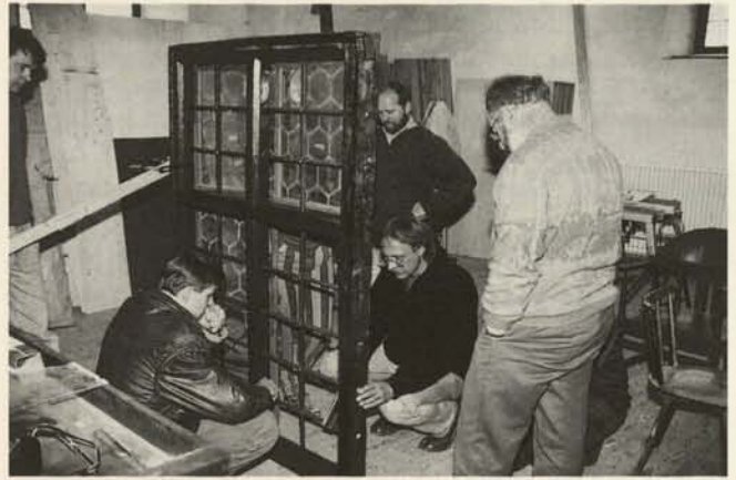
Abb. 10. Thierhaupten, Begutachtung einer Fensterstockreparatur während eines Handwerkerkurses mit Restaurator Martim Saar 1991. Inzwischen werden aufgrund erheblich gesteigener Erfahrung Fensterstöcke für die Reparatur kaum mehr ausgebaut.
