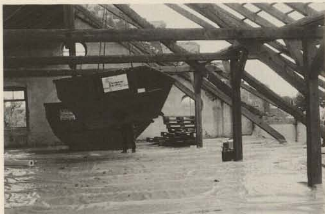
Abb. 6. Selektiver Rückbau eines Gebäudes
