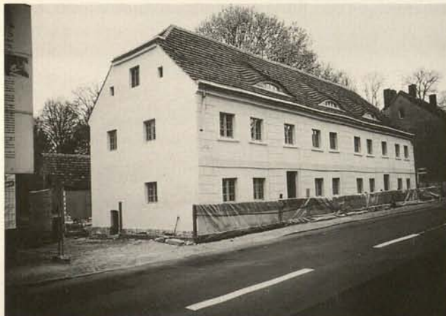
Abb. 4. Landarbeiterhaus in Berlin-Schulzendorf, um 1775. Lieferung von Eichenholz für die Restaurierung der Fenster, Kieferbalken, alte Dielen, Fenster- und Türbeschläge, Biberschwänze, altes Fensterglas, alte Holzfußböden.
