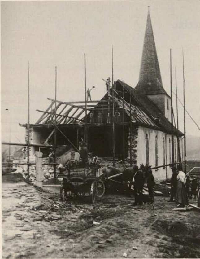
Abb. 2. Rückbau einer Kirche
