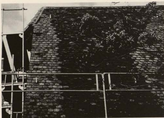
Abb. 8. Würzburg (Bayern). Die Reparaturmaßnahmen haben die Fläche der handgestrichenen Biberschwanzziegel wohl verringert, doch ist im Gegensatz zu einer vollständigen Neueindeckung die historische Kontinuität gewahrt.
