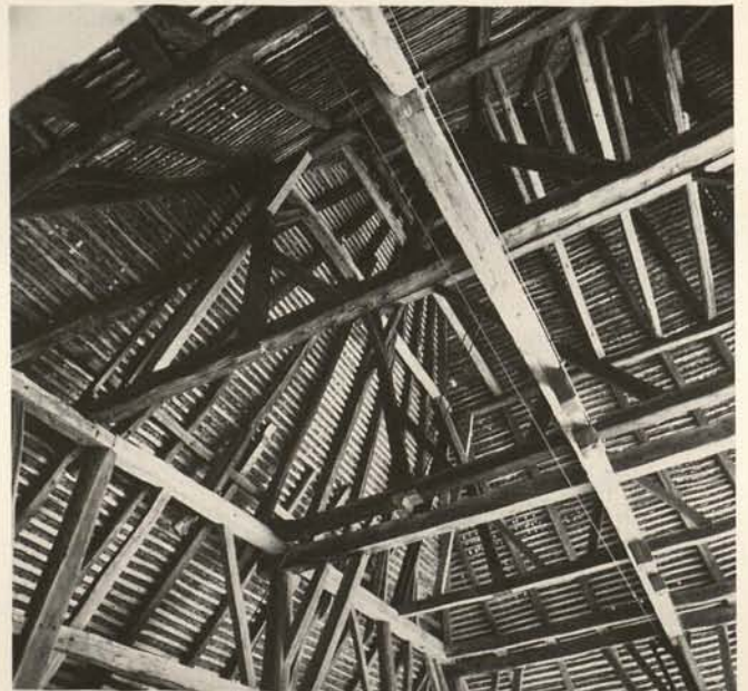
Abb. 20. Blick in den Dachraum. In Bildmitte ist die Abspannung der mittleren Stuhlsäule zu erkennen.
