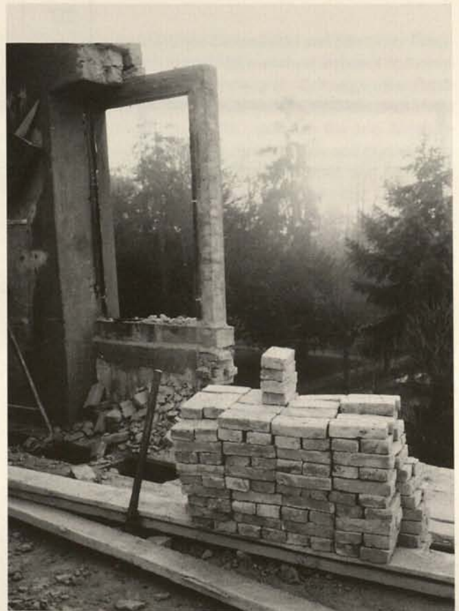
Abb. 12. Bergung von Mauerziegeln und Gewänden aus Sandstein
