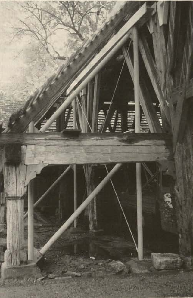
Abb. 12. Abseite mit eingestellten Stützgerüst. Der Traufräger folgt der Krümmung des Längsrähms.
