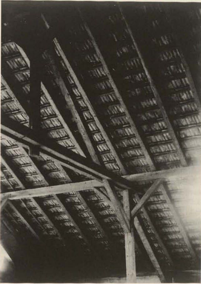
Abb. 7. Tabaklager Herbolzheim, Dachstuhl von innen
