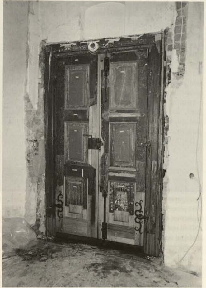
Abb. 3. Domäne Berlin-Dahlem, Eingangstor, Restaurierung mit altem Eichenholz, Ergänzung der Beschläge.
