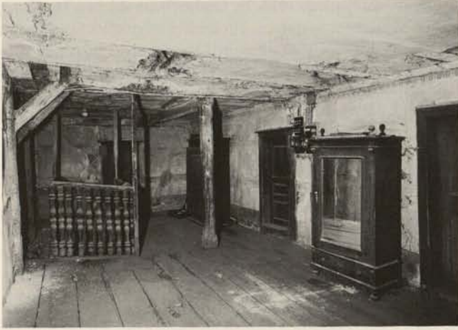
Abb. 1. Mainbernheim, Haus Beyer, Berggasse 6, Diele im Oberstock von 1591(i) mit zeitgleicher, geringfügig umgebauter Treppe sowie Türen aus verschiedenen Perioden, vor der Instandsetzung, 1977.
