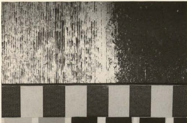
Abb. 4. Ursprünglich blanke Stahlflächen wurden entrostet, die Rauhtäler dabei aber nicht einplaniert.
