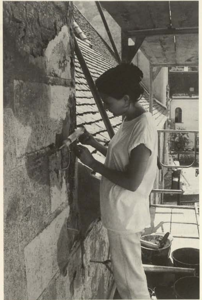
Abb. 6. Kartause Mauerbach, Bibliothek, Hinterfüllung nach Befeuchtung mit Sinterwasser
