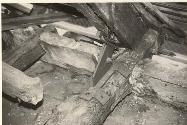
Abb. 13. Bad Windsheim, Kornmarkt 4. Dachfuß-Reparaturmodell in der letzten und endgültigen Version, bereits aus Stahl gefertigt. Hier ist angesichts des Holzzustands keine reine Reparaturmethode wie in Abb. 15 ausführbar, da das zu einer kompletten Erneuerung des Knotens führen würde. Die originalen Füße von 1318 müssen ungeschmälert erhalten bleiben. Der große Vorteil dieser Lösung ist außerdem, daß die Aufmauerung zwischen den Bundbalken und ihre Farbfassung im Anschluß an die Balken völlig unberührt erhalten bleiben, sofern mit der nötigen Sorgfalt gearbeitet wird.
