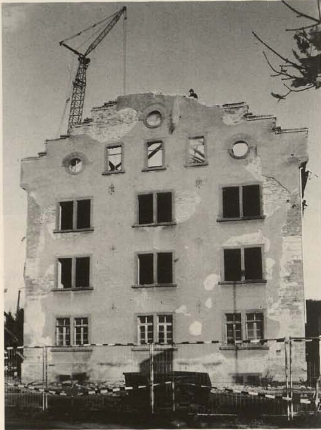
Abb. 10. Teilweise entkernter Giebel, Dachstuhl und Fenster
