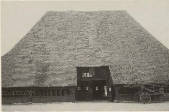
Abb. 2. Nordseite des „Alten Bauhofs“ nach der Instandsetzung.
