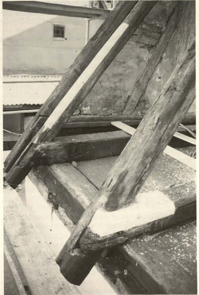
Abb. 15. Die rein zimmermannsmäßige Reparatur (heute meist eine Kopie der äußeren Gestalt) führte in diesem Fall zu einer völligen Erneuerung und ist daher denkmalpflegerisch abzulehnen. Der mittlere der Dachfüße wurde mißverstanden; er war im Original leicht verdreht und gehörte zu einem Walmgespärre. Der Befund wurde mit der Reparatur beseitigt, so daß die Konstruktion von 1391(d) nun falsch verstanden wird. Da solche Originale mittlerweile sehr selten sind, ist jedes einzelne für die Rekonstruktion der Entwicklung der Dachwerke von großer Bedeutung. Konzeptionelle Entscheidungen dürfen daher nicht ausschließlich einem tüchtigen Zimmerer, Tragwerksplaner oder Architekten überlassen bleiben. Im Team darf der Baugeschichtler nicht fehlen.
