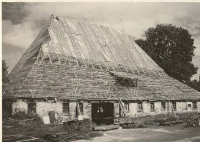
Abb. 4. Südseite des „Alten Bauhofs“ während der Instandsetzung.
