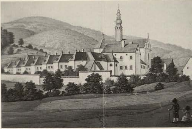
Abb. 1. Kartause Mauerbach nach der Aufhebung um 1792, Instandsetzung durch einheitliche Kalktünche
