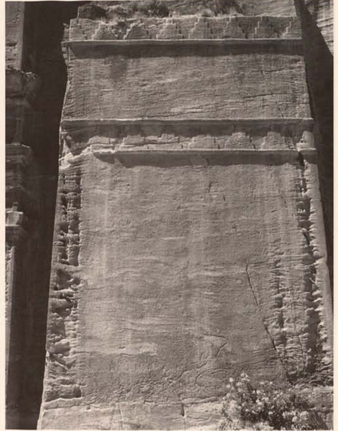
Abb. 13. Alveolenbildung, deutlich durch Schäden im Gesims verursacht Fig. 13. Alveoles, evidently caused by damages in the cornice
