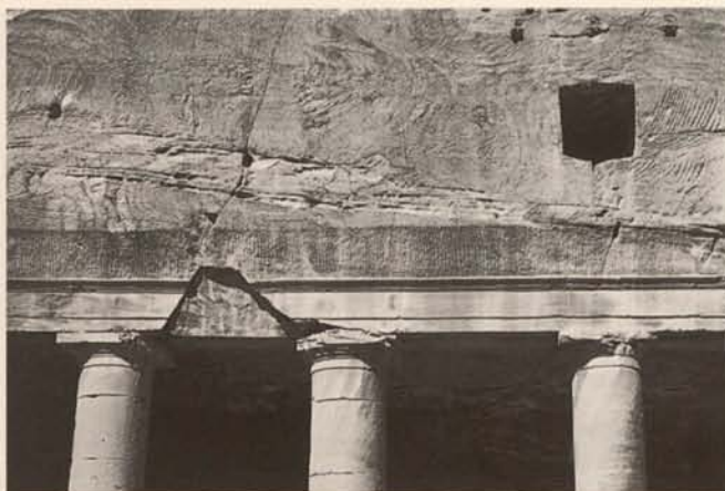
Abb. 5. Urnengrab, Peristyl, schrägverlaufender tektonischer Riß mit Absplitterung im Gebälk
