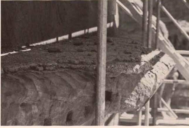
Abb. 15. Grab 636, mehrfache Mörtellage auf dem Hauptgesims
