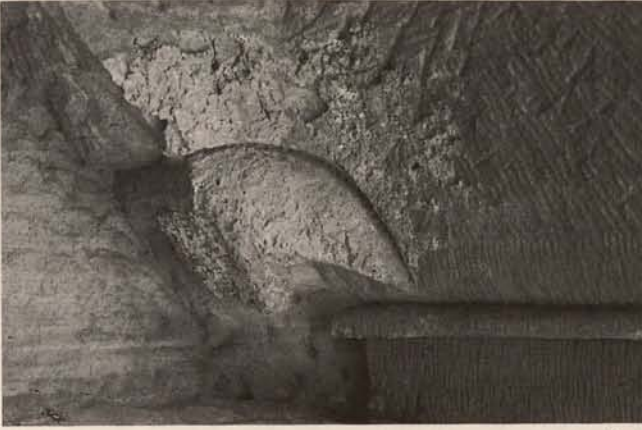
Abb. 30. Modelliertes Stuckmotiv am rechten Kapitell Fig. 30. Modelled plaster motif on the right capital
