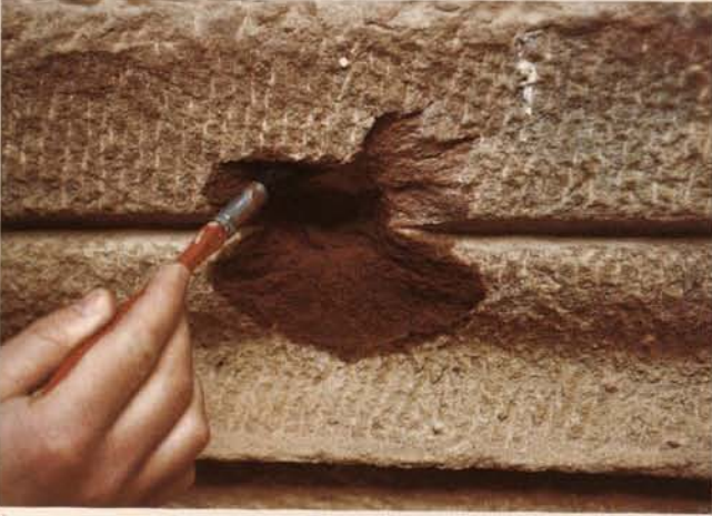
1 Monument 825, Einschußloch, Vorzustand, Trockenreinigung
