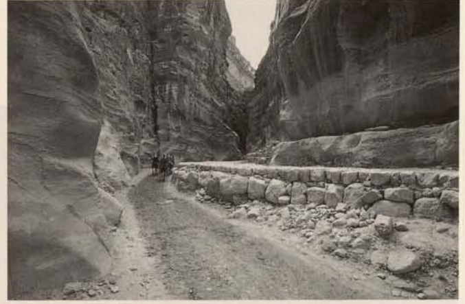
Abb. 16. Siq, Unterbau der Straßenpflasterung Fig. 16. Siq, underlayer of the pavement
