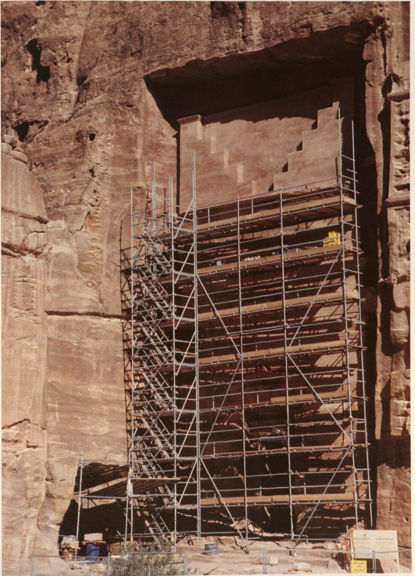
Monument 825 nach der Teilausrüstung Tomb 825 after partial removal of the scaffold
