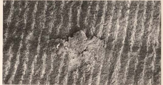
Abb. 28. Profilarbeitung mit dem Flacheisen Fig. 28. Dressing the profile with a flat chisel
