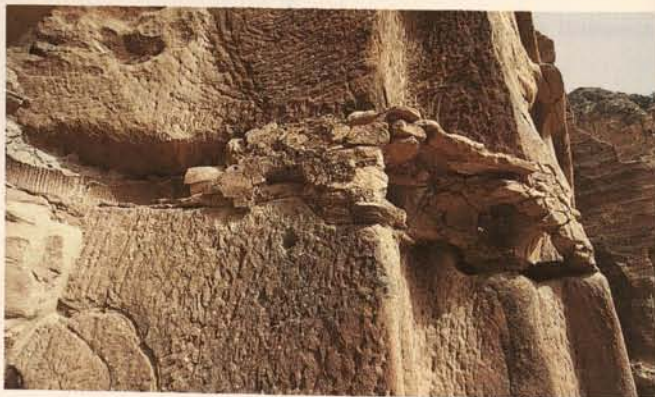
5 Bearbeitungsspuren von Flach- und Zahneisen 5 Tool marks of flat and tooth chisel
