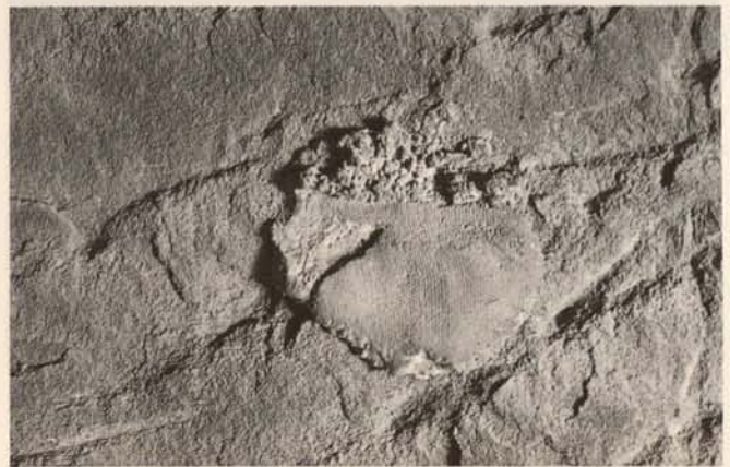
Abb. 19. Mörtelreste mit dem Abdruck eines textilen Musters Fig. 19. Mortar patches with textile impressions
