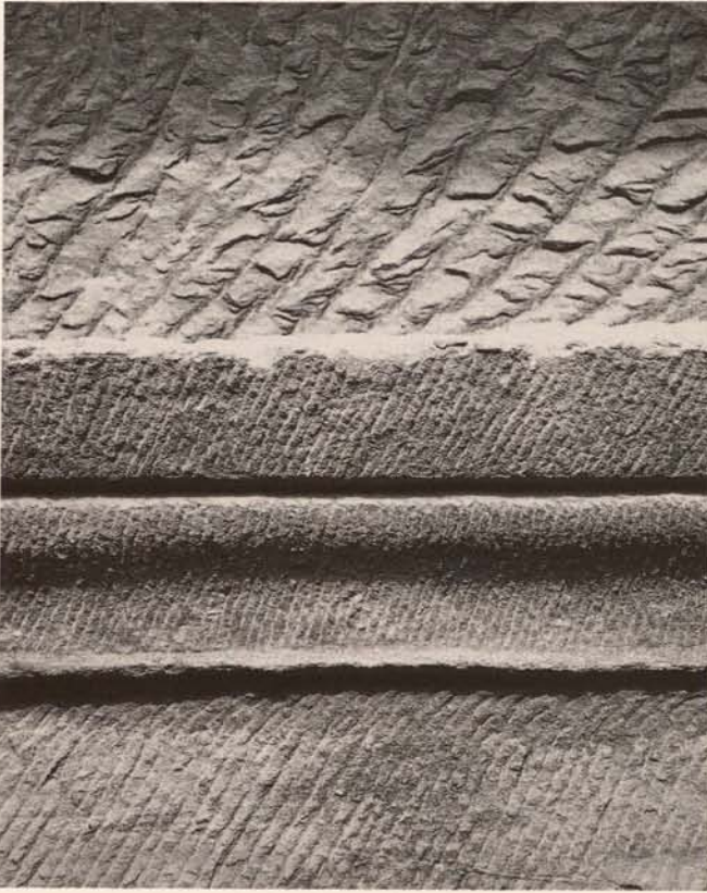
Abb. 26. Diagonale Zurichtung des Steins mit dem Spitzeisen Fig. 26. Diagonal dressing of the stone with a pointed chisel
