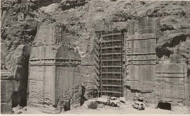
Abb. 1. Gerüst an Monument 825
