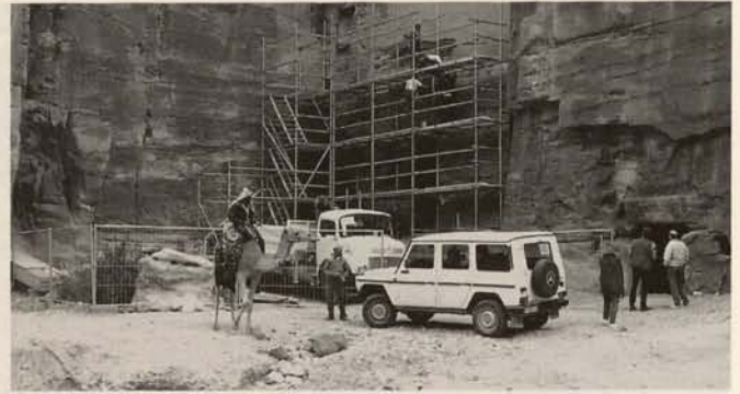
Abb. 7. Gerüstaufbau an Monument 825
