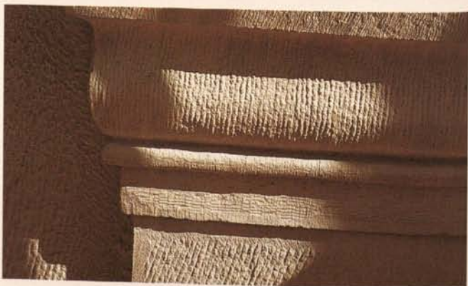
5 Bearbeitungsspuren von Flach- und Zahneisen 5 Tool marks of flat and tooth chisel
