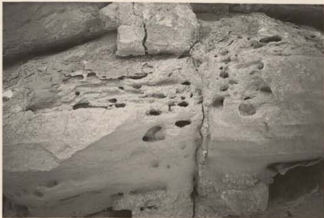
Abb. 1. Lochbildung durch differentielle Erosion
