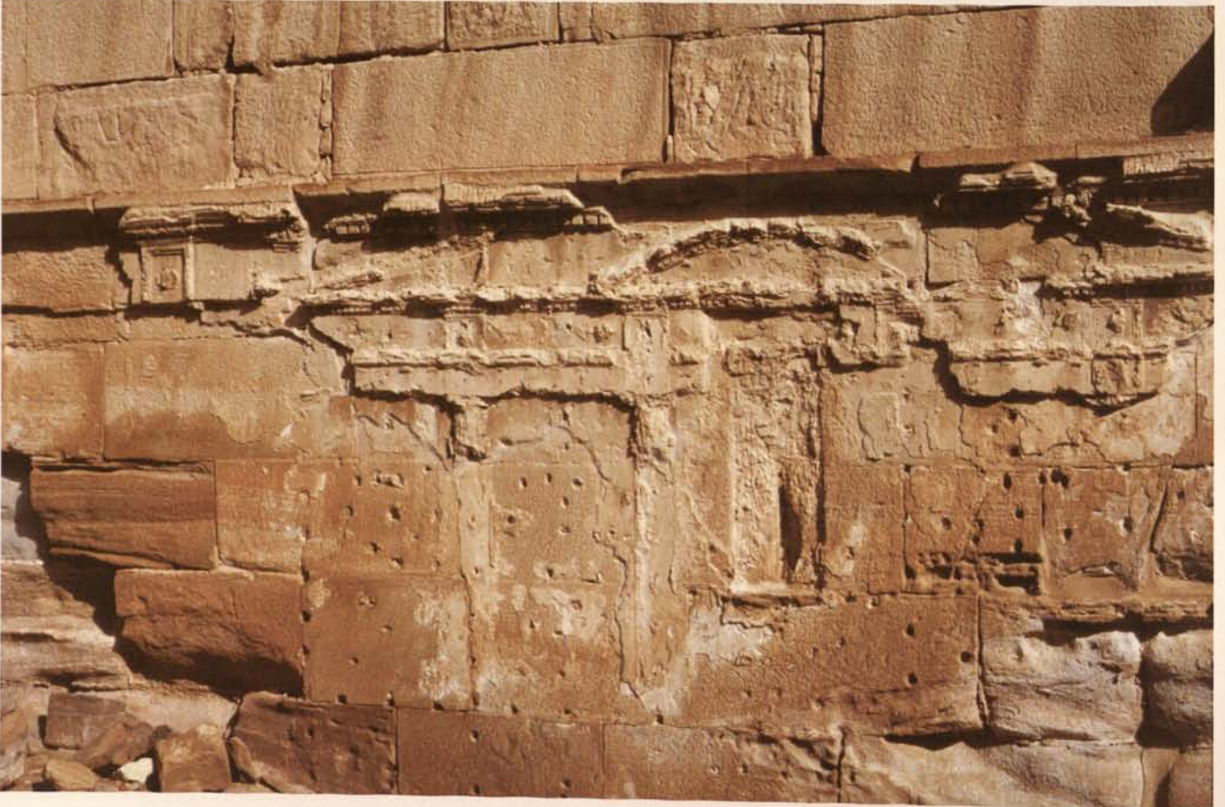
2 Qasr al-Bint, Reste der ehemaligen Stuckierung und die dazu gehörigen Dübellöcher
