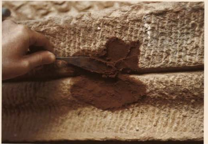
4 Monument 825, Einschußloch, Zwischenzustand, Einmassieren der ersten Mörtelschicht in die Schlämme
