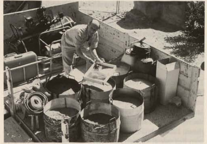
Abb. 9. Farbige Sande zur Herstellung des Reparaturmörtels
