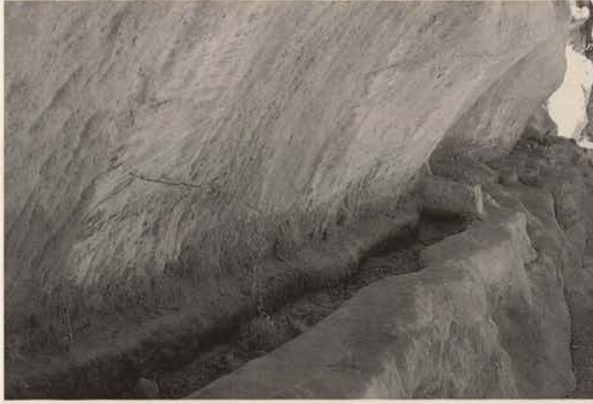
Abb. 15. Siq, in den Fels gemeißelte Wasserleitung mit Deckplatten Fig. 15. Siq, water pipe carved into the rock with covers
