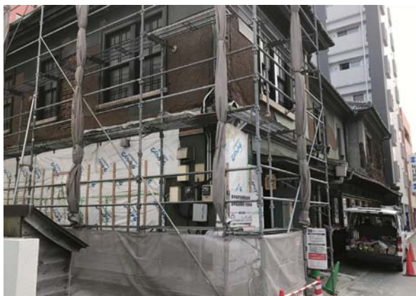
写真 4.2.3 工事中の後藤商店 2018.6.22
