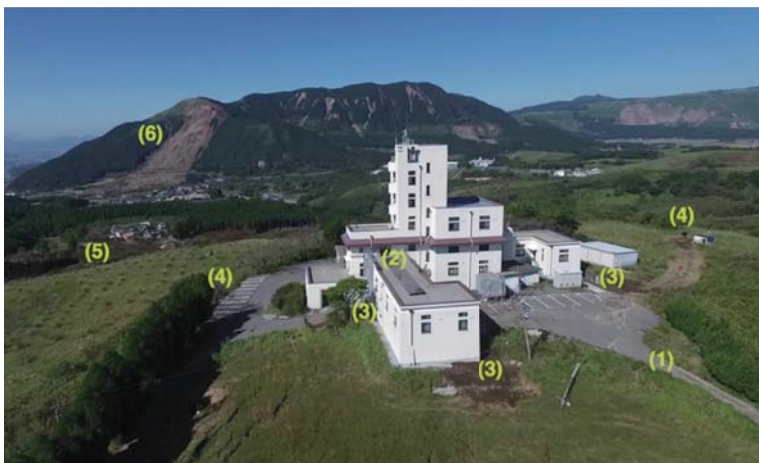
写真 2.15.1 火山研究センターの建物および周辺（2016年10月24日空撮） はるか遠くに島原半島の雲仙普賢岳が見えている。以下、写真中の(1)-(6)の説明。 (1) 2016年7月から8月にかけて、取り付け道路の一部と火山研構内の道路が仮復旧された。これにより、センター建物への普通乗用車でのアクセスが可能になった。 (2) 2016年8月建物の亀裂部からの浸水を防ぐための応急措置が施された。 (3) 2016年9-10月基礎部の被害調査が実施された。 (4) 2016年10月地すべりモニタリングのため、GPS基準点を3箇所に設置し地表変位測定を開始した。 (5) 高野台斜面の地すべり発生場所では国や熊本県により対策工事が計画されている。 (6) 国道57号線、JR豊肥線、阿蘇大橋の崩落場所でも、復旧工事が進められつつある。ただし復旧時期は未定。
