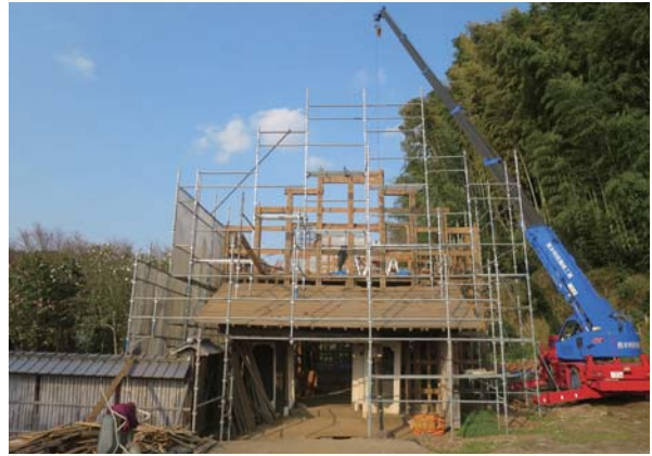
写真 2.3.1.8 矢野家住宅（本宅）・倉の解体中
