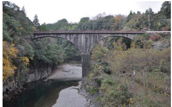
写真 2.18.6.1 轟橋遠景(下流側から) (撮影: 本田、2016.11.29)
