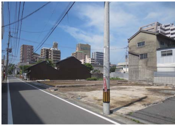
写真 5.3.2 町屋4棟を解体し更地へ(古町)
