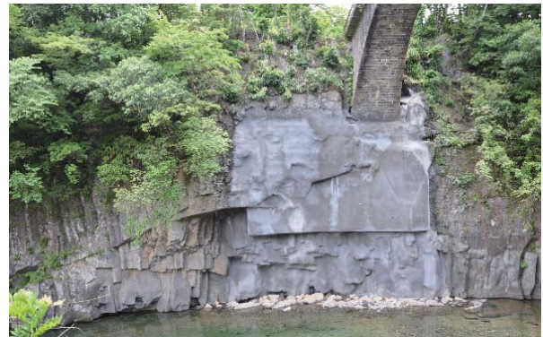
写真 2.18.6.3 復旧後の崩落部(写真右上が橋台) (撮影: 本田、2017.6.4)
