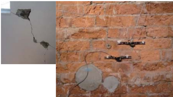
写真 2.12.5 煉瓦壁面の亀裂変位モニタリング
