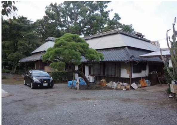
写真 2.9.1 木村家住宅 全景（東南側より）
