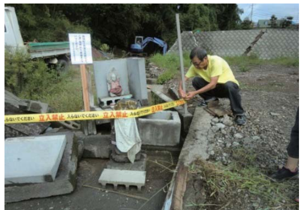
写真 3.4.1 倒壊した地蔵に散逸防止のテープ張
