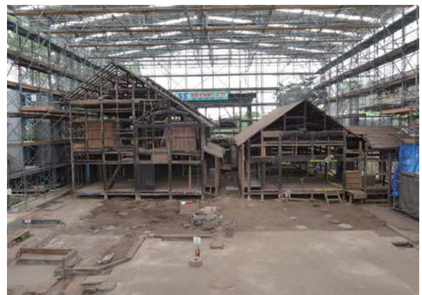
写真 2.2.13 土間棟解体完了
