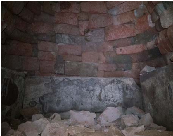
写真 2.19.1 井寺古墳 墳丘の亀裂と石室の被災状況（嘉島町教育委員会提供）
