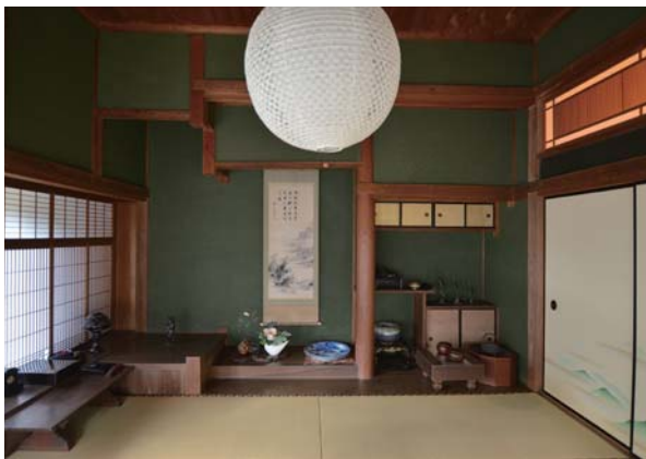
写真 2.3.2.8 矢野家住宅（新宅）・トコの修理完了
