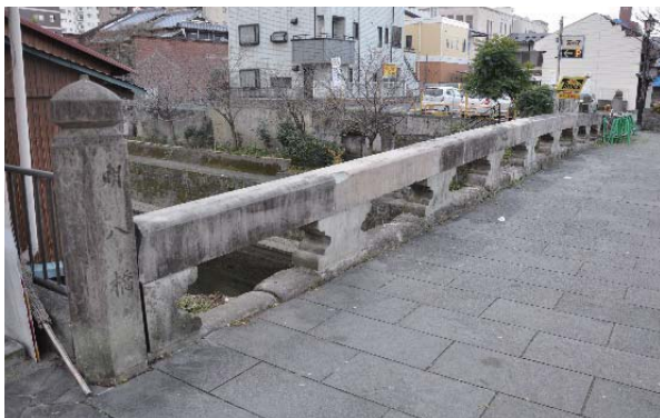
写真 2.18.1.2 復旧後の高欄 (撮影：本田、2017.12.10)
