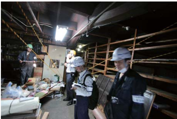
⑮森本襖表具材料店 建物内部の調査
