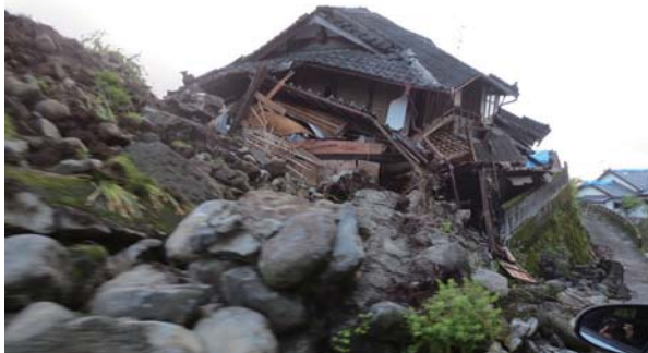
⑪西原村の被災住宅
