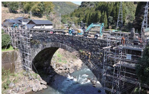
写真 2.18.3.2 復旧作業全景 (撮影: 本田, 2018.03.17)
