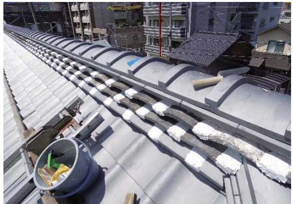
写真 2.6.6 当初の瓦を用いた大棟の復原（主屋）
