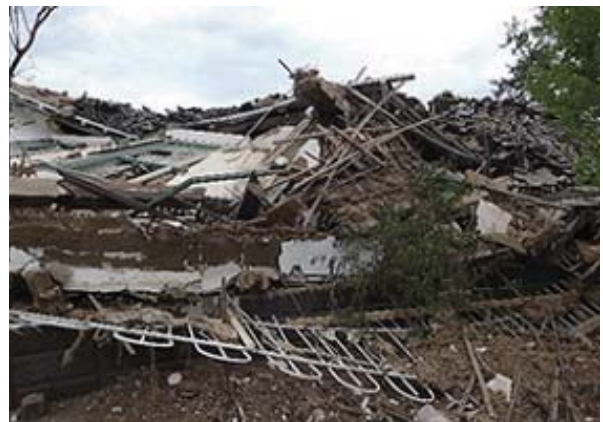
写真 2.5.7 本震で全壊した建物 その2
