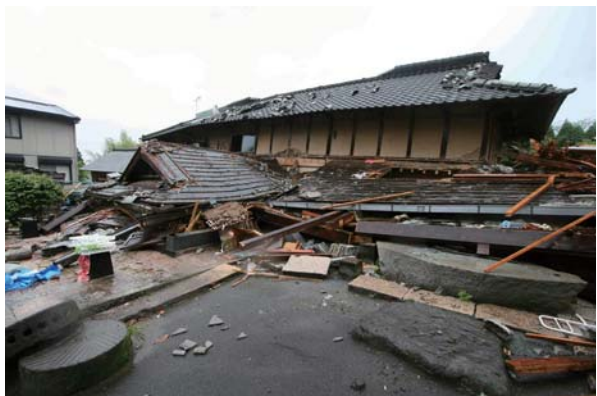
⑦西原村の民家 一階部分が倒壊
