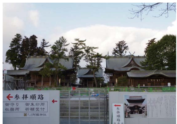
写真 2.4.4 修理の進む神殿群（2018年12月）
