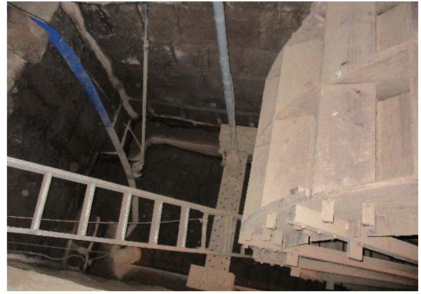
写真 3.5.8 旧中村製粉水車及び石組（被災後動いていない）
