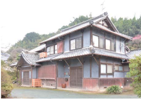
写真 2.3.2.6 矢野家住宅（新宅）修理完了
