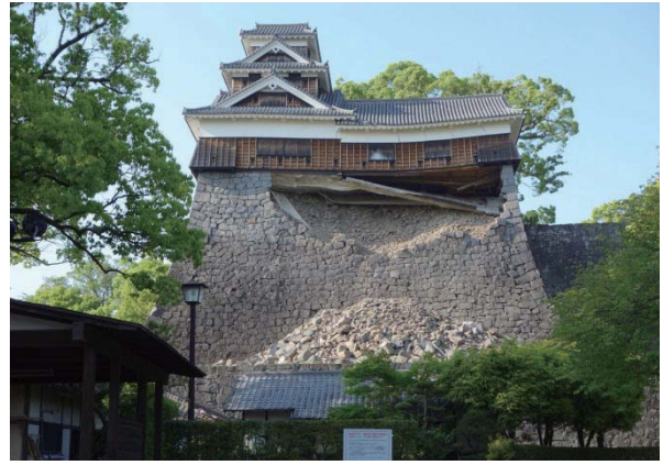
写真 2.1.1.4 飯田丸五階櫓の被災
