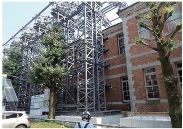
2.13.6 修復のために建てられた鉄骨造素屋根
