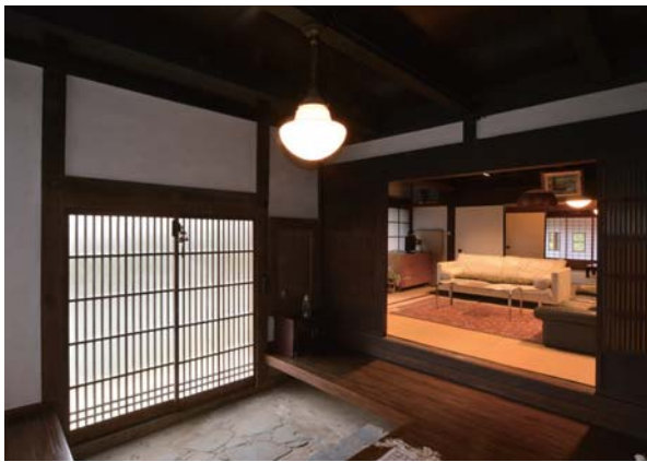
写真 2.3.2.7 矢野家住宅（新宅）・玄関の修理完了
