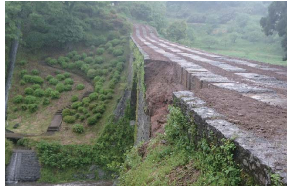
写真 3.7.3 通潤橋の一部崩落（山都町教育委員会）平成 30 年 5 月 7 日昼撮影
