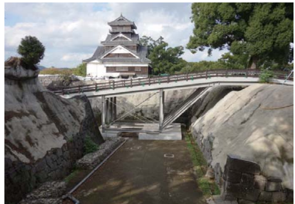
写真 2.1.11 数寄屋丸御門跡の現況と工事用スロープ
