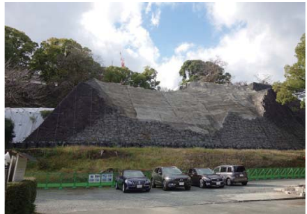
写真 2.1.13 (重文) 東十八間櫓台崩落部分の崩落防止工事後
