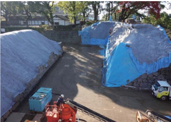
写真 2.1.3 数寄屋丸御門跡の応急処置（北から）
