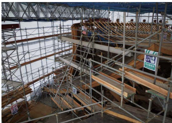
写真 2.4.1 解体途中の楼門（2017年3月）
