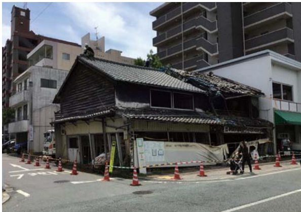
写真 3.1.1 町屋の解体工事 (2017年5月/細工町)
