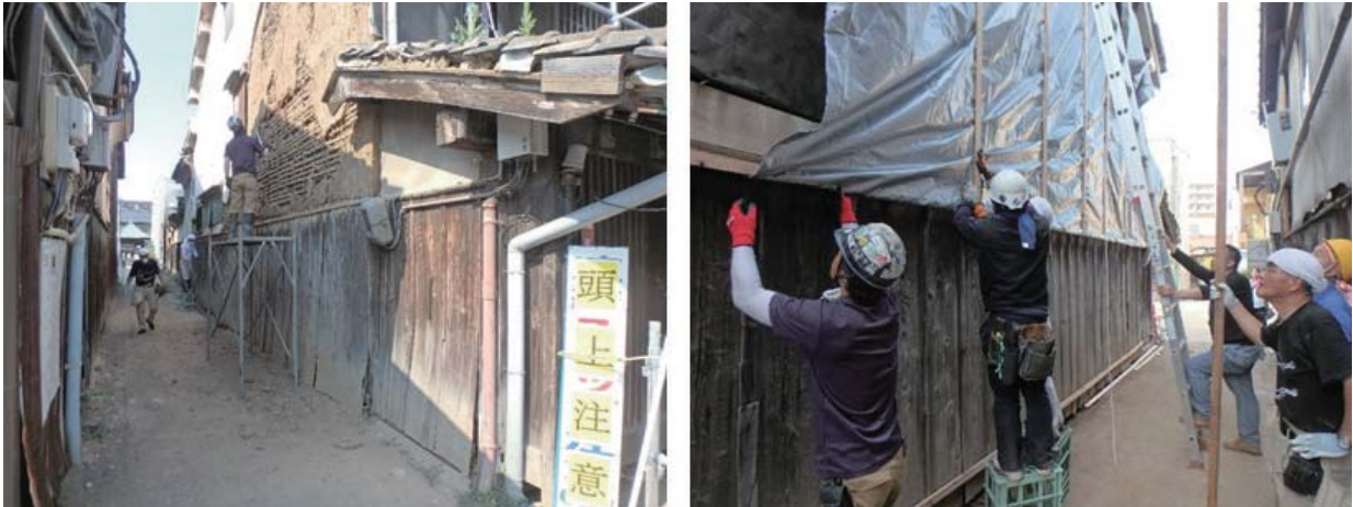
写真 5.1.2 北関東の職人らによるボランティアによって応急処置の様子
