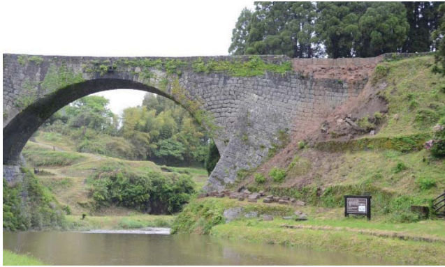
写真 3.7.3 通潤橋の一部崩落（山都町教育委員会）平成 30 年 5 月 7 日昼撮影
