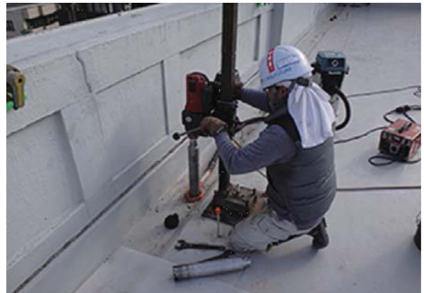
写真 2.12.7 レンガ壁タイバー挿入のための削孔工事
