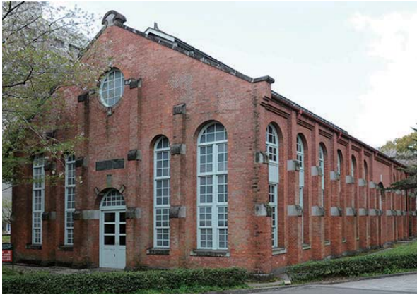
2.13.9 工学部研究資料館（被災前）
