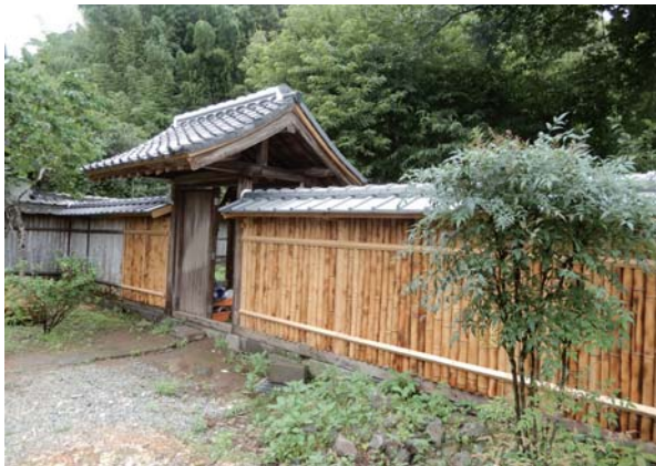
写真 2.3.1.11 矢野家住宅（本宅）・中門と東側塀の修理完了
