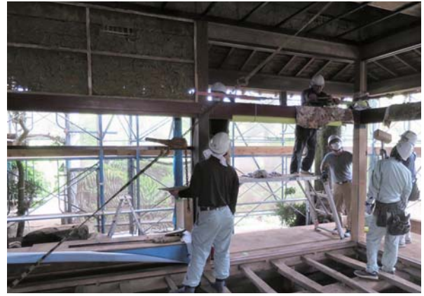
写真 2.2.10 座敷棟建て起こし
