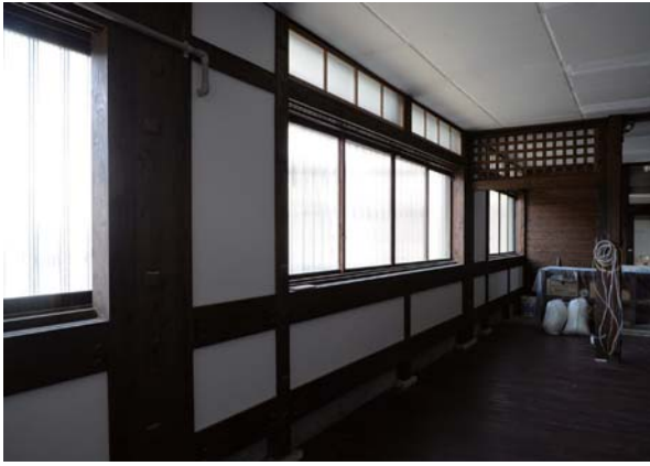
写真 3.2.4 瑞鷹酒造の内部フレームで耐震補強
