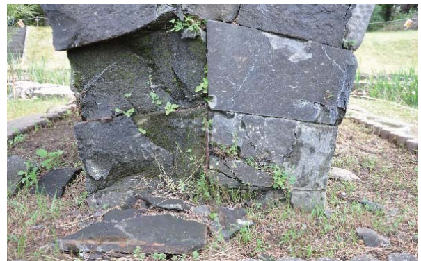
写真 2.18.2.2 橋脚下部の状況 (撮影：本田、2016.09.21)
