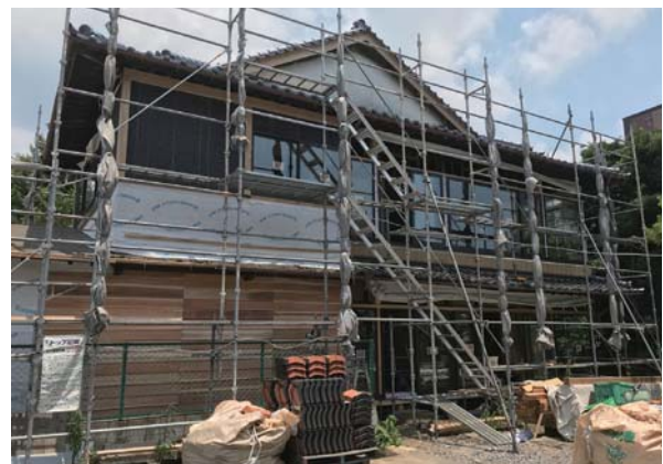
写真 4.2.2 工事中の黒瀬商店 2018.7.12
