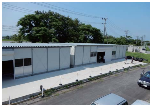
写真 2.5.9 解体運搬され整理保存されたジェーンズ邸部材収蔵庫
