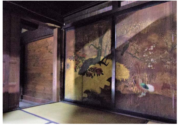
写真 2.6.4 追加した耐震壁（板戸左側）
