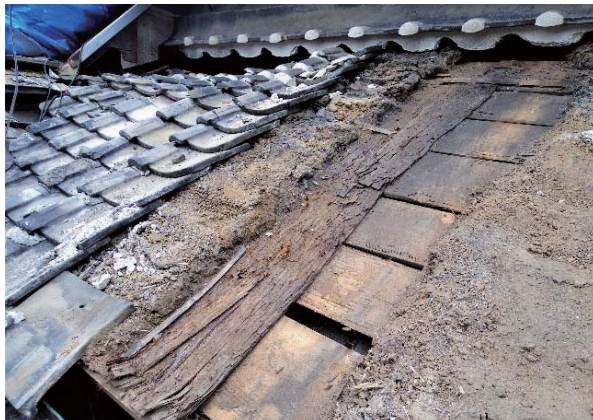
写真 2.6.5 屋根撤去前の原状の記録（主屋南下屋）
