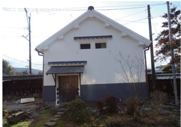
写真 2.3.1.12 矢野家住宅（本宅）・味噌蔵の修理完了
