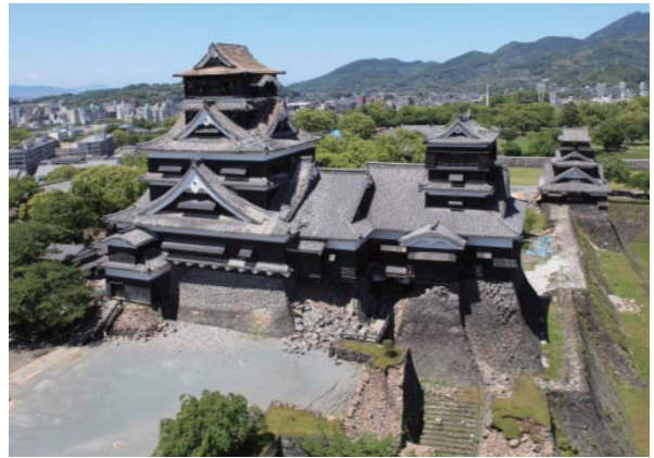
写真 2.1.1 天守の被災状況
