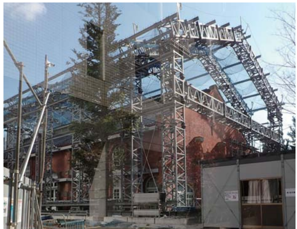
2.1313 修復のための鉄骨造素屋根
