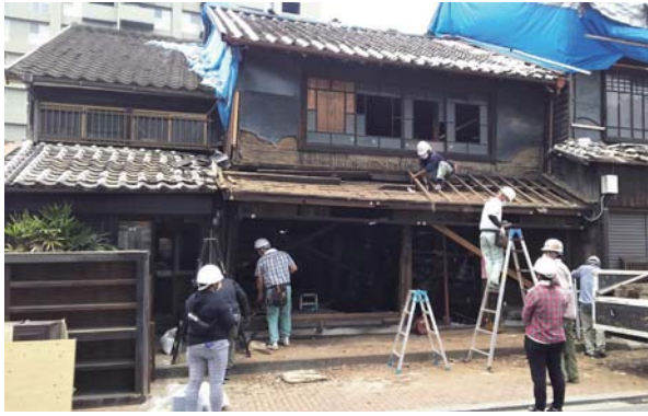
写真 2.7.2 移設のための有志による解体作業
