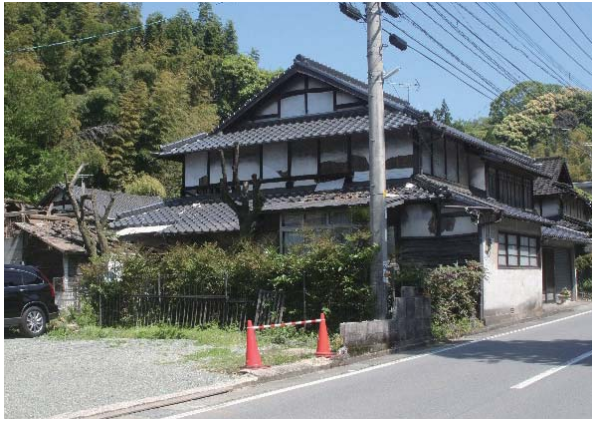
写真 3.5.7 武田邸（被災後）解体済
