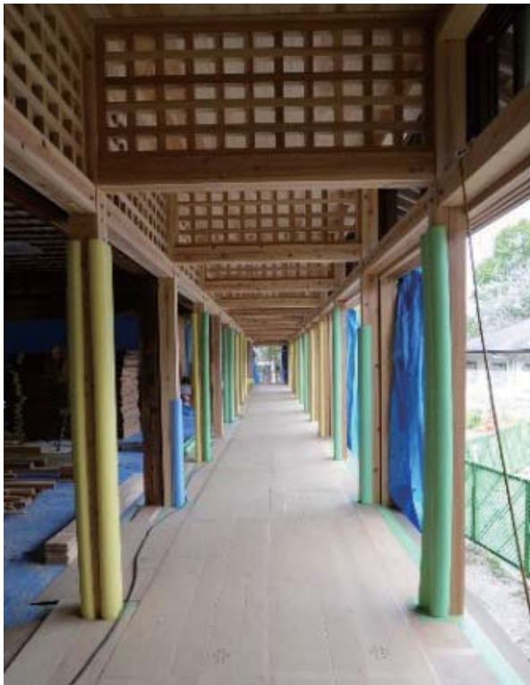
写真 2.11.5 回廊が耐震壁となる
