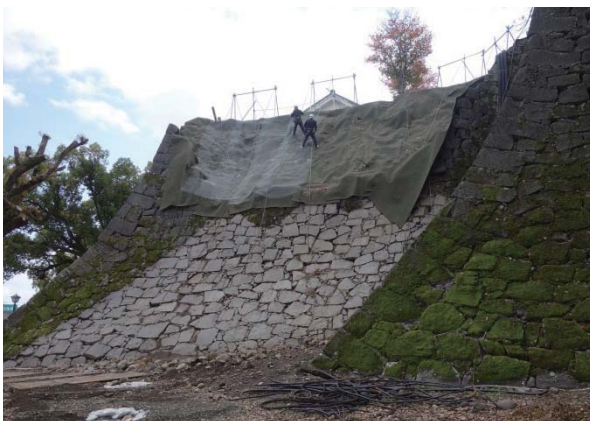
写真 2.1.12 本丸長局櫓跡北側崩落部分の崩落防止工事の様子
