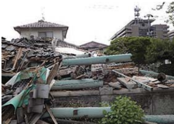
写真 2.5.6 本震で全壊した建物 その1
