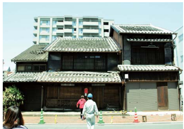
写真 2.7.1 被災直後の正面
