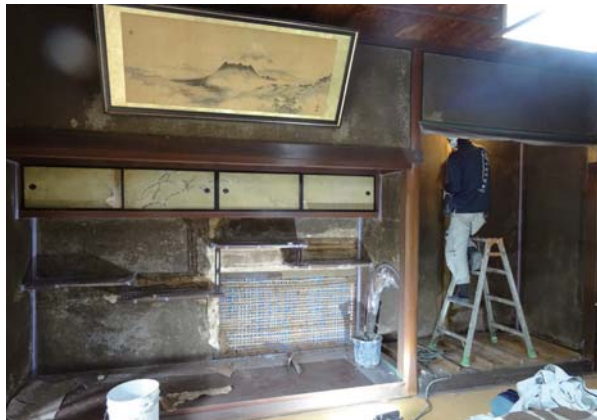
写真 2.3.1.9 矢野家住宅（本宅）・主屋ザシキトコの左官工事
