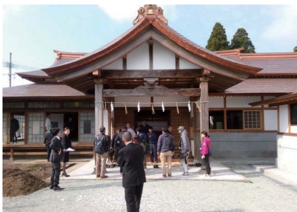
写真 2.4.3 報道公開された修理後の齋館（2018年12月）
