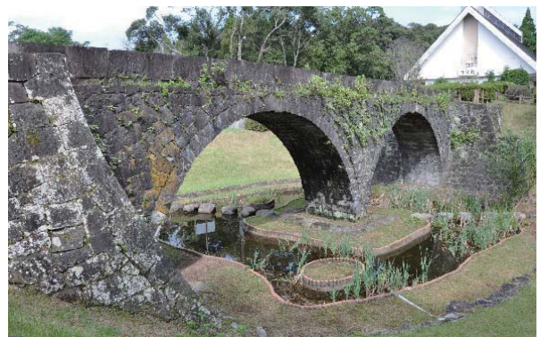
写真 2.18.2.1 大坪水路橋全景 (撮影：本田、2016.09.21)
