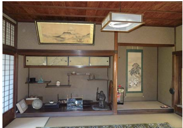
写真 2.3.1.10 矢野家住宅（本宅）・主屋ザシキトコの修理完了
