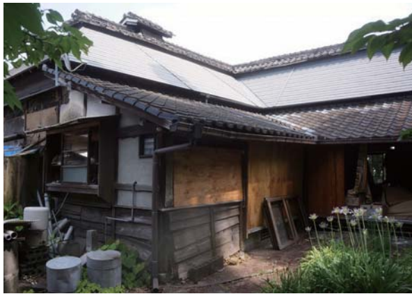
写真 2.9.3 突出する土間部
