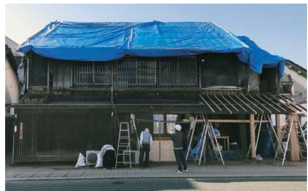
写真 2.10.4 着工後の工事現場 2018.11.6
