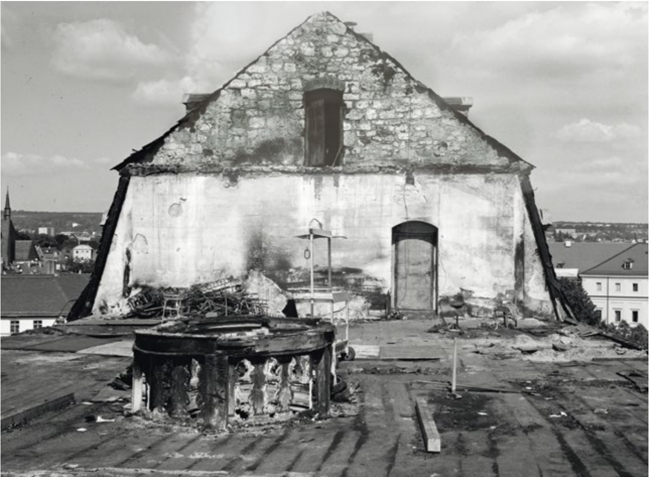
Abb. 2 Sicht auf die geräumte Brandebene nach Norden, 2004
