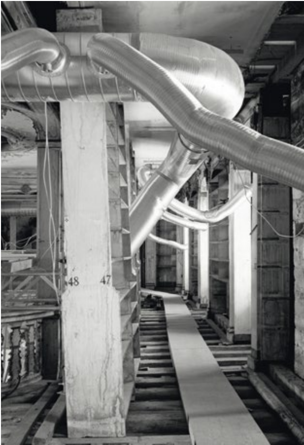
Abb. 5 Rokokosaal, Galerieebene mit ausgebauten Dielenböden und provisorischer Lüftungsanlage, 2004
