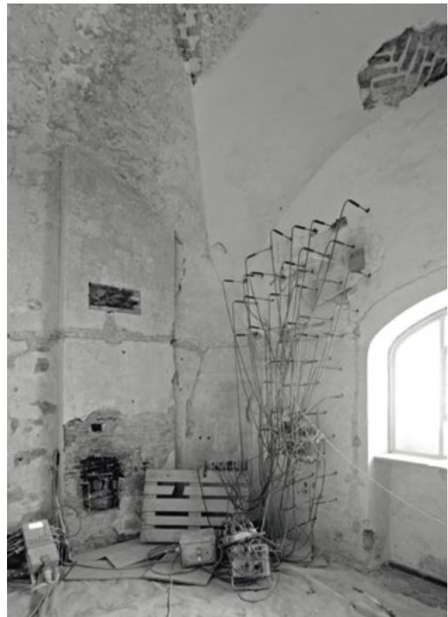
Abb. 6 Westlicher Renaissancesaal, Mauerwerkstrocknung, 2005
