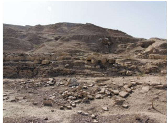
Abb. 4 Unterspülte Bereiche am Quai in Assur
