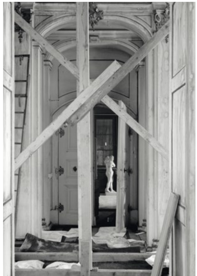
Abb. 3 Notsicherungsmaßnahmen im Rokokosaal, 2004
