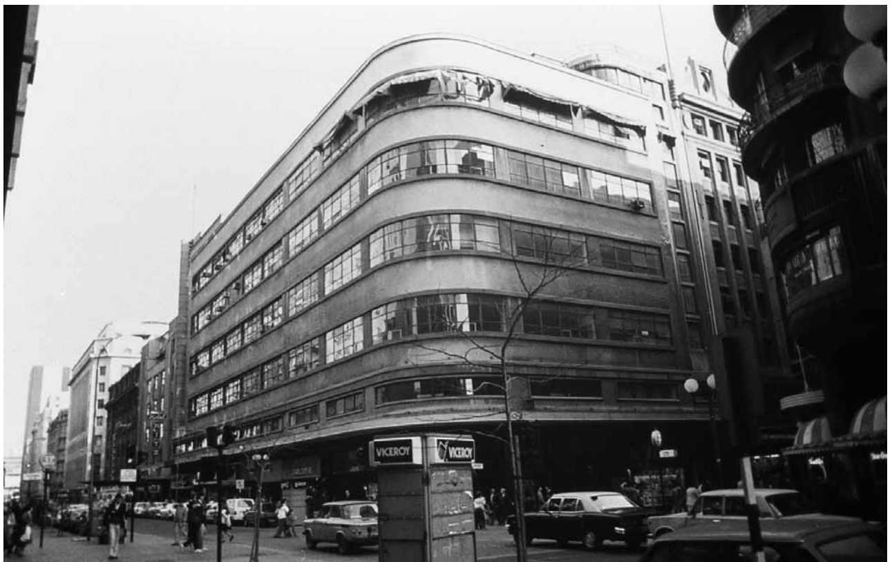
Fig. 1 Santiago de Chile, Edificio Oberpaur
