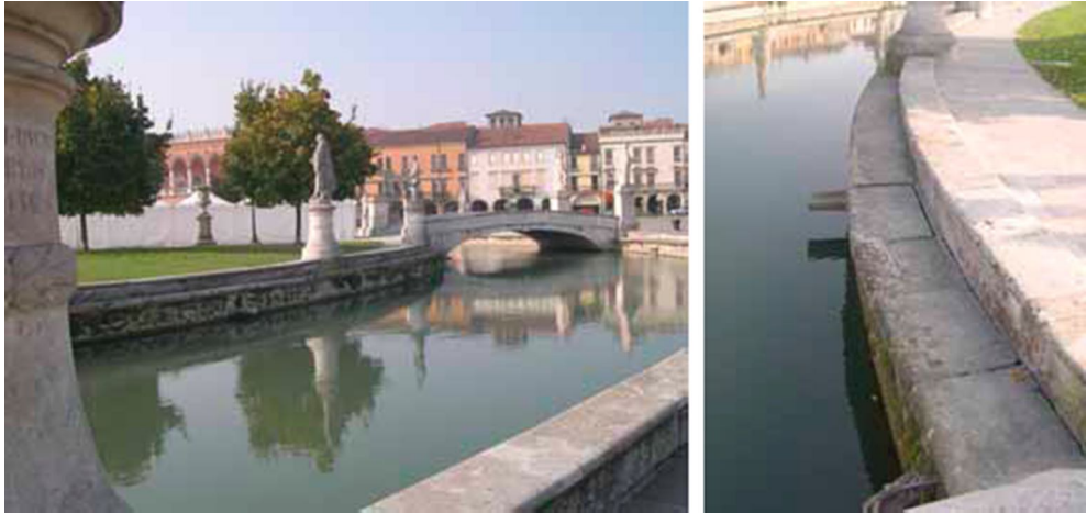
Figura 2.4.: 1985. Restauro di porzione del muro ruotato per la spinta dell'acqua piovana non drenata a causa dei doccioni ostruiti.
