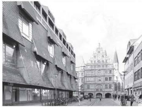
▼ Abb. 3: Blick Poststraße Richtung Gewandhaus heute Foto: Elmar Arnhold
