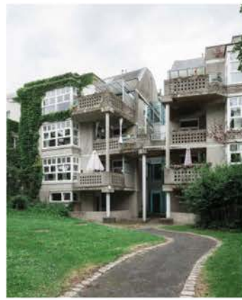
Abb. 7: Gebäude von Hertzberger vor Sanierung, 2017
