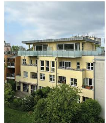
Abb. 10: Gebäude von Patschan-Werner-Winking vor Sanierung, 2023
