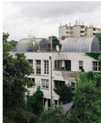
Abb. 9: Gebäude von Patschan-Werner-Winking vor Sanierung, 2017
