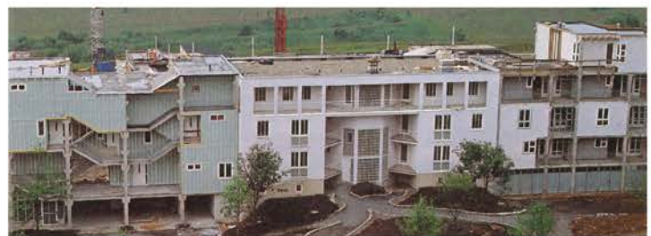
Abb. 12: Luftbild aus der Bauphase, 1982
