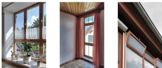
Abbildung 8: Detailaufnahmen [l] Laibung Sonnenwand [m] Risalit [r] Lüftungsklappen
