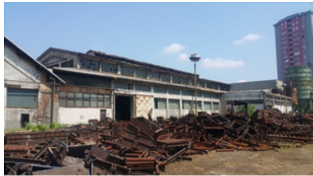
Sl. 4 - Demontaža i rušenje zgrade Livnice čelika izgrađene 1947. godine za potrebe razvoja metaloprerađivačke industrije u Tuzli kako bi se omogućila izgradnja stambeno-poslovnog kompleksa Crystalico (izvor: autor, 2022. godina)
