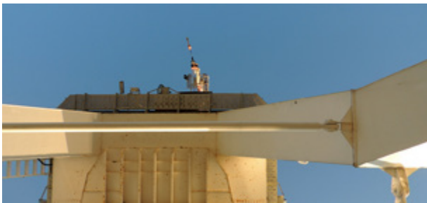
Sl. 3: Kranska dizalica - Porto Montenegro (bivši Arsenal) u Tivtu, simbol - detalj (Izvor: Privatna arhiva)
