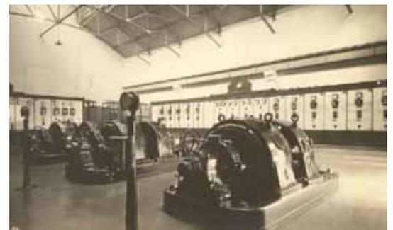
Generador de energía eléctrica, Planta Convertidora, Compañía Fundidora de Fierro y Acero de Monterrey, N.L. México.
