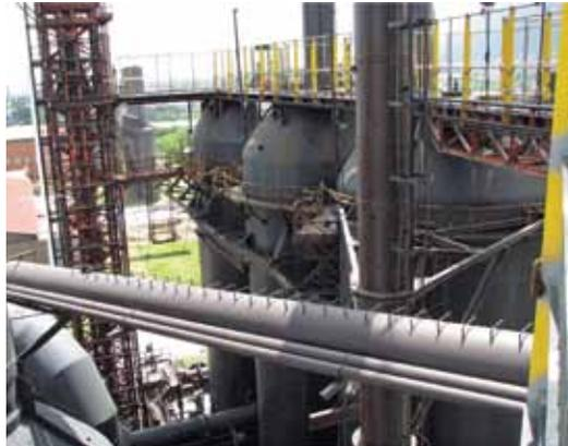
Cuerpo de las tres estufas, el colector de polvos y los lavadores de gases del Alto Horno No. 3. Fotos: cortesía del autor.
