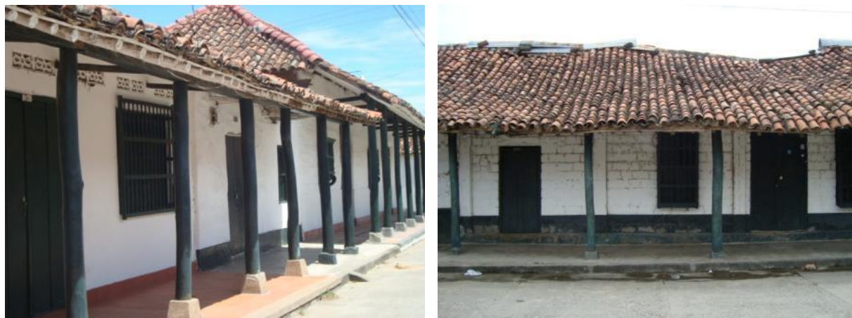
Ambalema: viviendas con pórtico (Foto: Olimpia Niglio, 2012)
