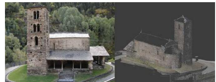
Figura 4: Modelo sintético de la iglesia románica por coloración de la nube de puntos y salidas gráficas.
