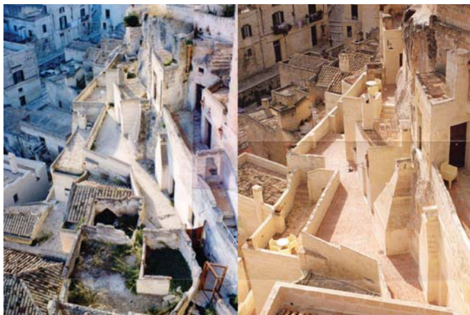
La "Locanda di S.Martino" antes y después de los trabajos de reutilización
