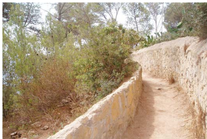
Tramo actual del camino de ronda de Platja d'Aro a Palamós. Fotografia: Albert Pla
