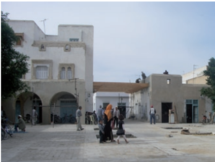
Au cours des travaux
