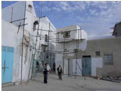
Au cours des travaux
