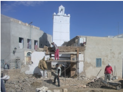
Au cours des travaux
