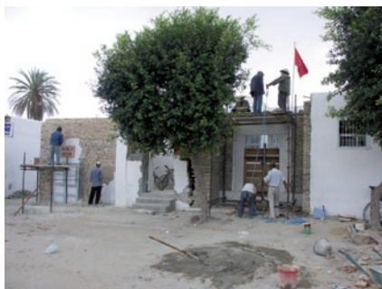
Au cours des travaux
