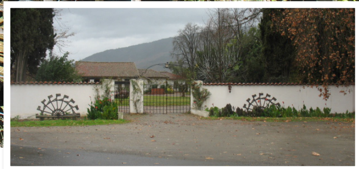
Figura. N°19. Azudas del Salto de Almahue, cuya función es ser más ornamentales que de riego. IHP. 2012.
