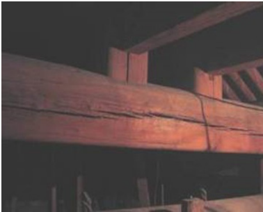
(d) cracked beam
